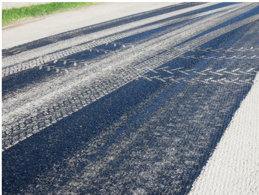
Figur 5: Kjøring på klebing med urent underlag (fresestøv). Foto: Roar Telle
