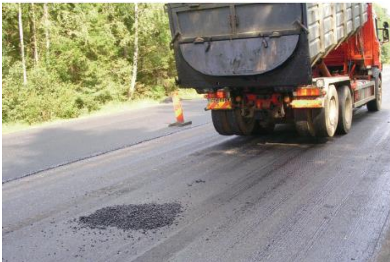
Figur 8: Søl fra bil må fjernes for å unngå senere dekkeskader (slaghull).
