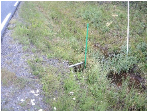
Figur 2. Utløp. Foto KM Reitan
