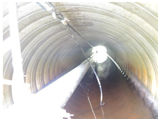
Figur 3. IGS-røret er hengt opp i en vaier som er spent opp i toppen av stikkrenna. Foto: KM Reitan
