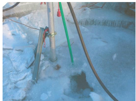
Bilder fra inn- og utløp under tining av HW 1 i Beisfjord 20/2-14. Foto: Lars-Olaf Bratland, Mesta
