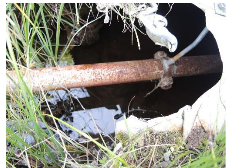
Rustutslag og nedkjørt adapter. Begge foto: Knut Magne Reitan
