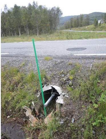
Figur 2. Utløp. Foto KM Reitan
