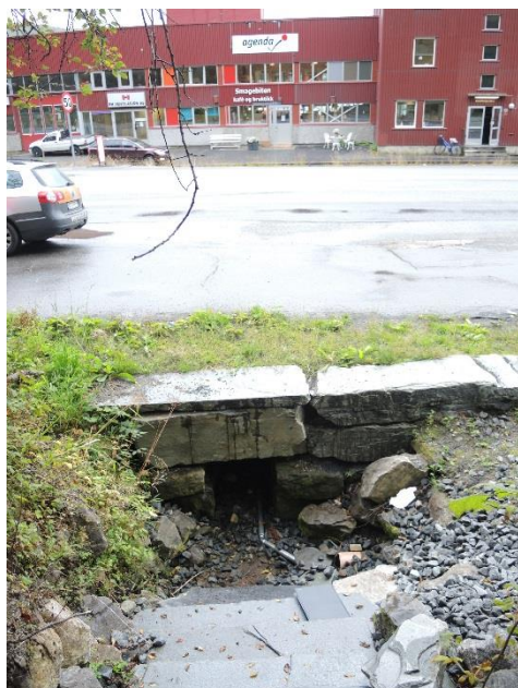
Figur 2. Overgang mellom lukket drenering og murt stikkrenne. Foto KM Reitan
