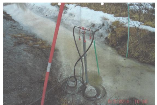
Slangekeveil for å få større åpning. Foto: Arnulf Framvik, Mesta
