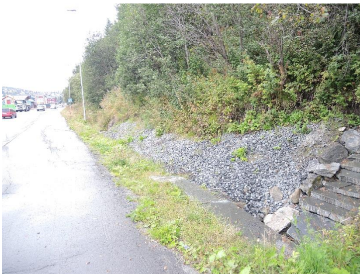
Figur 3. Lukket drenering med IGS-rør fra gangvegskilt til stikkrenna i nedre billedkant. Foto: KM Reitan
