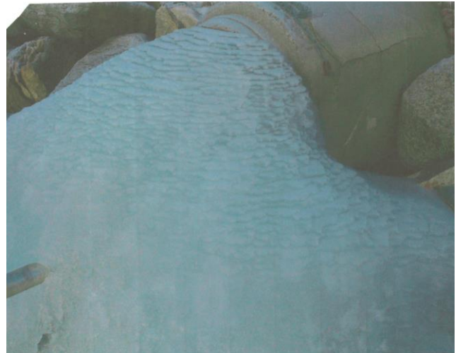
Typisk situasjon ved utløp av stikkrenner. Foto: Lars-Olaf Bratland, Mesta
