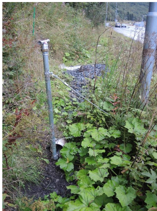
Figur 3. Oppstikk med adapter ved innløpet av den lukkede dreneringen. En kumrist skimtes i bakgrunnen. Foto KM Reitan
