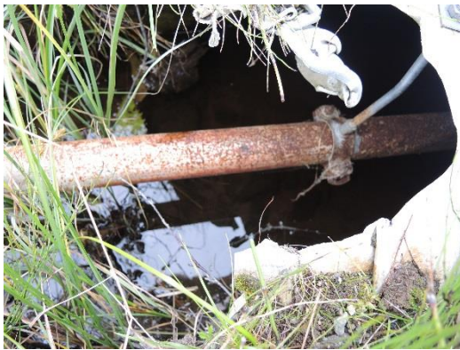
Figur 3 Rustutslag på IGS-rør. Foto KM Reitan
