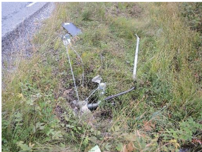
Figur 1. Nedkjørt oppstikk med adapter. Foto KM Reitan
