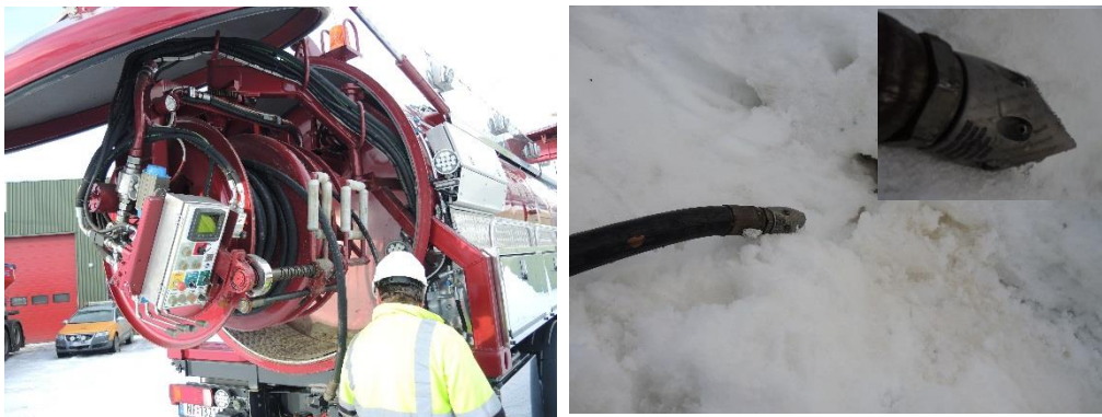
Figur 4, 5 og 6: Utstyr for høytrykkspyling . Alle foto KM Reitan
