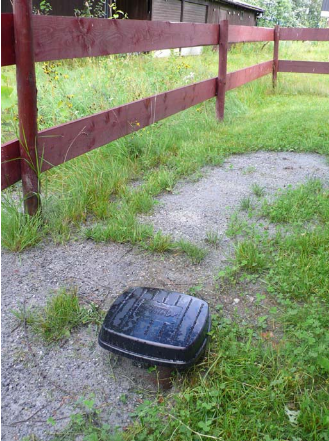
Figur 19. Bilde av den brønntoppen til ny borebrønn.
