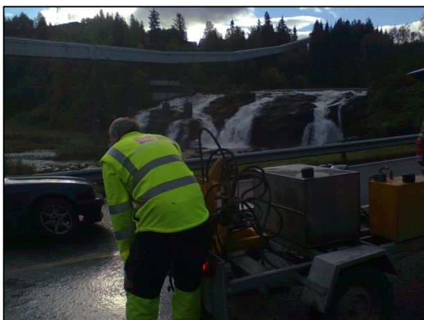
Figur 16. Bruk av borvogn ved Mo i Rana
