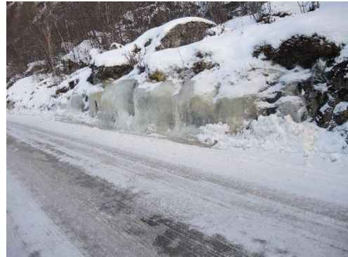
Figur 7 Is i skjæring og grøft. Foto: Knut Magne Reitan, Siving. Reitan AS
