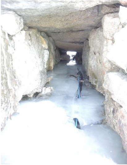
Figur 3. Varmekabel i stikkrenne. Foto: Knut Magne Reitan, Siving. Reitan AS
