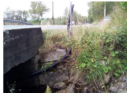
Figur 5 Rør for å lede stimslangen inn i renna. Foto: Knut Magne Reitan
