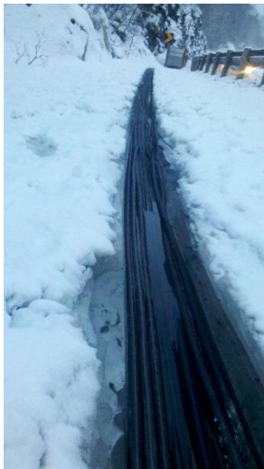
Figur 10 Åpning av grøft med IGS-metoden. Foto: Karl Olav Dahlberg, Mesta
