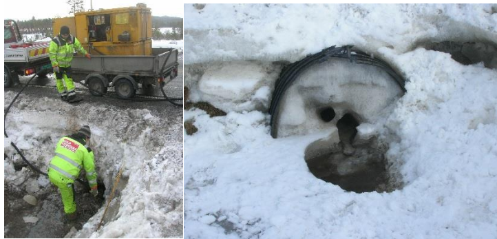
Figur 6 Tining av stikkrenne med stim. Åpning etter utført stiming. Foto: Knut Magne Reitan, Siving. Reitan AS
