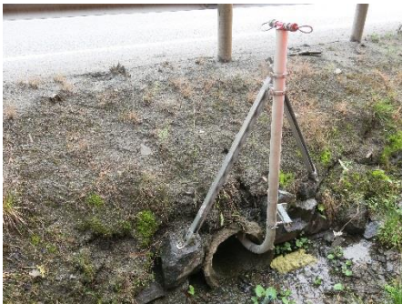
Figur 4 IGS-installasjon i stikkrenne. Foto: Øystein Larsen, Statens vegvesen
