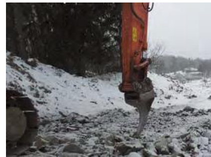
Figur 9 Gravemaskin med rippertann. Foto: Knut Magne Reitan, Siving. Reitan AS
