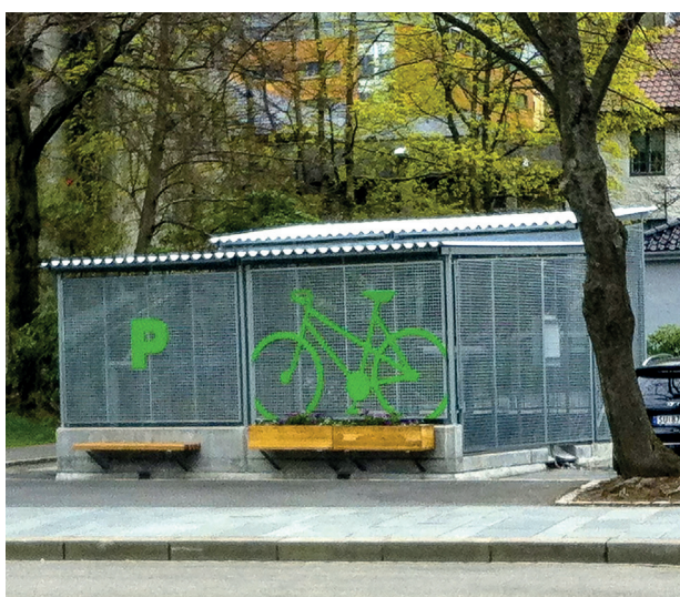
Overdekket sykkelparkering med gittervegger utenfor Bergen rådhus. Foto: Anja Wannag
