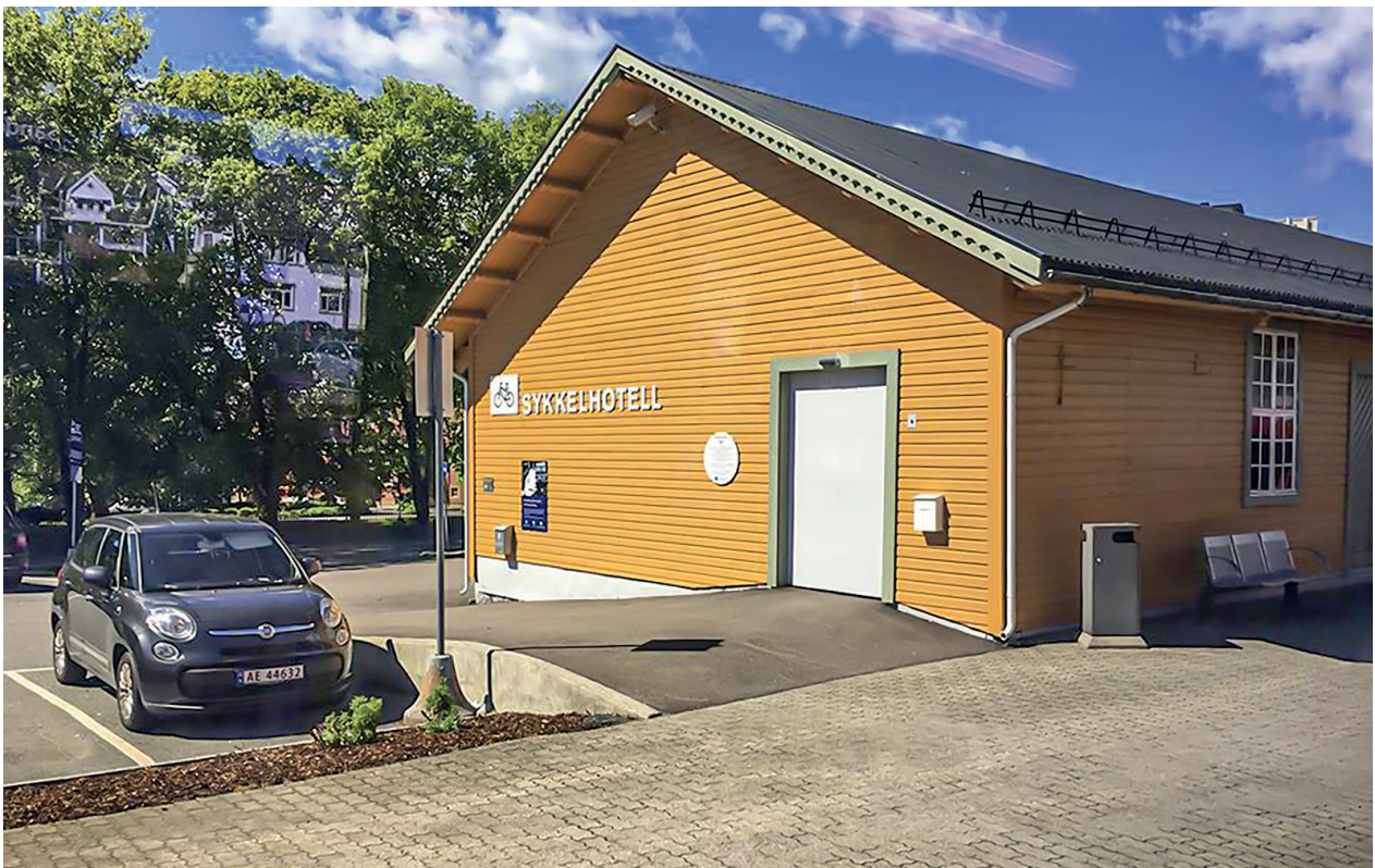
Den gamle godsbygningen ved jernbanestasjonen i Sandefjord er gjort om til sykkelhotell. Foto: Hege Herheim
