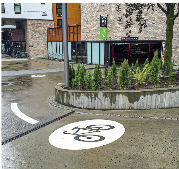
Innendørs sykkelparkering i parkeringshus for både sykler og biler på Vulkan i Oslo. Foto: Karunya Yogarajah
