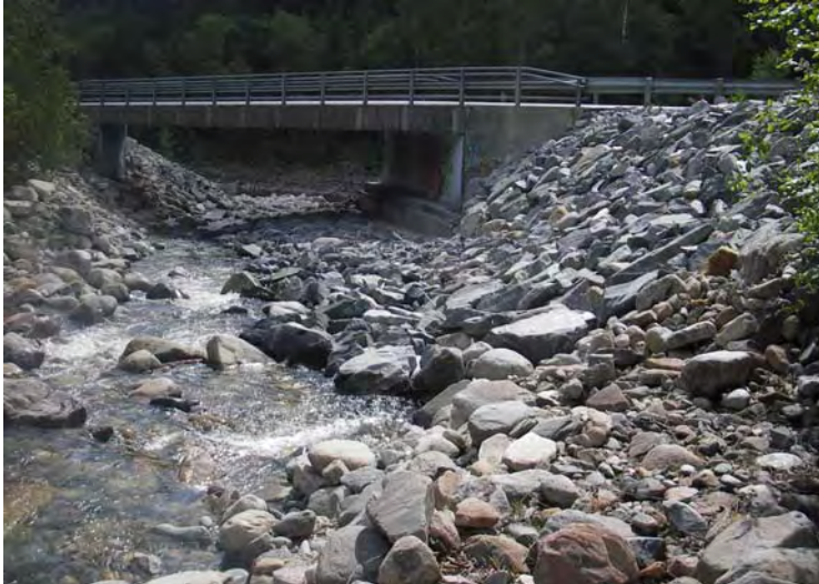
Fig. 7: Middøla bru sett fra oppstrøms side. Fyllingene i elveskråningene er tydelige.
