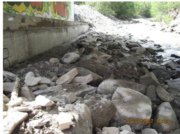
Høyre landkar etter reparasjon
