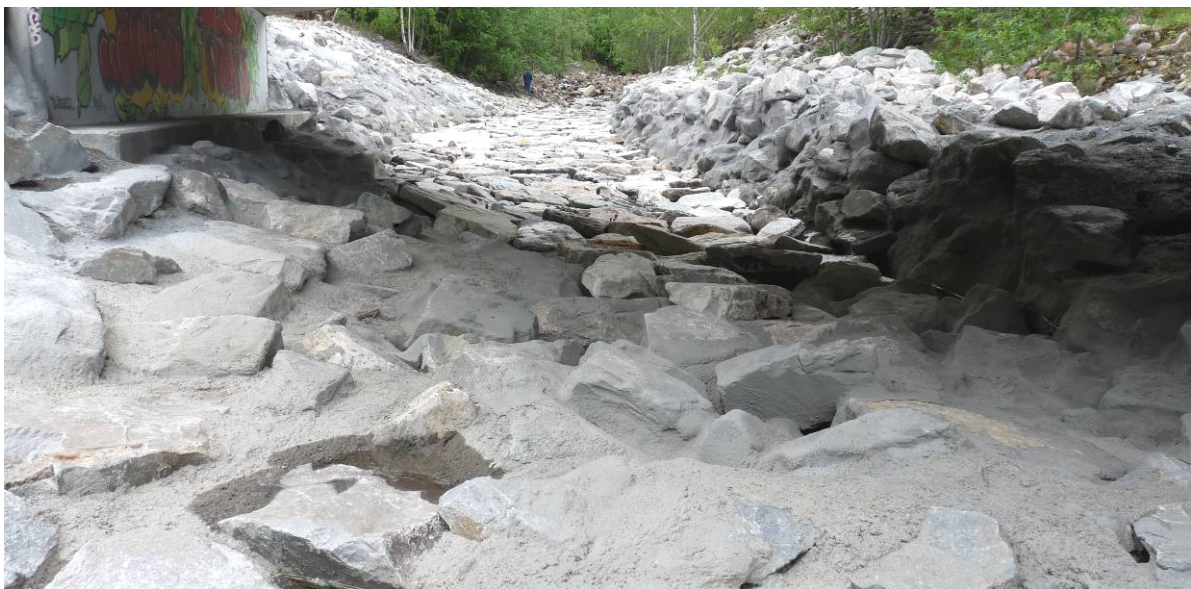
Figur 7 Middøla bru mot oppstrøms, sikring av gjennomløpet, juni 2009
