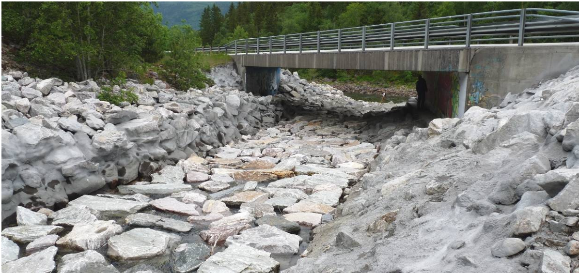
Figur 6 Middøla bru, ny sikring, juni 2009
