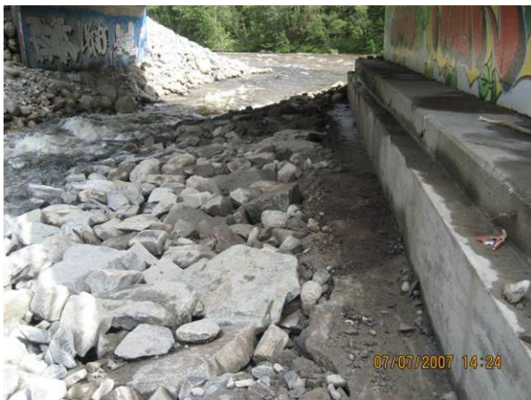
Gjennomløpet etter reparasjon
