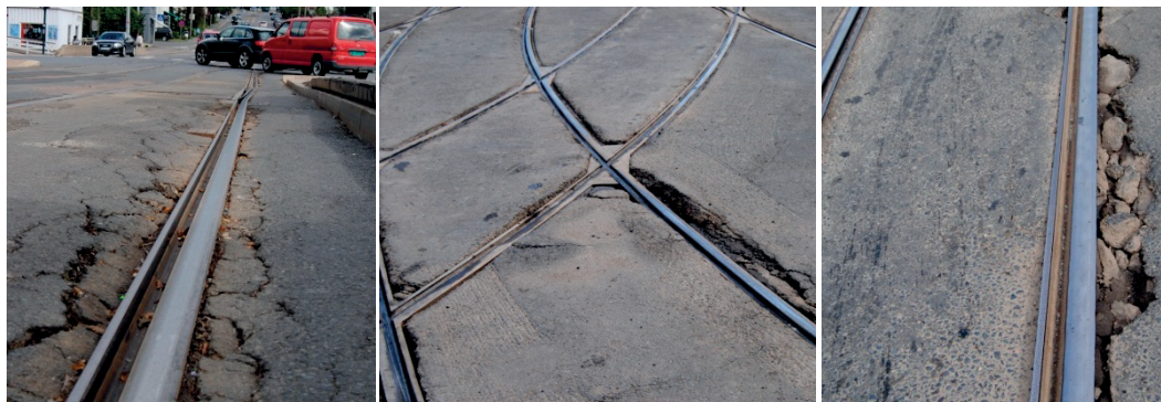
Figur 6.3. Hullet dekke langs trikkeskiner (Foto: M. Sørensen).
