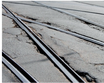
Figur 6.28. Dekke ved trikkeskinner (Foto: M. Sørensen).
