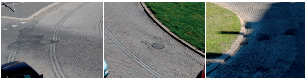
Figur 6.44. Ujevn og hullet dekke (Foto: M. Sørensen).
