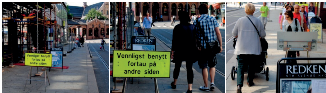
Figur 6.24. Fasaderenovering i Storgata (Foto: M. Sørensen).
