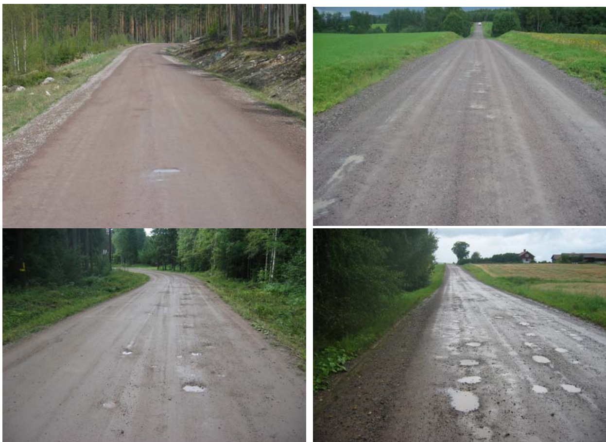
Figur 3: Tilstandsklasser 1-2-3-4 for slaghull; 1- 2 øverste ruter, 3-4 nederst.
