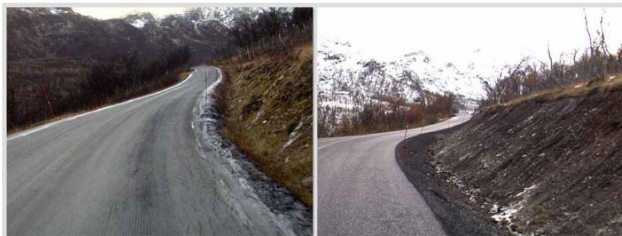
Figur 20: Eksempel på bedring av drensgrøft og betydning av dårlig drenering på veg med fast dekke. (Berntsen og Saarenketo 2005)
