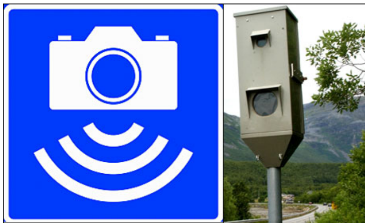
Figur 2: Fotoboks brukt til automatisk trafikkontroll
