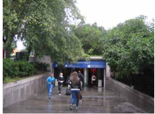
Vegetasjon dekker over skilting ved inngang til t-banestasjonen.
