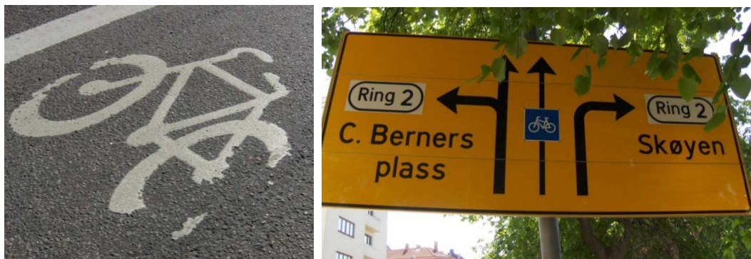
Figur 14. Nedslitt sykkelsymbol i midtstilt sykkelfelt og skilting av midtstilt sykkelfelt i Middelthunsgate (Foto: M. Sørensen).
