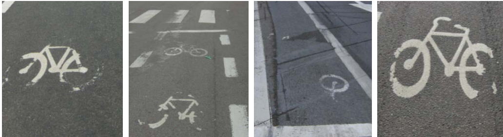
Figur 48. Oppmerking av sykkelsymbol og linjer i midtstilt sykkelfelt i kryss 1, 3, 4 og 5. Oppmerkingen i kryss 5 er bare ½ år gammel (Foto: M. Sørensen).
