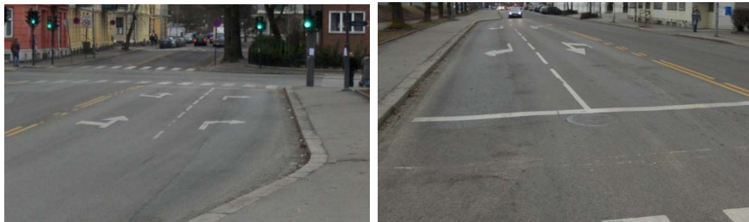
Figur 12. Krysset før midtstilt sykkelfelt ble oppmerket (Foto: M. Sørensen).
