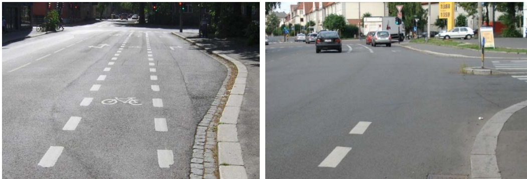
Figur 1. Midtstilt sykkelfelt i krysset Middelthunsgate – Kirkevegen der syklene skal fortsette rett frem og krysset Kierschowsgate – Kirkevegen, der syklene skal krysse bilenes kjørefelt for å komme fra høyre vegside ut midt i vegen (foto: M. Sørensen og R. Phillips).
