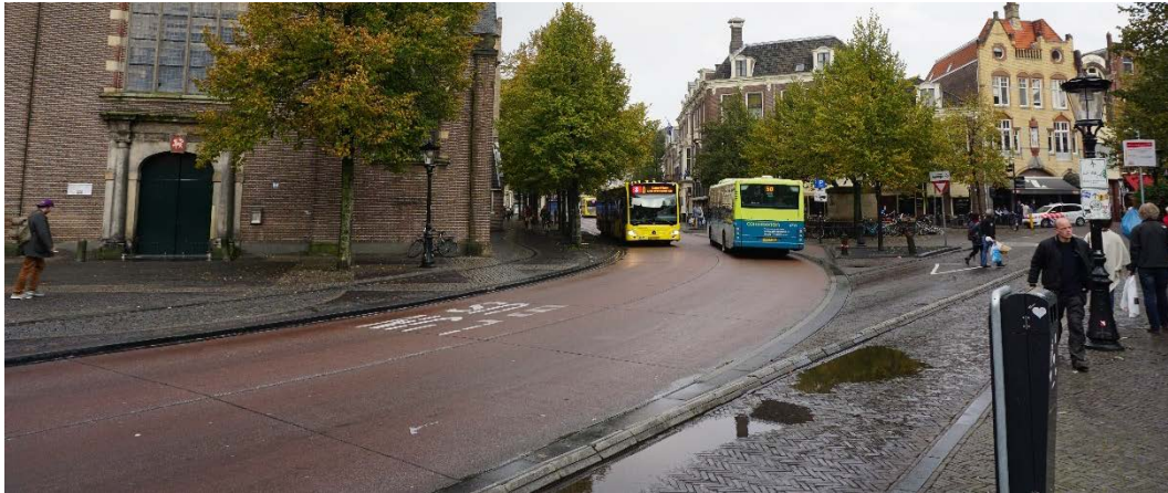
Bilde 2 I Utrecht i Nederland er busstraséen markert med rød asfalt. Dette er en form for prioritering i gaterommet. I kryss gjør forskjellig farge på dekket at det er lett for trafikantene å se at de er i ferd med å krysse busstraséen. Det er (med noen unntak) ikke tillatt for andre enn buss å kjøre i busstraséen.
