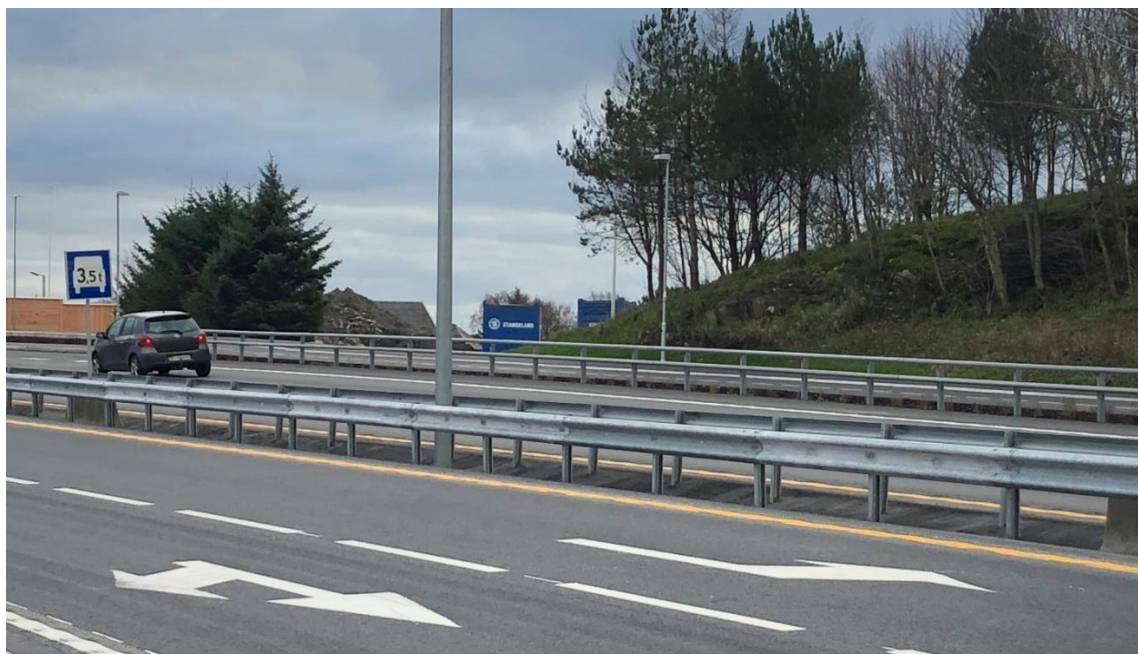
Figur 4-7: Sideplassert skilt (skilt 506) lengst til venstre i bildet. Foto: Statens vegvesen. Skiltet står der hvor tungtrafikkfeltet starter i vest.
