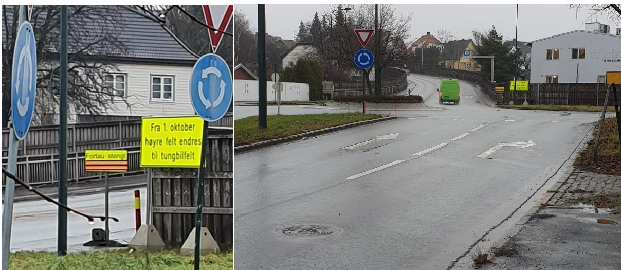
Figur 4-15: Bilder fra befaring 26.11.19. Venstre: Opplysningsskilt ved utkjøringen av rundkjøringen Odd Fellow. Høyre: Stiplet merking i veibanen inn mot rundkjøringen Odd Fellow.
