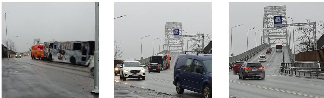
Figur 5-6: Tungt kjøretøy ligger i ordinært kjørefelt i den krappe svingen før kjøretøyet skifter til tungtrafikkfeltet over Fredrikstadbrua.
