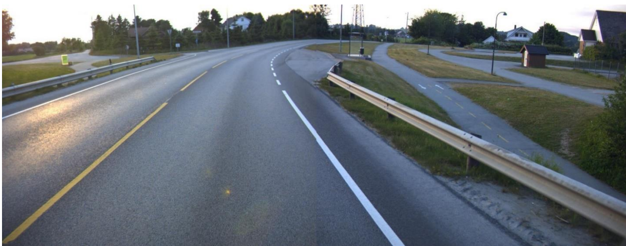
Figur 4-2: Rv. 509 ved krysset med Sola skole i 2010, sett mot vest. Kilde: Statens vegvesen, vegbilder.
