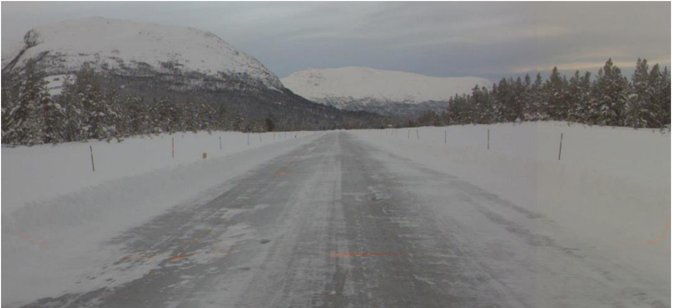
Figur 3: Føreforhold ved felt 6 og 16, 7 og 17 før feltutlegging (felt 6 og 7 på venstre side, felt 16 og 17 på høyre side).
