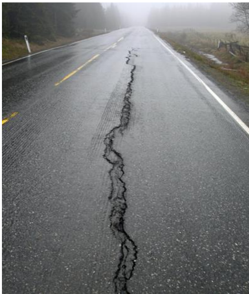
Figur 9.26 Telesprekk utenfor midtlinjen (Foto: Statens vegvesen)
