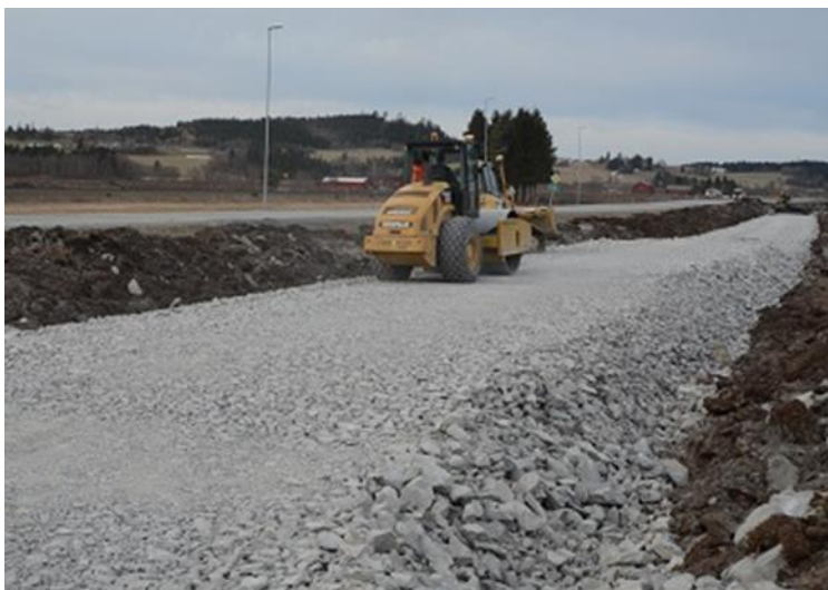
Figur 5.35 Forsterkningslag av pukk og kult, prosjekt E6 Mære-Vist 2014 (Foto: Statens vegvesen)
