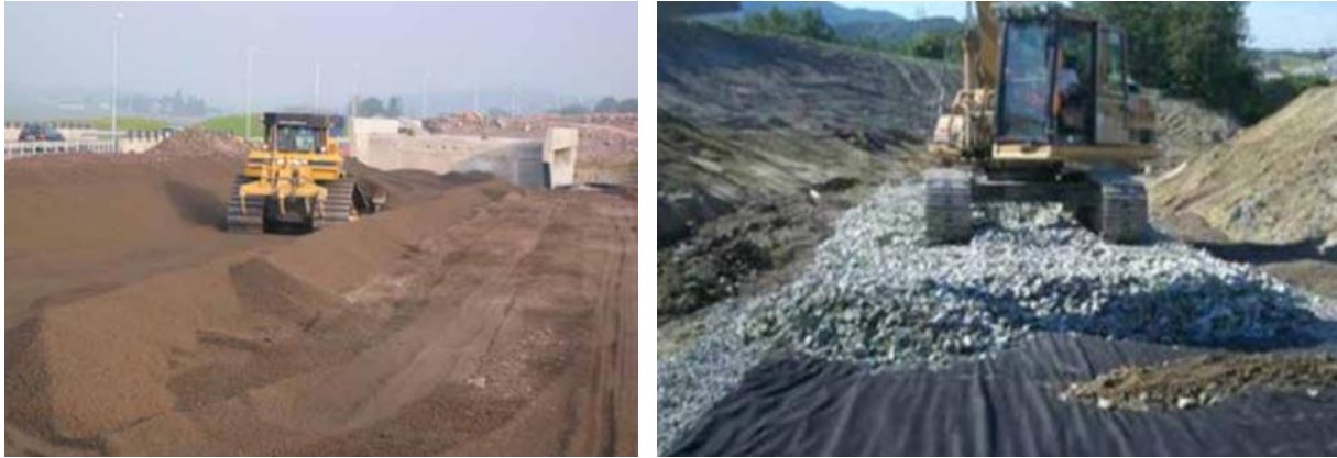
Figur 3.15 Eksempler på fyllinger med lette masser. T.v. lettklinker ved E18 Gulli (Foto: Jon Hauge). T.h. utlegging av skumglass med lett gravemaskin ved E6 Melhus (Foto: Statens vegvesen). /4/
