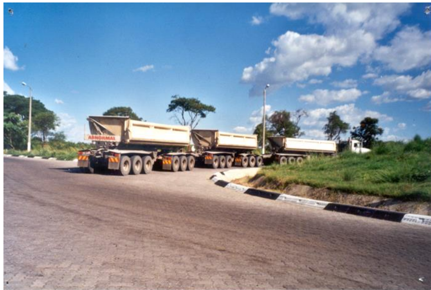
Figur 7.16 Rundkjøring der belegningsstein er brukt på grunn av en stor andel tunge kjøretøyer, Zimbabwe (Foto: Rolf Johansen)
