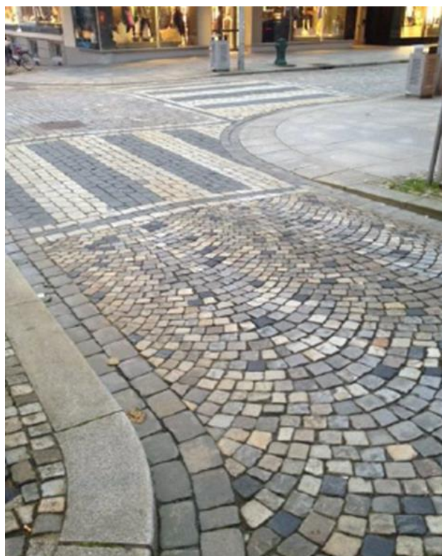
Figur 7.17 Steindekke med gatestein i Bergen (Foto: Rene Kierstein)
