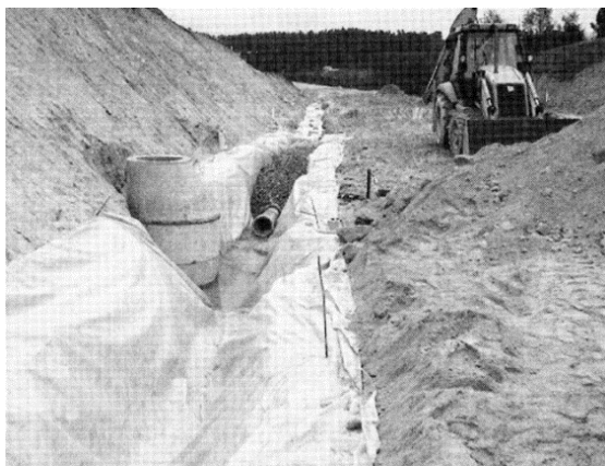
Figur 11.18 Etablering av lukket drenering på nytt veganlegg /10/ (t.v.). Lukket drensgrøft med tetningssjikt for overvann (t.h.)
