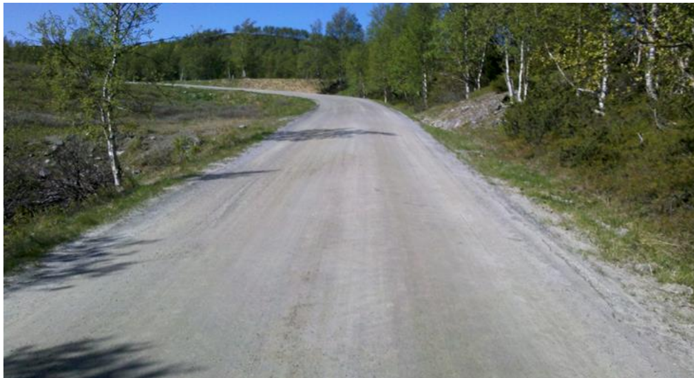
Figur 11.34 Selv om en veg fungerer godt som en grusveg, er det behov for forsterkning dersom den skal gis et asfaltdekke. Grusveg fra Laudalen i Ål, Buskerud. (Foto: Jonas Orset)
