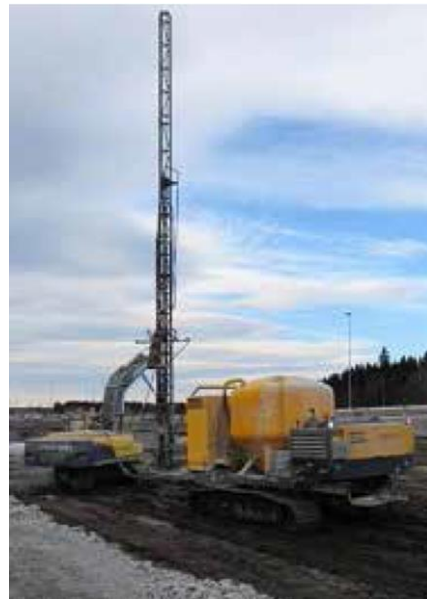
Figur 3.18 Installasjon av kalksementpeler. Prinsippkisse (t.v.) og bilde av rigg som setter kalksementpeler på E18 Vestfold /4/
