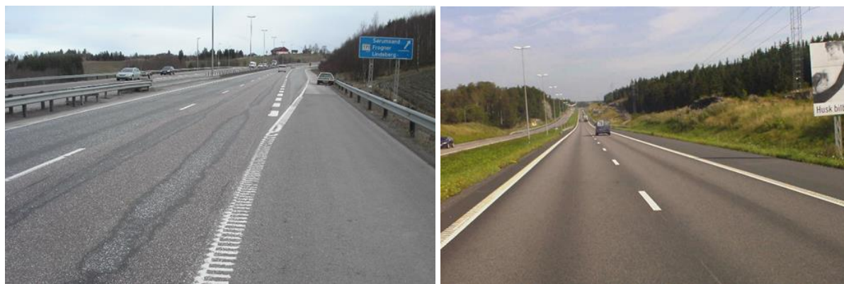
Figur 6.62 Skjelettasfalt er egnet på vegger med høy trafikk, hovedsakelig for ÅDT > 5 000. T.v. E6 Akershus, t.h. E6 Østfold (Foto: Statens vegvesen)
