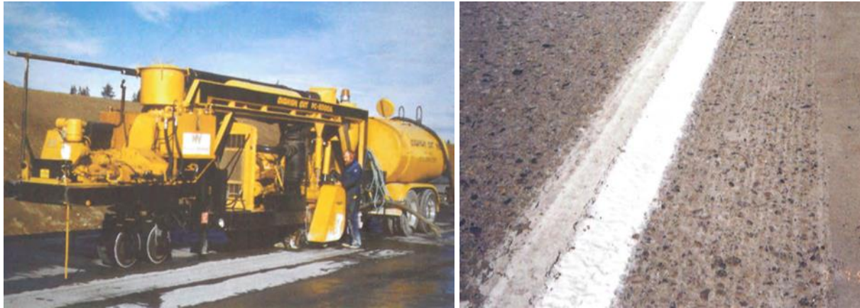
Figur 7.15 Diamantslipemaskin i arbeid (t.v.) og slipt betongdekke (t.h.) /2/
