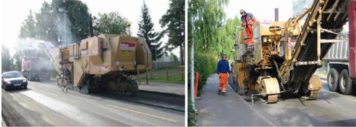
Figur 6.105 Asfaltfresing; traufresing (t.v.) og planfresing (t.h.) (Foto: Arvid Jordet)
