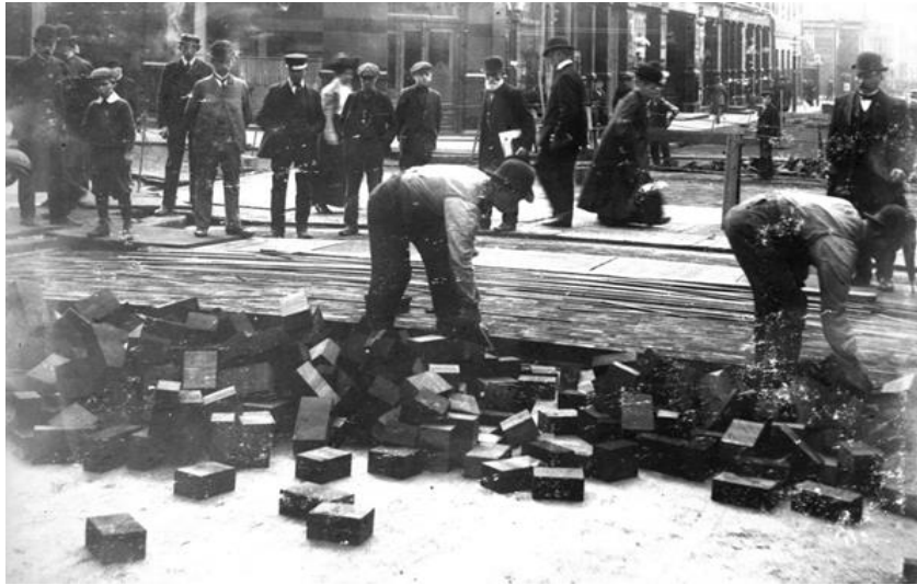
Figur 1.10 Legging av trekubb som vegdekke i Christiania, i krysset Kirkegaten-Prinsens gate ca. 1913. (Oslo Byarkiv, fotograf ukjent)
