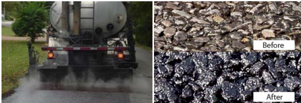
Figur 6.103 Fornyning av et aldret asfaltdekke med bitumenemulsjon (Foto: USAshalt Maintenance)
