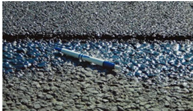
Figur 6.66 Eksempel på støydempende tynndekke, prinsippskisse og foto. Et tynt lag varm masse legges ut på en polymermodifisert klebing, bindemidlet «koker opp» og gir god heft og omhylling. Dette er spesielt viktig for å få god dekkelevetid ved høyt hulrom. (Foto: Statens vegvesen)
