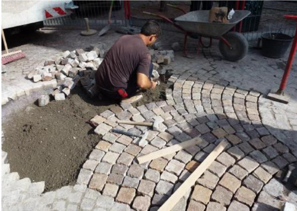
Figur 7.26 Utbedring av dekke av smågatestein (Foto: Rene Kierstein)
