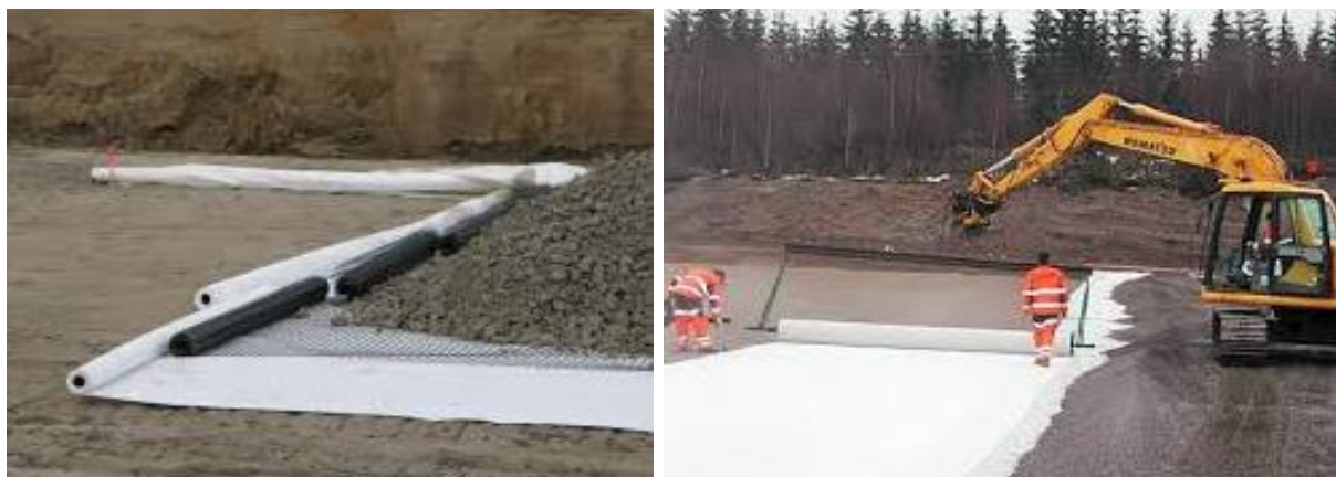
Figur 5.41 Bruk av fiberduk /9/
