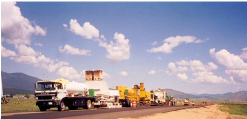
Figur 6.101 Varm gjenvinning på veg med Pyropaver. Legg merke til skorsteinene for avbrenning av røykgassene. (Foto: Paveover Inc., USA)
