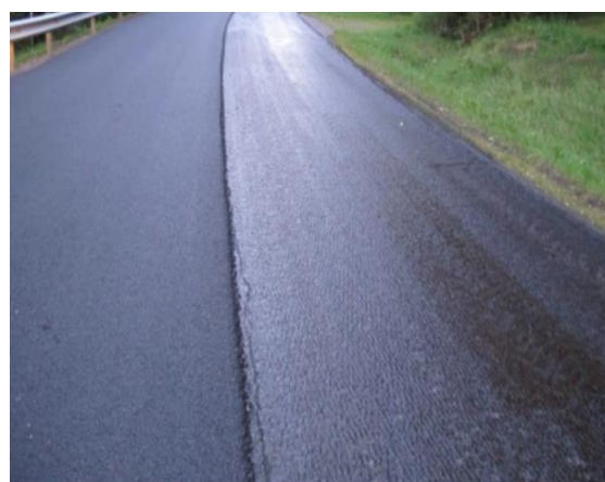
Figur 6.87 Eksempel på dårlig (t.v.) og god (t.h.) klebing. Det er viktig at hele flaten limes. (Foto: Statens vegvesen)
