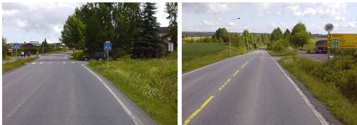
Figur 6.58 Asfaltgrusbetong er egnet på veger med ÅDT < 3 000 og med en god oppbygning. Begge bilder fra fv. 192 Oppland (Foto: Statens vegvesen)
