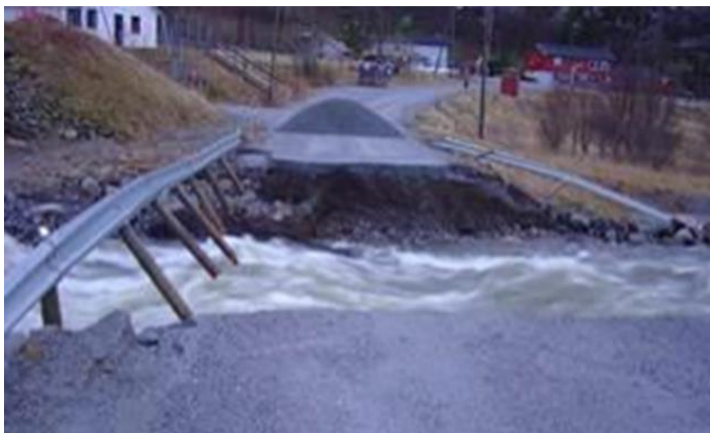
Figur 10.27 Konsekvensene av blokkert stikkrenne kan være store (Foto: Trygve Rullestad)
