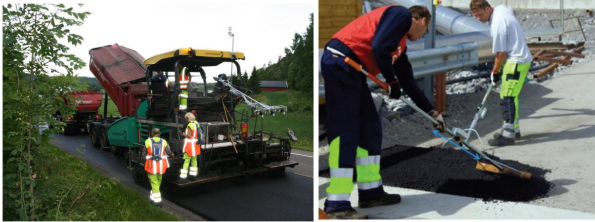
Figur 6.83 Forsøk med LTA i Norge i 2011. Her ble arbeiderne utstyrt med gass-sensorer og mekaniske sensorer for å måle kjemiske og ergonomiske påkjenninger, både ved utlegging av ordinære masser og LTA. /16/
