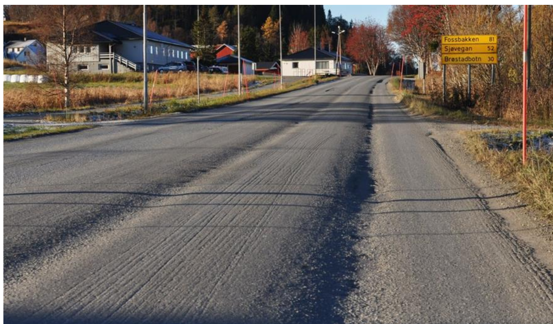
Figur 6.36 På mange veger utløses krav til dekkefornyelse av piggdekksslitasje (Foto: Statens vegvesen)
