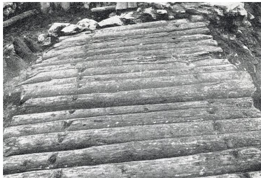
Figur 1.5 Brulagt gate i det gamle Oslo (ca. år 1000). Gatedekket består av planker lagt på tvers over og naglet til langsgående bærebjelker av rundtømmer (skisse: Ola Øgar Svendsen, Tidsskriftet St. Halvard)
