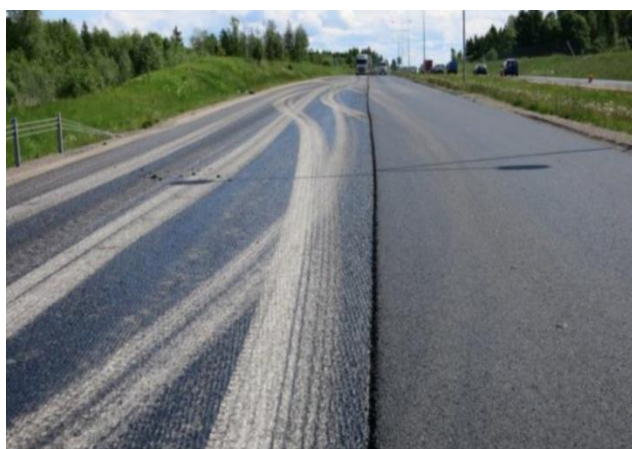
Figur 6.87 Eksempel på dårlig (t.v.) og god (t.h.) klebing. Det er viktig at hele flaten limes. (Foto: Statens vegvesen)
