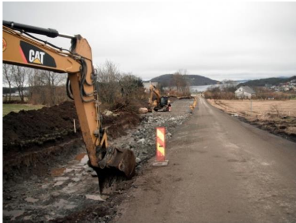
Figur 9.34 Masseutskifting (Foto: Bertelsen og Garpestad AS)
