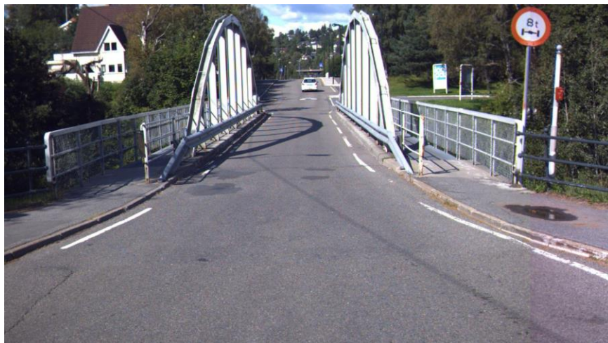
Figur 11.3 Noen ganger er det bruene som begrenser tillatt aksellast på tilstøtende veger (Foto: Statens vegvesen)
