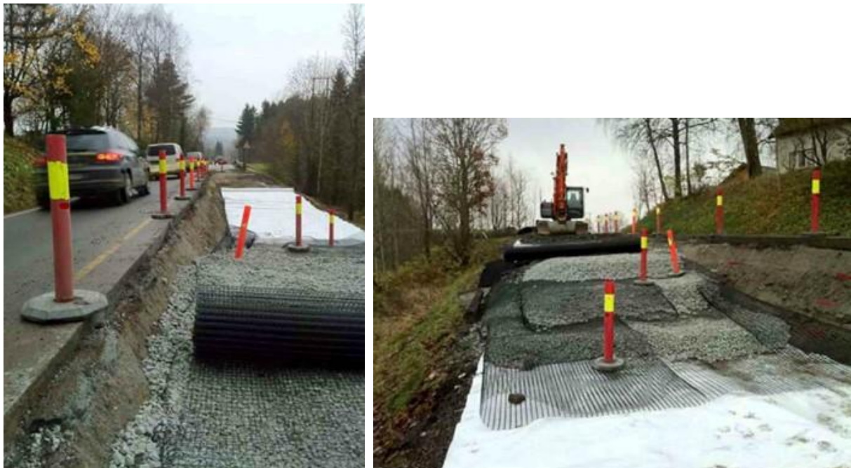
Figur 11.25 Utbedring av ustabil skråning på fv. 111 ved Trøgstad ved bruk av jordarmering og skumglass (Foto: Jan Vaslestad)
