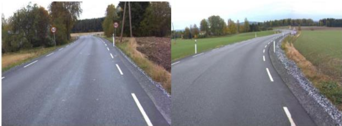
Figur 11.39 Bilder fra fv. 173 ett år etter utført forsterkning /2/
