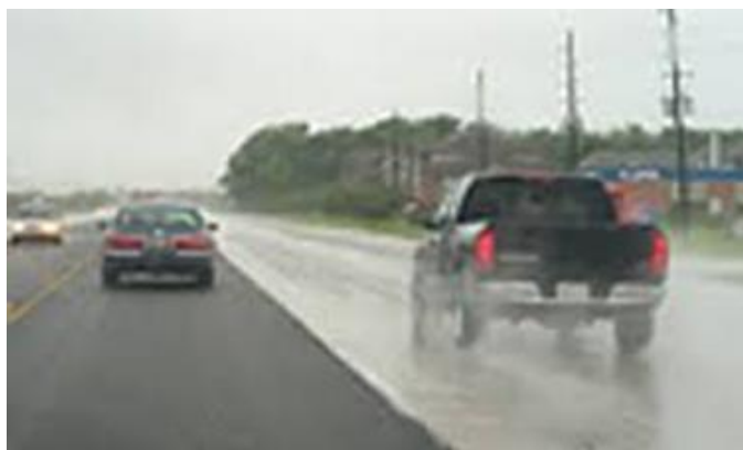
Figur 6.64 Drensasfalt i regnvær (t.v.) sammenlignet med vanlig asfalt (t.h.) (Foto: equipmentworld.com)
