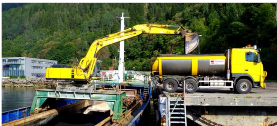
Figur 6.85 Ved lossing av asfalt fra båt bør bilen stå vinkelrett på båtsiden for å redusere faren for separasjon i massen (Foto: Statens vegvesen)
