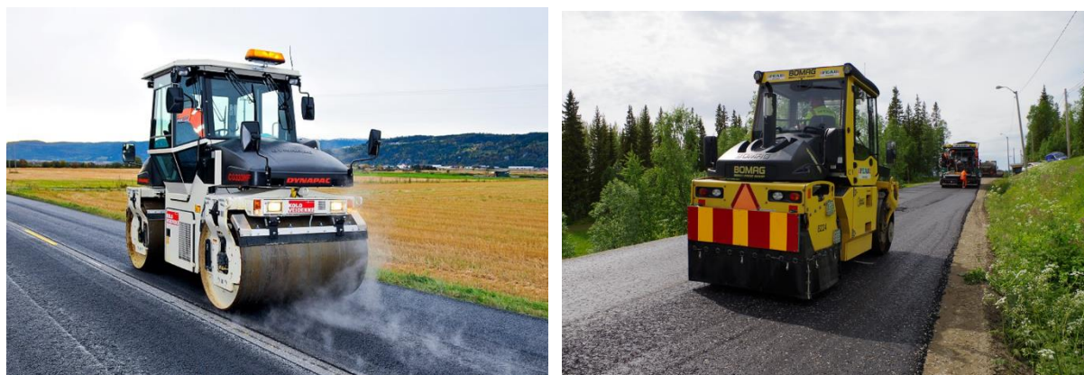
Figur 6.93 Valg av komprimeringsutstyr bør skje ut fra den aktuelle jobben; tandemvals (t.v.) er vanlig i de fleste kombinasjoner, mens gummi hjulsvals (t.h.) gjerne er å foretrekke ved tynge bearbeidbare masser som gjenbruksasfalt, kaldasfalt o.l. (Foto: Statens vegvesen)
