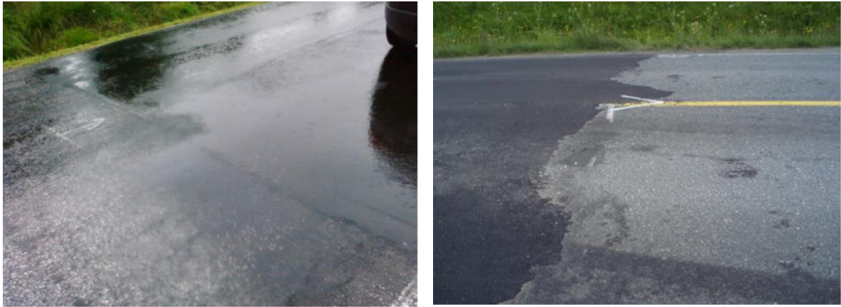
Figur 6.90 God (t.v.) og mindre god (t.h.) tverrskjøt. Et viktig poeng er å holde jevn fart på utleggeren for dermed å unngå flest mulig skjøter. (Foto: Statens vegvesen)
