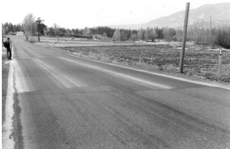
Figur 9.60 Tydelig rimdannelse på en kort, isolert vegstrekning (Foto: Geir Refsdal)
