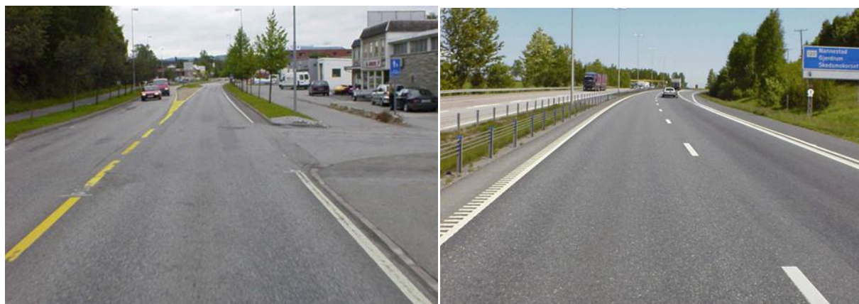
Figur 6.60 Asfaltbetong er egnet på veier med ÅDT > 3 000. T.v. rv.2 Hedmark, t.h. E6 Akershus (Foto: Statens vegvesen)
