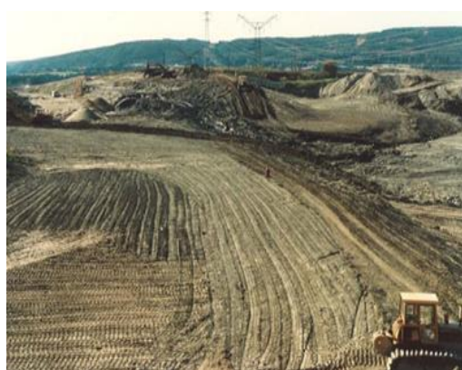
Figur 3.30 Oppbygging av leirfylling på E16 ved Veien-Nymoen i Buskerud (Foto: Frode Oset). T.h. en prinsippskisse for vegfylling med drenerende sandlag /4/
