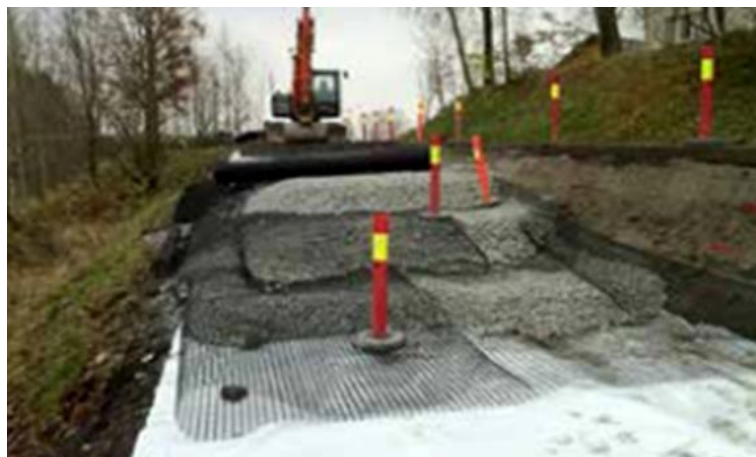
Figur 4.40 Utlagt skumglass med fiberduk og armeringsnett /3/ (Foto: Jan Vaslestad)
