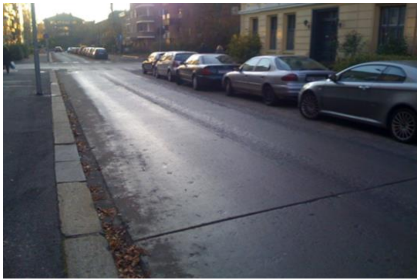
Figur 7.7 Dette betongdekket i Jacob Aalls gate i Oslo ble lagt i 1943 (Norges eldste?), da det var knapphet på oljeprodukter. Dekket er fremdeles under trafikk. NB! Til venstre på bildet ses fremdeles hundespor i betongen! (Foto: Geir Refsdal)
