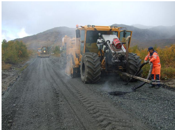
Figur 6.102 Eksempel på kald gjenvinning på veg; eksisterende gammelt dekke freses av med kaldfres, konstruksjonen under dypstabiliseres med innfresing av nytt bindemiddel og steinmateriale, bortfrest Ak legges ut igjen på toppen som øvre bærelag og anrikes med nytt bindemiddel (skumbitumen), før hele den oppgraderte konstruksjonen komprimeres og klargjøres for nytt slitedekke (Foto: Statens vegvesen, Troms)
