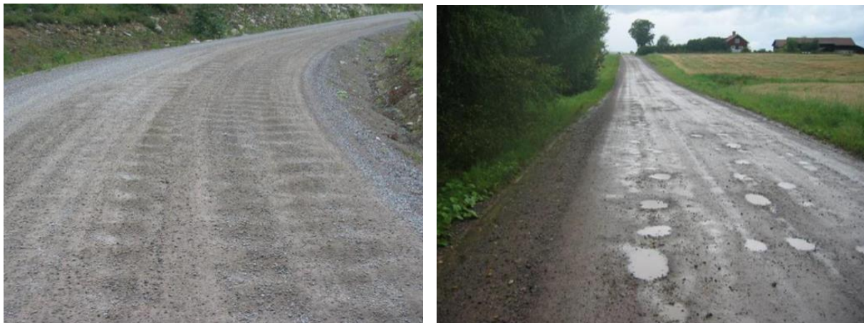
Figur 7.3 Korrugering («vaskebrett») oppstår når grusen mister for mye av det finstoffet som binder massen sammen. Slaghull oppstår når tverrfallet ikke gir tilstrekkelig vannavrenning /1/
