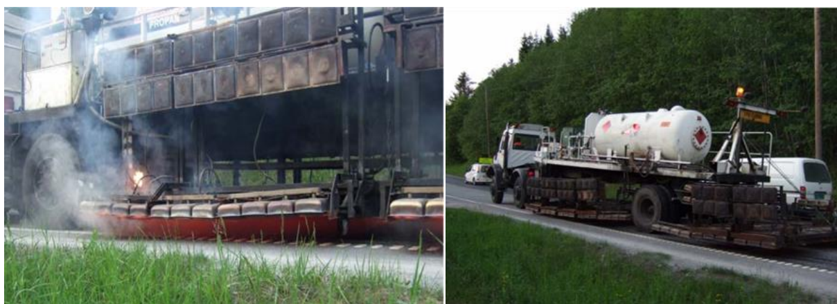
Figur 6.97 Forvarming før asfaltering med gassfyrt heater (Foto: Vegard Opsahl)
