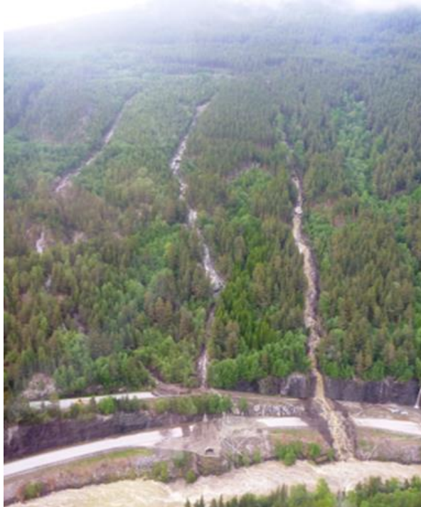
Figur 4.10 Relativt små skred som løses ut langt oppe i dalsiden kan få store konsekvenser for vegen lengre nede. Dette er et flomskred ved Rosten i Gudbrandsdalen under «pinseflommen» 10. – 12. juni 2011. (Foto: Niklas Eriksson)
