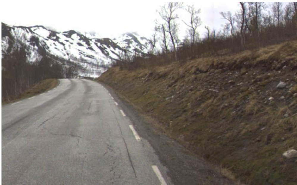
Figur 10.16 Åpen drenggrøft vil være et naturlig valg på middels og mindre trafikkerte veger utenfor tettbygde strøk (Foto: Statens vegvesen)
