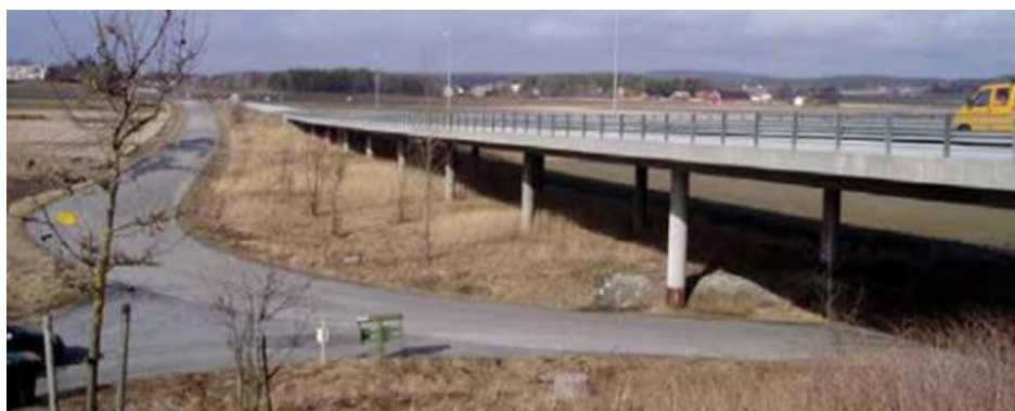
Figur 3.21 Vikshaugen bru på E6 i Østfold, bygget i 1992 (Foto: El Hadj Nouri)
