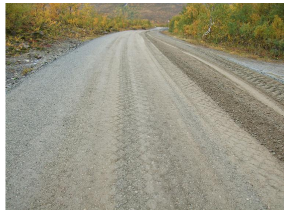
Figur 6.102 Eksempel på kald gjenvinning på veg; eksisterende gammelt dekke freses av med kaldfres, konstruksjonen under dypstabiliseres med innfresing av nytt bindemiddel og steinmateriale, bortfrest Ak legges ut igjen på toppen som øvre bærelag og anrikes med nytt bindemiddel (skumbitumen), før hele den oppgraderte konstruksjonen komprimeres og klargjøres for nytt slitedekke (Foto: Statens vegvesen, Troms)
