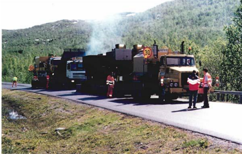
Figur 6.100 Varm gjenvinning på veg, remiksing (Foto: Geir Berntsen)
