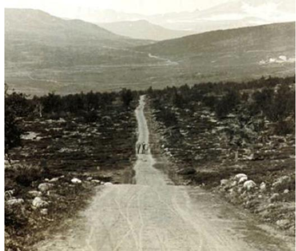
Figur 1.6 Det franske prinsipp – rette veglinjer. Til høyre et parti fra den Trondhjemske Kongeveg mellom Christiania og Minnesund, som ble anlagt 1770-1800 /4/
