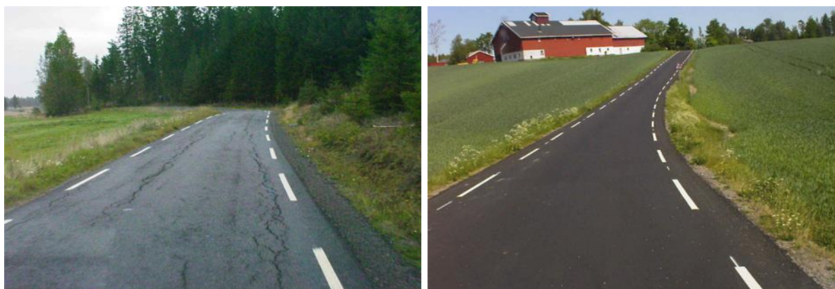
Figur 6.56 Mykasfalt er egnet på veger med ÅDT < 3000, og der telehiv mv. må forventes. T.v. fv. 4 i Østfold, t.h. fv. 663 Østfold. (Foto: Statens vegvesen)
