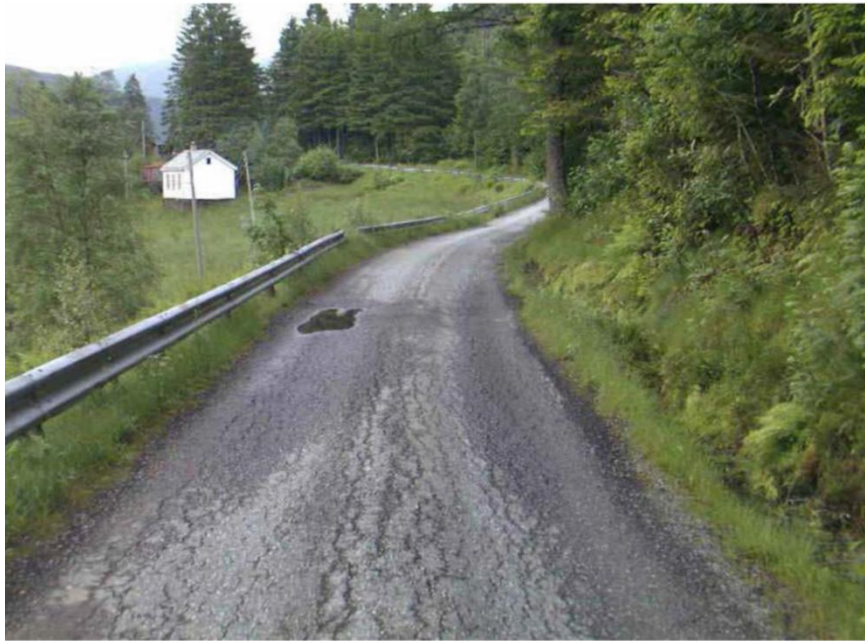
Figur 6.45 En veg kan også «aldres med verdighet», og fortsatt tjene sin funksjon (Foto: Statens vegvesen)
