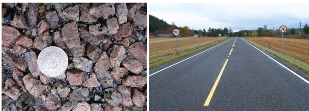
Figur 6.51 T.v. nærbilde av overflatebehandling, Eo (foto: Veidekke). T.h. nylagt Eo på fv. 343 ved Matrand i Hedmark 2007 (foto: Harald Libæk)
