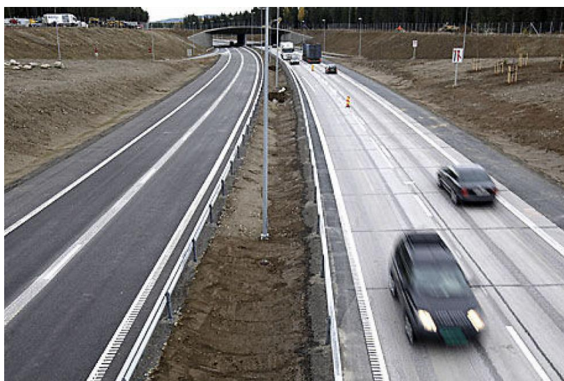
Figur 7.6 Betongdekket til høyre i bildet var 22 år gammelt da ny firefelts E6 ved Gardermoen ble åpnet i 2009. Bildet er fra rett før åpningen. (Foto: VG)
