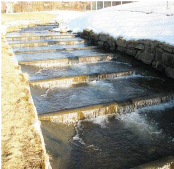
Figur 10.19 Eksempler på nedføringsrenner bygget med trappetrinn. T.v. fra Ilabekken i Trondheim, t.h. fra E39 ved Batnfjordsøra /2/
