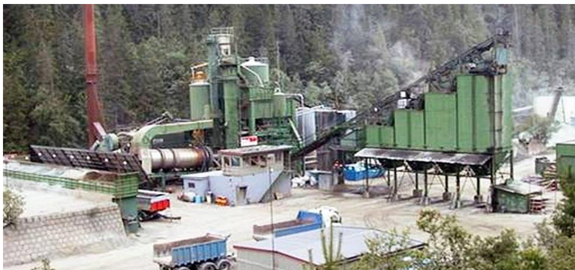
Figur 6.76 Asfaltfabrikk for varm produksjon, satsblandeverk (Foto: Veidekke Industri)
