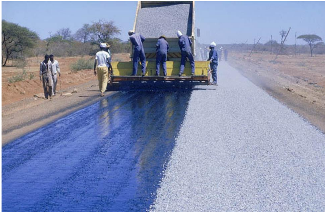
Figur 6.47 Ottadekke (Otta Seal) under utlegging i Botswana (foto: Rolf Johansen)
