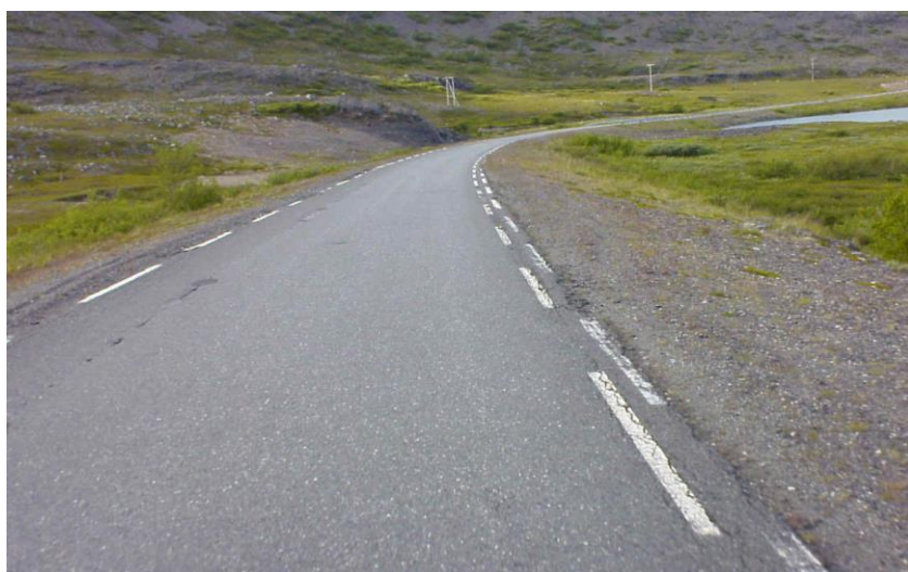
Figur 4.16 Bilde fra rv. 890 Finnmark, her har vegdekket holdt i 24 år. Det er nok nær ytterpunktet av hva som er mulig å oppnå som levetid på asfaltdekker. (Foto: Statens vegvesen)
