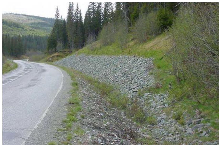
Figur 10.48 Eksempel på erosjonssikring i skjæringskråning ved masseutsifting, fra Gartland i Nord-Trøndelag (Foto: Kjell Eriksen) /1/
