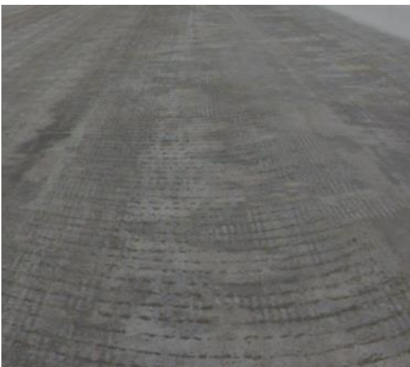
Figur 21: Fastsand Falköping flystripa (med 0/4 mm Lora). Bilde tatt ifbm friksjonsmåling på morgenen dagen etter feltutlegging.
