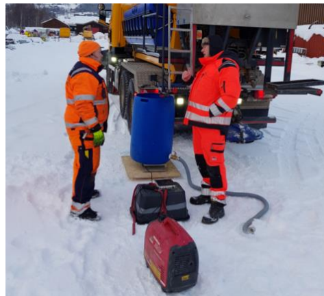
Figur 12: Sjekk av vannmengder
