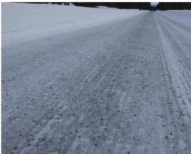
Figur 37: Varmsand Brekkelivegen (2/7 mm Visnes)
