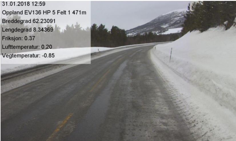
Figur 34: Schmidt, spredehastighet 22-23 km/t. Mildvær og restsalt gjør at det er bart i ytre hjulspor.
