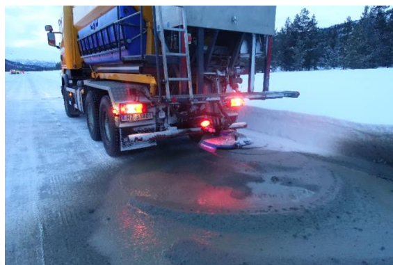
Figur 13: Utmåling med bilen i ro (manuell/simulert modus) før ordinær feltutlegging.
