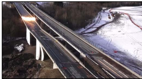
Brukasse i akse 4 kuttes momentant med C4 (Foto: Orbiton/SvRs)
