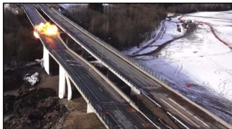
Detonasjon av Eurodyn-ladninger i søylen i akse 5 (Foto: Orbiton/SvRs)
