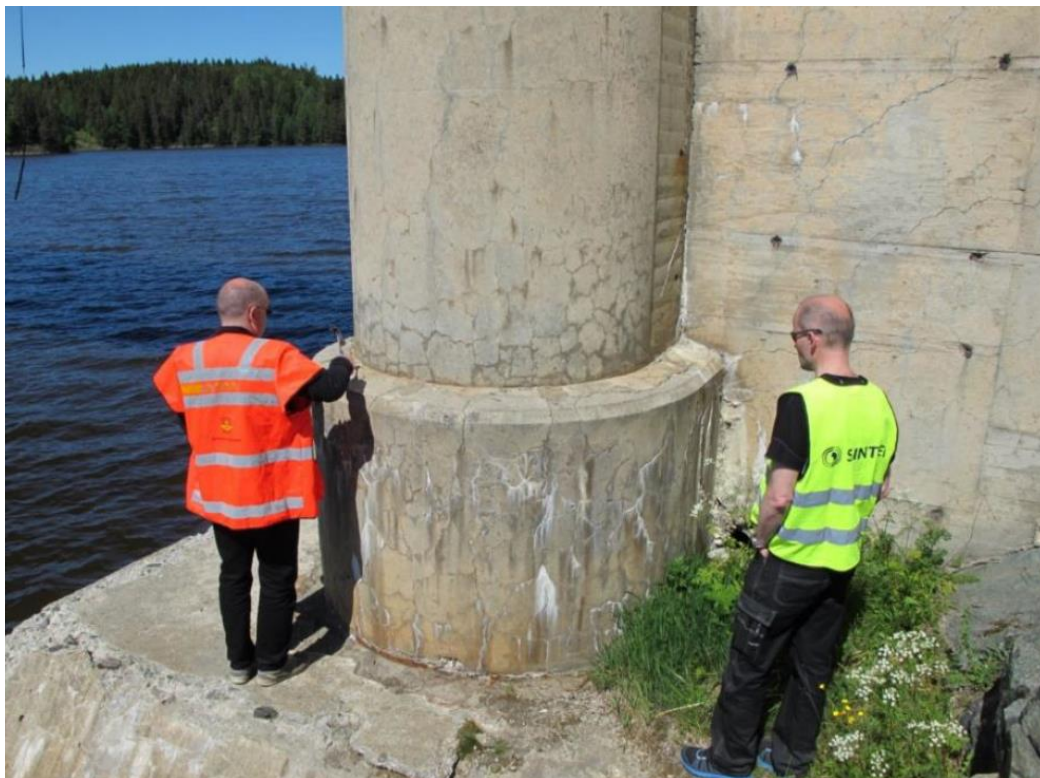
Figur 12: Feltarbeid på Kroksundbrua. Bård Pedersen, Tunnel og betong sammen med Jan Lindgård (SINTEF). Foto: Eva Rodum
