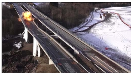
Detonasjon av Eurodyn-ladninger i søylen i akse 6 (Foto: Orbiton/SvRs)
