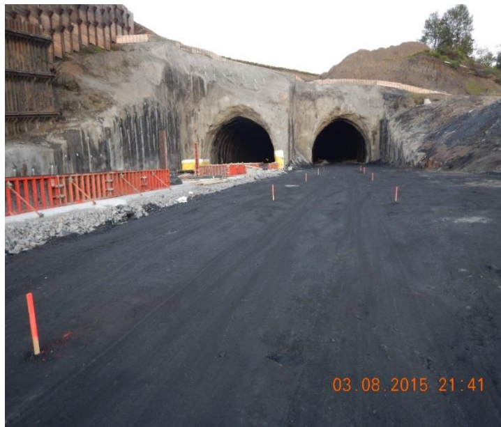
Figur 7: Alunskifer på Gran. Foto: Halldis Fjermestad, Statens vegvesen
