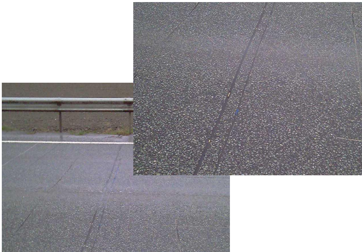
Figur 61 Klett, brutt piezosensor
