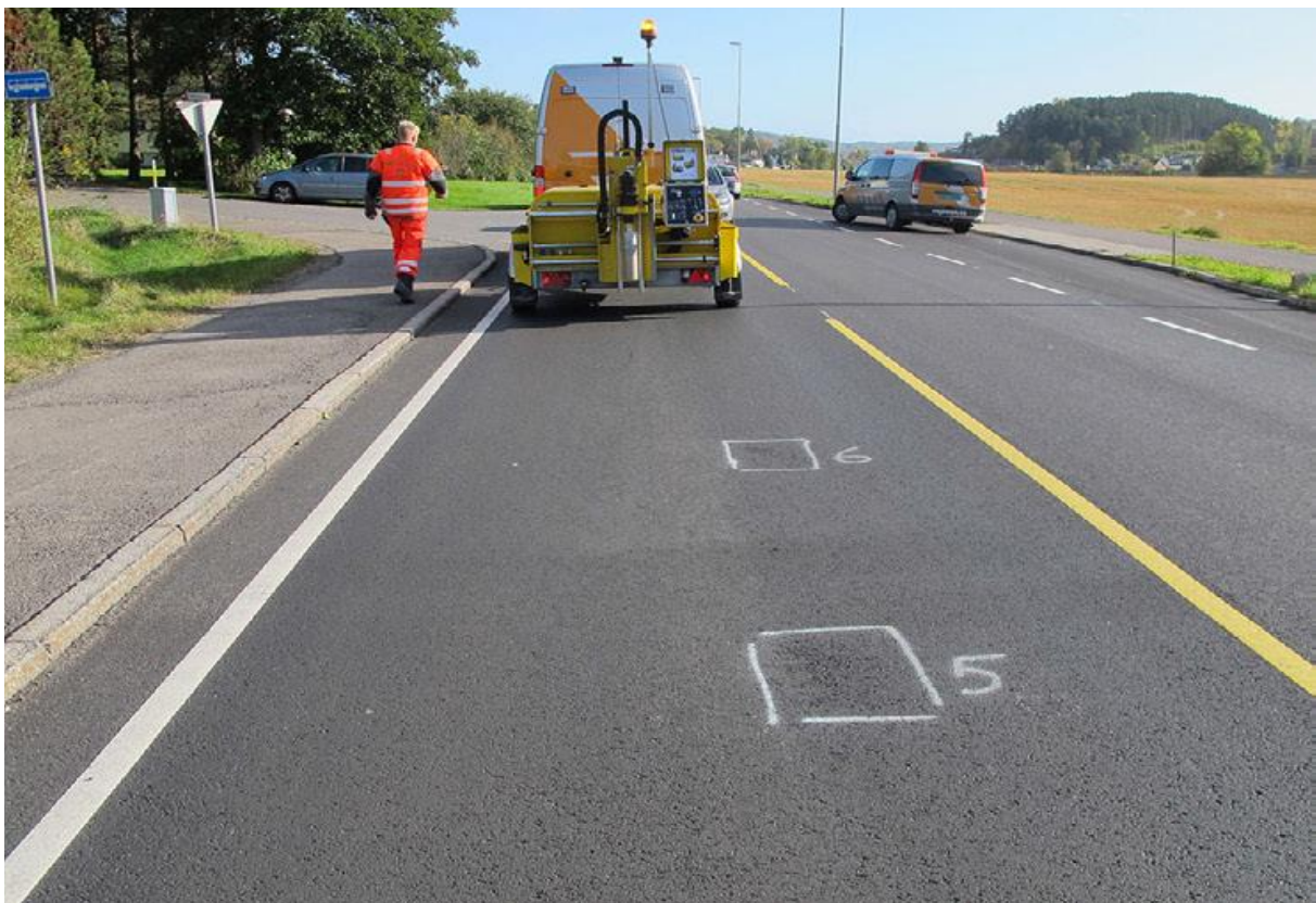
Figur 15 Prøvetaking og etterkontroll av ferdig utlagt asfaltdekke
