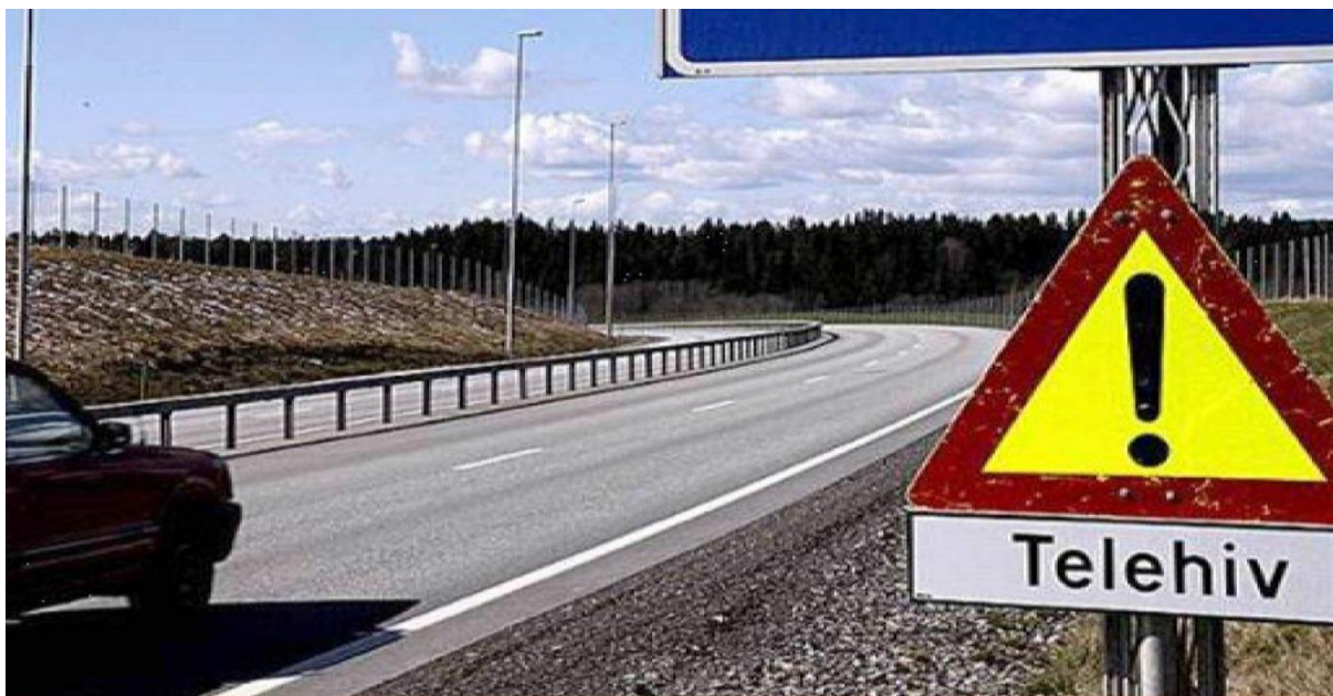
Figur 4 Skader på nybygde vegger medførte stort fokus på tele i starten av Varige vegger
