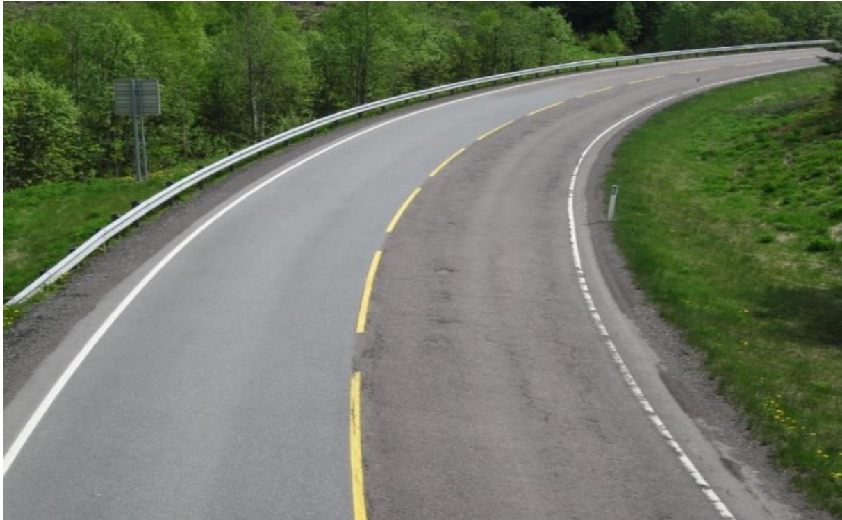
Figur 20 Eksempel på asfaltdekker med god og dårlig bestandighet. Begge dekkene ble lagt samtidig. (Foto Rune Lien)
