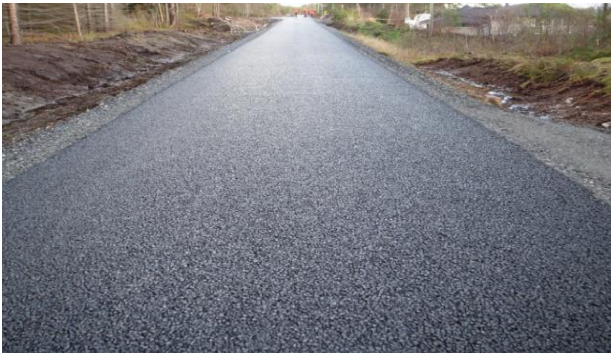
Figur 9 Eksempel på homogent og godt utført asfaltdekke (fot Jan Sundstrøm)
