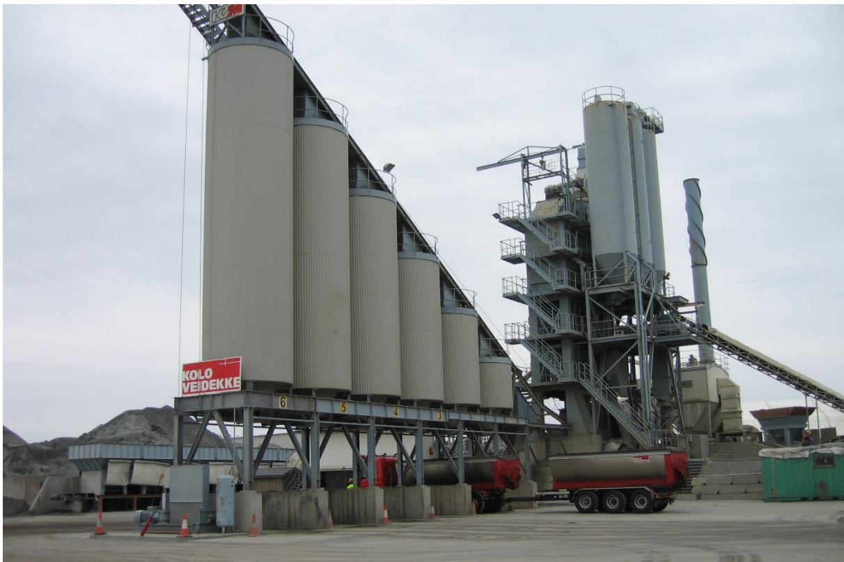
Figur 7 I moderne asfaltfabrikker er det normalt god kontroll på sammensetningen av asfaltmassen (foto Leif Bakløkk)
