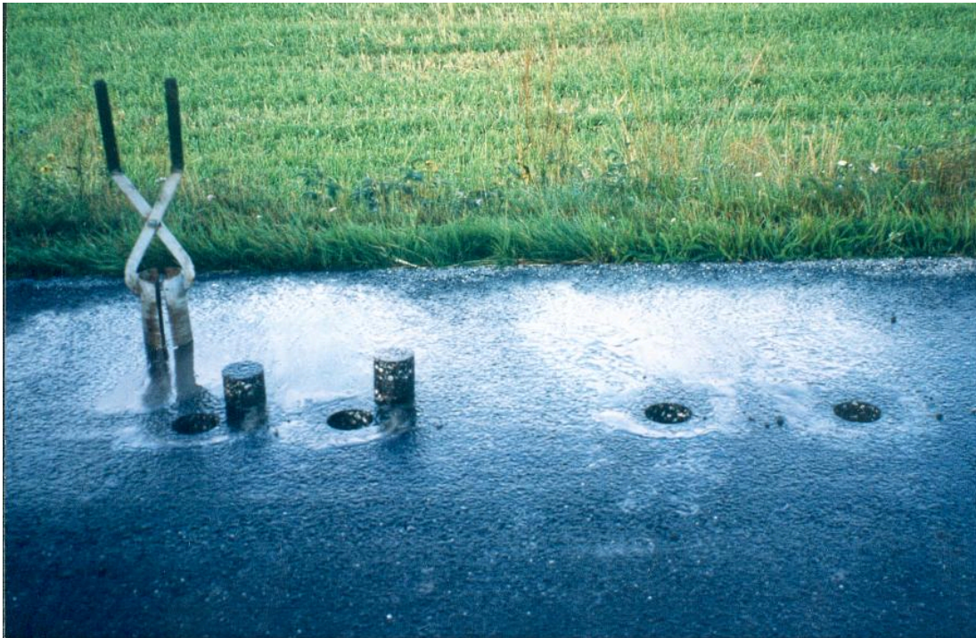
Fotografi uttak av borkjerner Rv 358 en måned etter utlegging.
