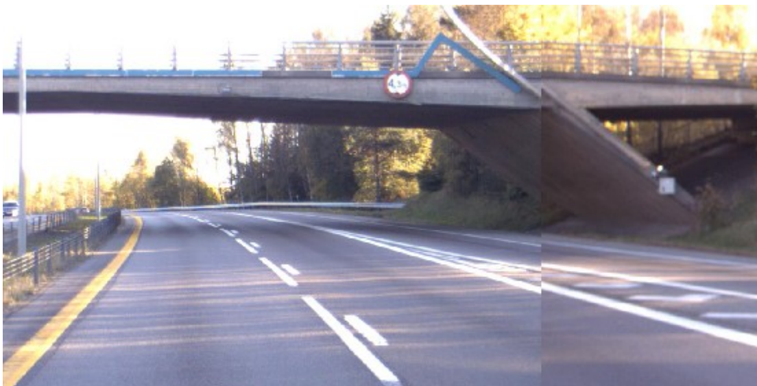
Figur 10 Plassering av reisetidsleser ved Skedsmovollen i nordgående retning. Påkjøringsfeltet fra Rv 120 til høyre dekkes ikke. Kilde: Vegbilder.
