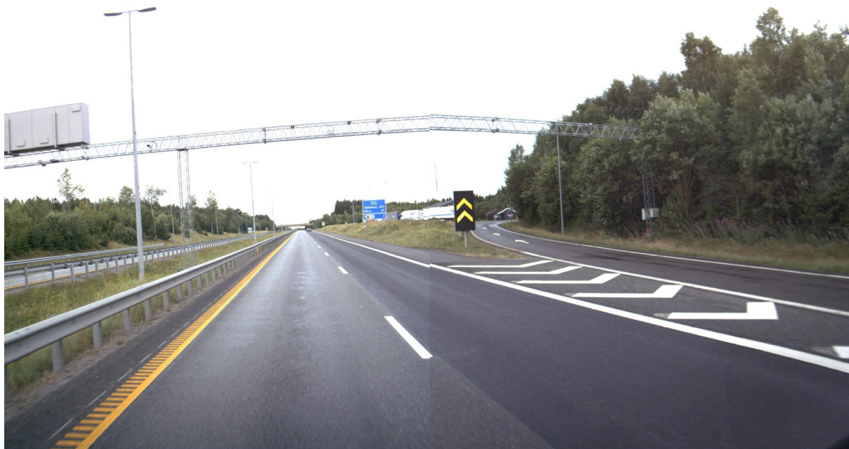
Figur 17 Portal til reisetidsleser ved Støkken i retning sørgående. Avkjøringsfelt til kontrollstasjonen til høyre er ikke dekket. Kilde: Vegbilder.
