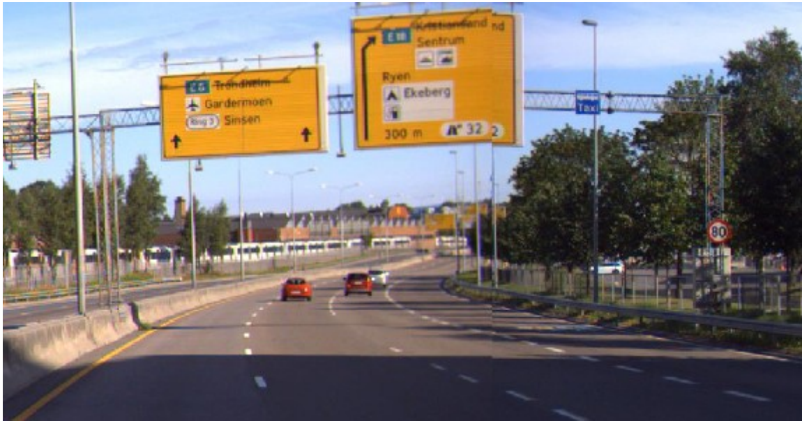
Figur 7 Reisetidslesere ved Ryen i nordgående retning. Vi ser to lesere som til sammen detekterer trafikk i de tre feltene til venstre, ikke kollektivfeltet helt til høyre. Kilde: Vegbilder.
