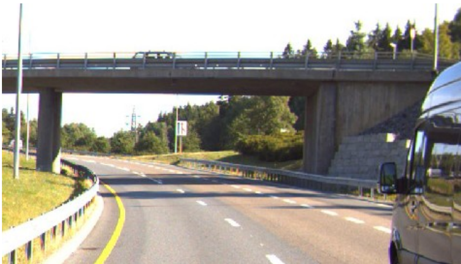
Figur 6 Plassering av reisetidsleser ved Klemetsrud i nordgående retning. Kollektivfeltet til høyre detekteres ikke. Kilde: Vegbilder.
