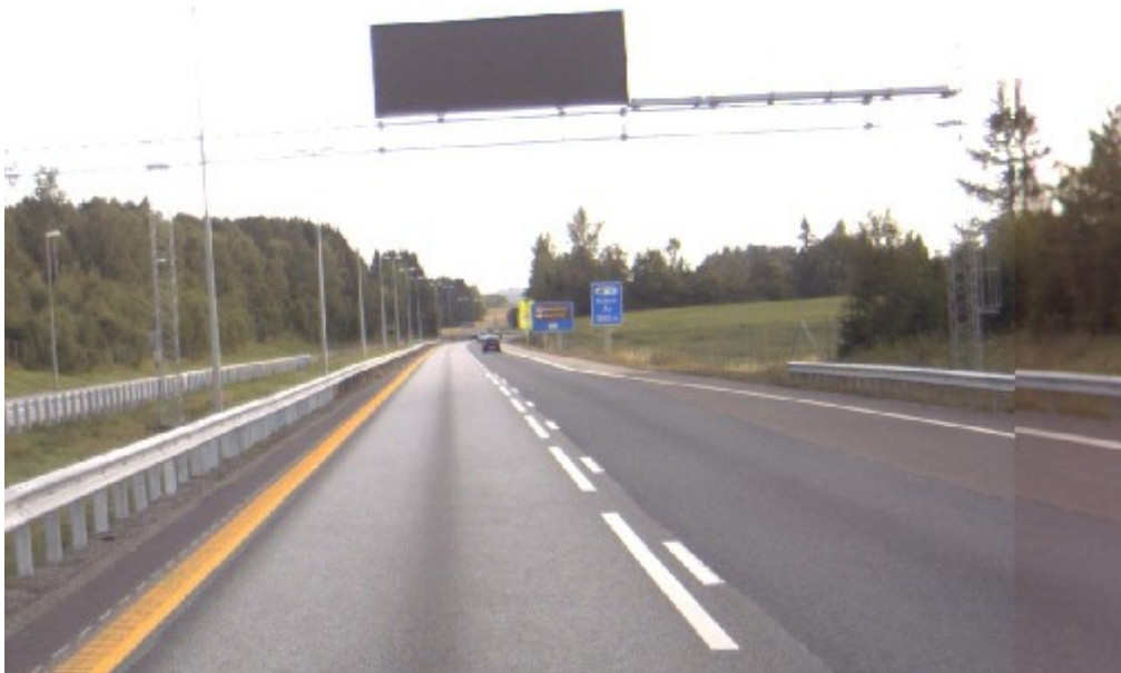
Figur 5 Portal med reisetidsleser ved Støkken i nordgående retning. Begge felt detekteres. Kilde: Vegbilder.
