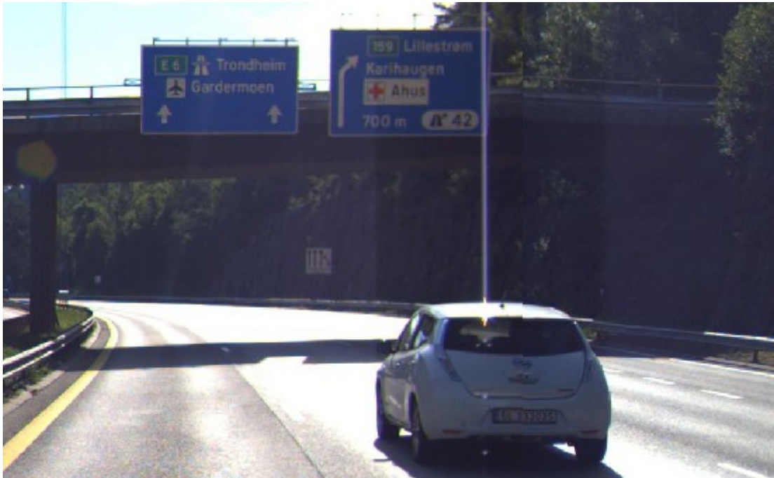
Figur 9 Plassering av to reisetidslesere ved Karihaugen i nordgående retning. Kollektivfeltet til høyre dekkes ikke. Kilde: Vegbilder.
