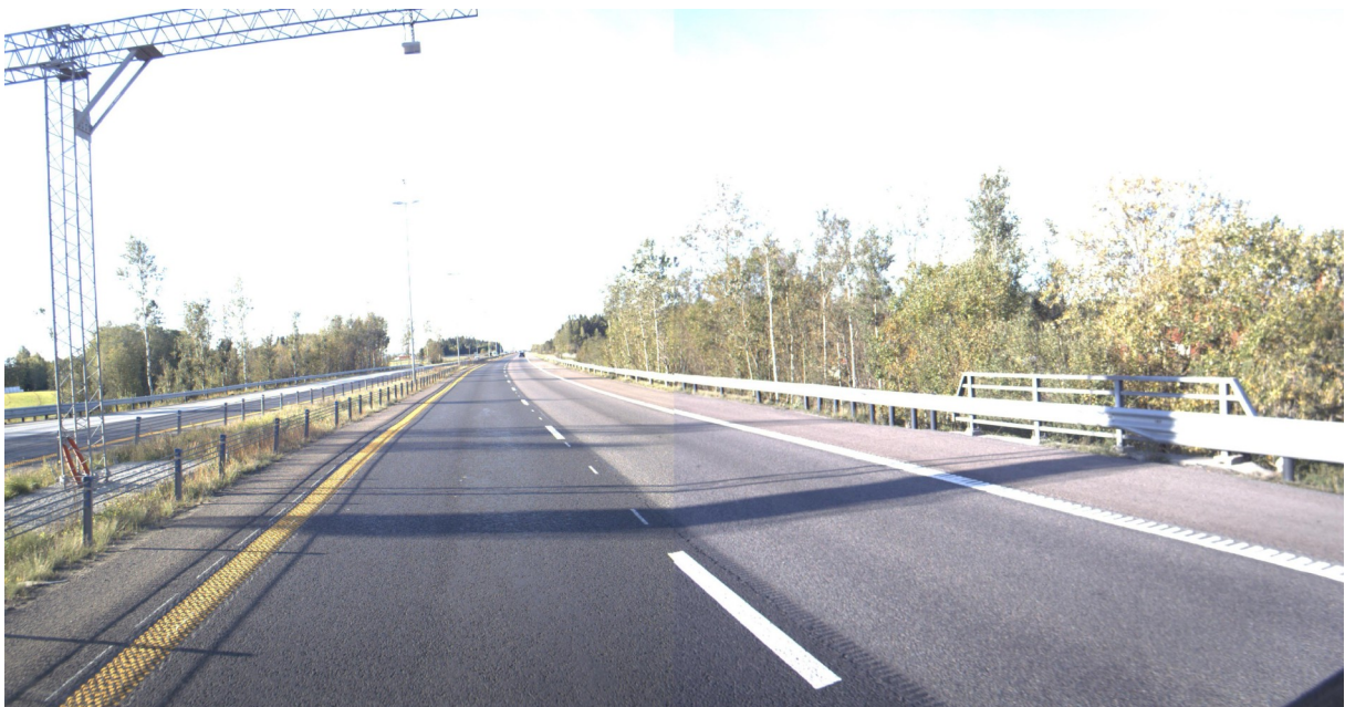
Figur 14 Reisetidsleser ved Kløfta i retning sørgående. Denne dekker høyre felt dårlig. Kilde: Vegbilder.
