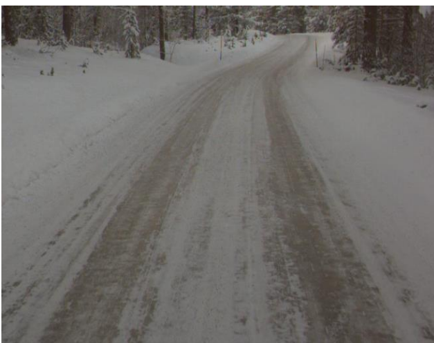
Figur 50: Strekning 5. Vanskelig å se sanda i og med at en del korn er hvite.
