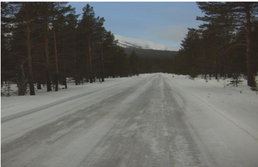
Figur 19: Del av strekning før tiltak.
