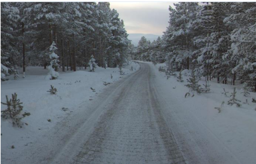
Figur 40: Strekning 1. Spredemønster ser bra ut, men mye løse steiner.
