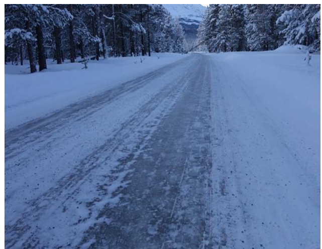
Figur 51: Strekning 5, dag 2. Ingen sand igjen i hjulsporene. Noe sand på skuldra.
