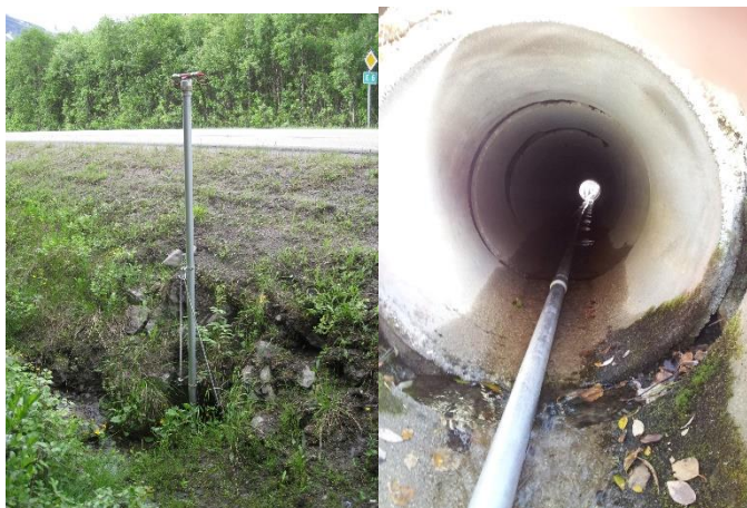
Figur 11. IGS-installasjon i stikkrenne. Foto KM Reitan
