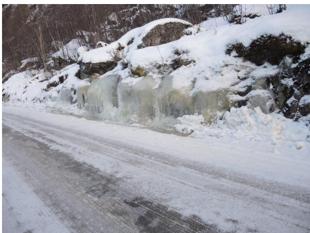
Figur 3. Høvelgrøft. Foto KM Reitan
