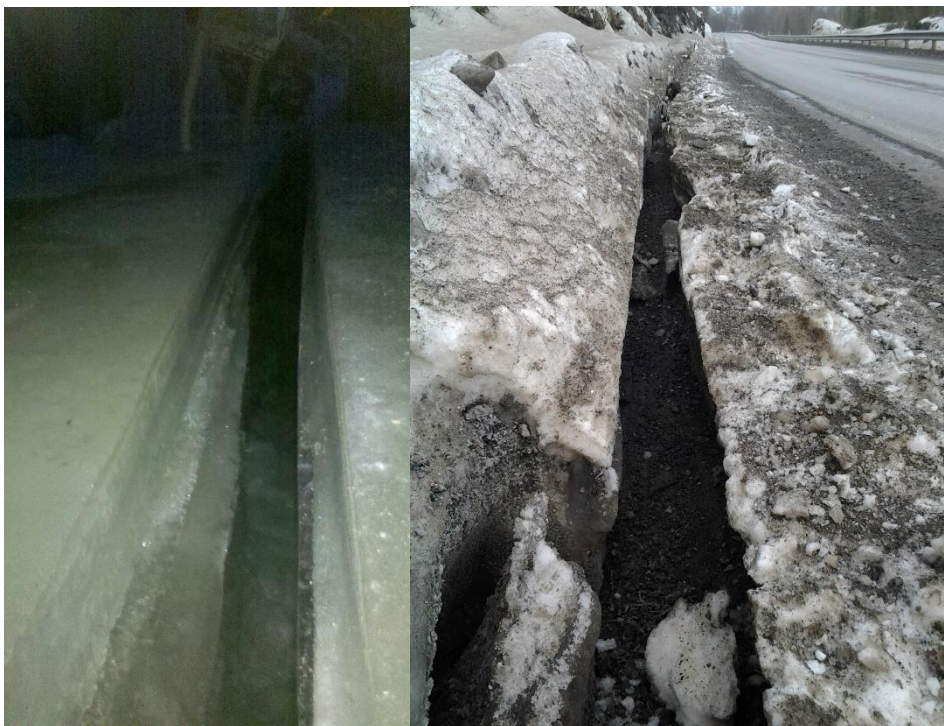
Figur 19. Eksempler på IGS-grøfter. Nytint grøft til venstre. Grøft som har holdt seg åpen resten av vinteren til høyre. Foto KO Dalberg, Mesta
