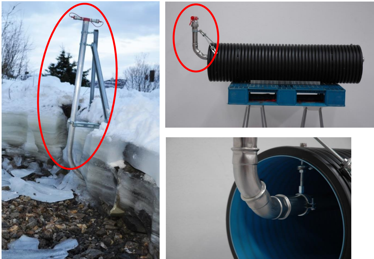
Figur 2.1 Venstre: Ice Guard systemet montert in-situ, med ventiler for tilkobling av tur-/returslanger synlig på toppen, inklusiv innfesting og støttebraketter på stikkrenne av betong. Selve innløpsrøret er markert med rødt oval. Høyre (øverst): Utstillingsmodell av IGS med innløpsrøret godt synlig på oppstrømssiden av hovedrøret. Høyre (nederst): Detalj av innløpsrøret på samme utstillingsmodell.
