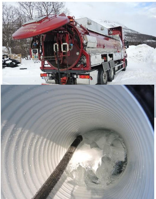
Figur 10. Isskjæring/høytrykkspyling av stikkrenne. Foto KM Reitan
