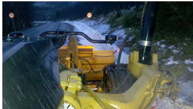
Figur 18. Høvling av isgrøft. Foto: LO Bratland, Mesta
