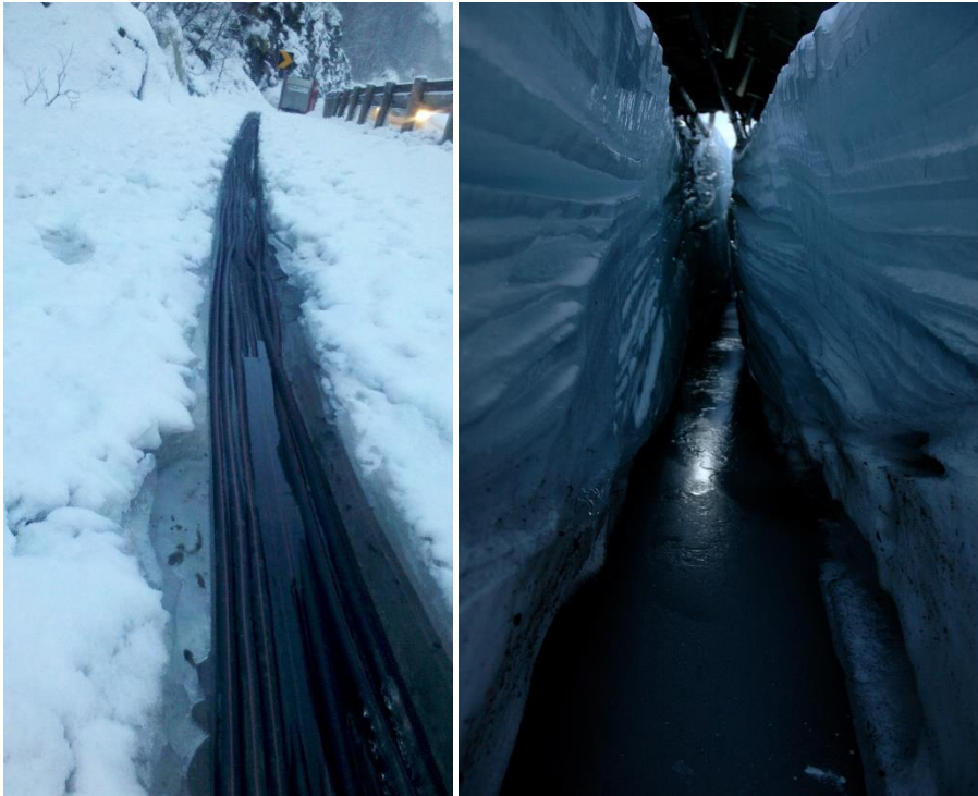
Figur 7. Til venstre: Tining av grøft med IGS-slanger. HeatWork-maskinen i bakgrunnen er plassert utenfor rekkverket under tineprosessen. Foto KO Dahlberg, Mesta
