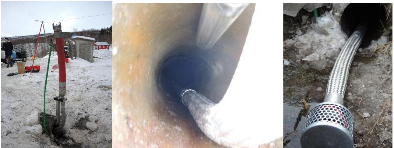
Figur 12. TFSI-EL-installasjon. Til venstre: tilkoblingsløsning ved innløpet, i midten: inne i stikkrenna, til høyre: ved utløpet. Foto KM Reitan
