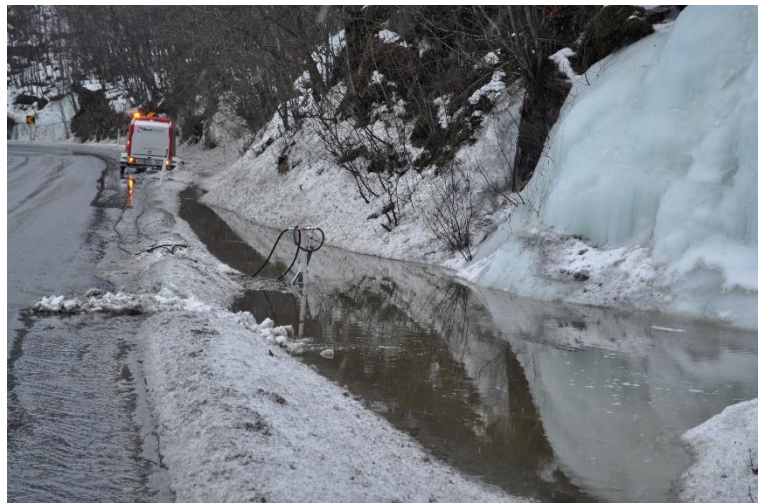
Figur 25. Slangene fra HW-maskinen er koblet til adapteret. Foto HeatWork
