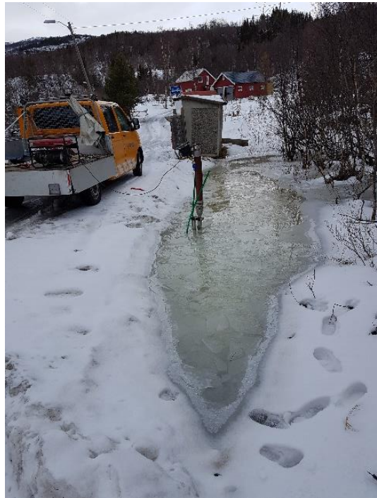
Figur 26. Tining med TFSI-EL og strømaggregat.
