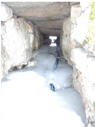
Figur 2. Stikkrenne med varmekabel. Foto KM Reitan
