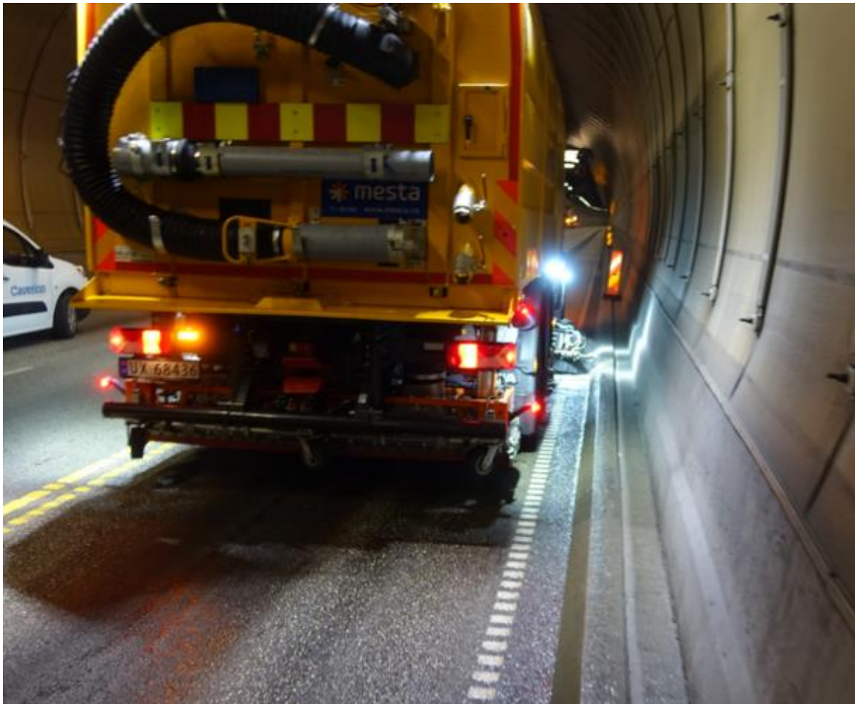
Figur 17: Drag 1, felt 1. Vasking med koster og oppsug i Freifjordtunnelen (Foto: Dagfin Gryteselv)
