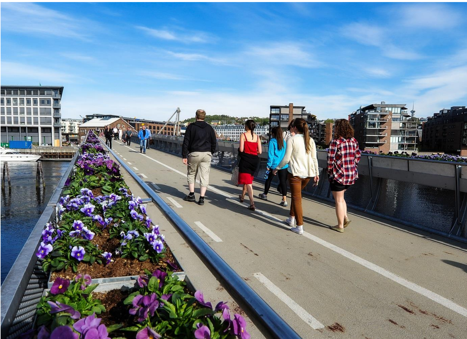
Fotgjengere i sykkelfelt på Verftshvua, Trondheim (2012). Foto: Knut Oneide, Statens vegvesen
