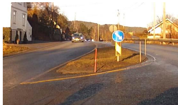
Bilde 4: Bilde til høyre viser plassering av skilt etter at det ble flyttet etter ulykken. Det står nå utenfor siktsonen for motgående trafikk.
