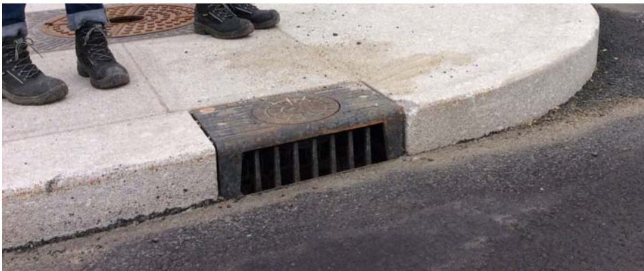
Figur 11-3 Ferdig montert kjeftsluk med tenner for å fange opp større gjenstander
