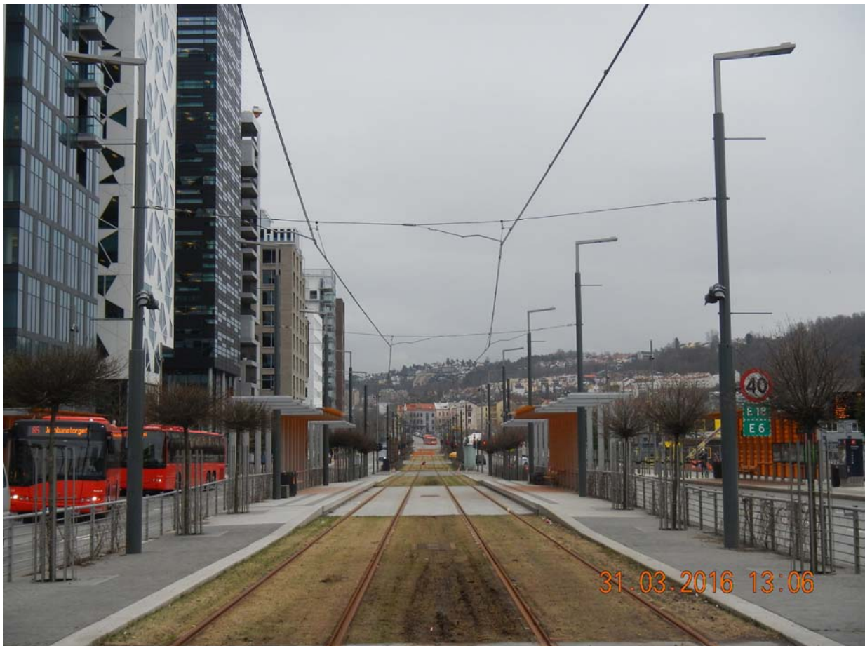
Figur 9-5 Kombinert lysmast og kontaktledningsmast (KL-master)
