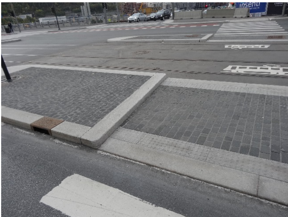
Figur 5-12 Taktil oppmerking i overgangsfeltene i grå granitt
