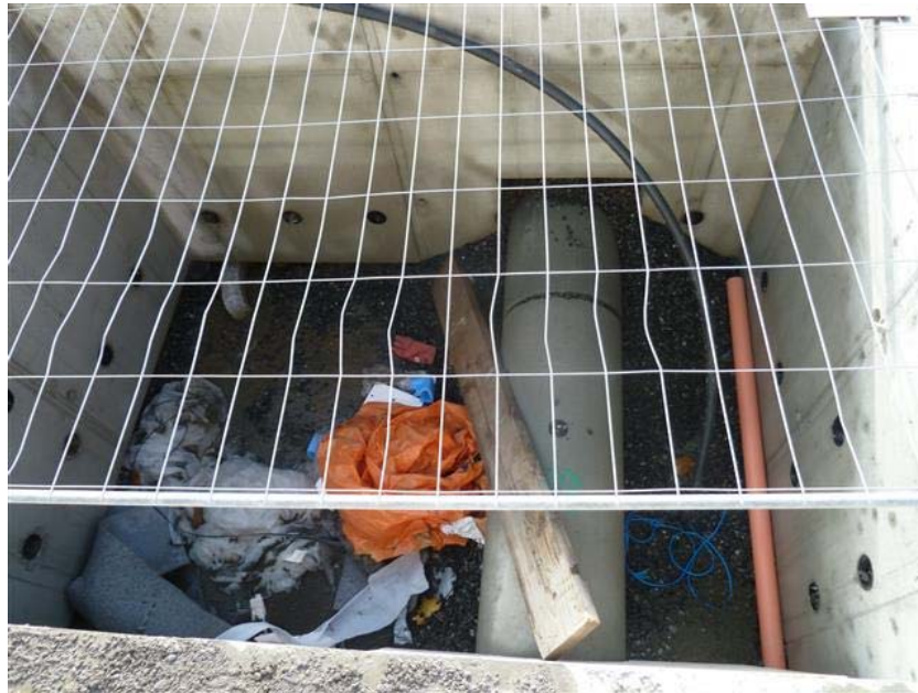
Figur 4-17 Rot og søppel i plantekasser både før og etter fylling med jord var en utfordring. Tomme plantekasser må sikres slik at ingen faller ned i kassene.
