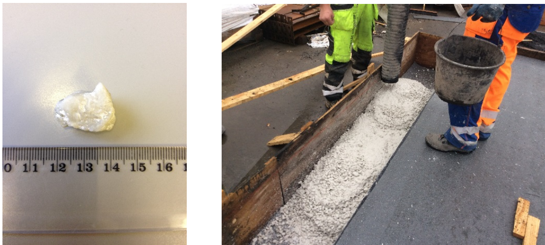
Figur 6-1 Hvitt tilslag og prøvestøp av hvit betong
