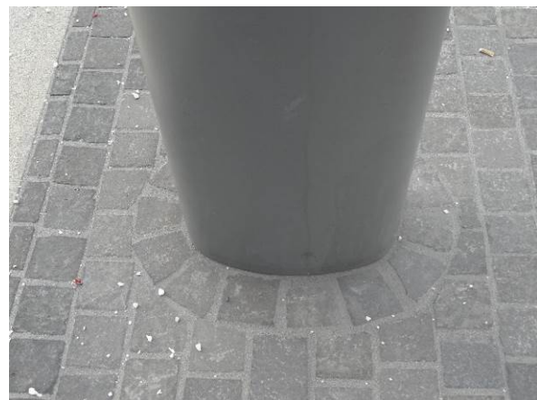
Figur 5-8 Et «rulleskift» rundt konstruksjoner i steindekke er en god fagmessig utførelse
