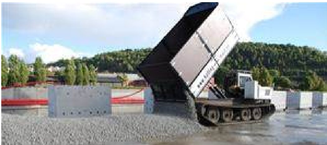
Figur 10-5 Utlegging av skumglass med beltebil
