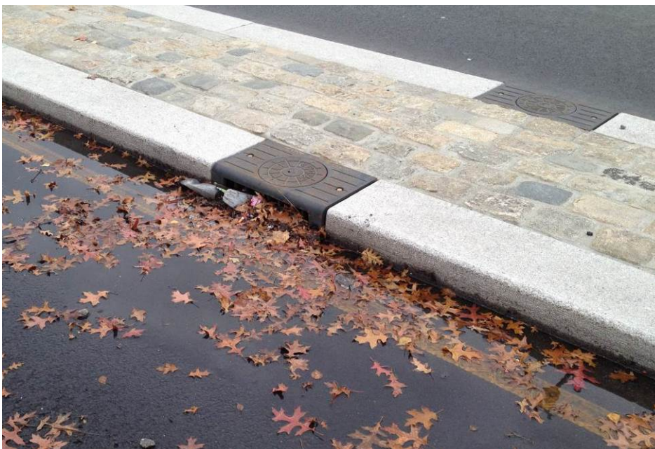
Figur 11-4 Kjeftsluket fylles med blader og søppel som stenger for vannet
