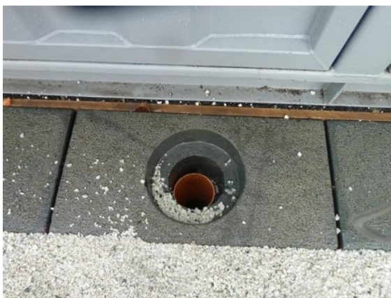
Figur 4-23 Lufterør i kantstein før topplata i støpejern er lagt på. Lufterør med lokk ferdig montert.
