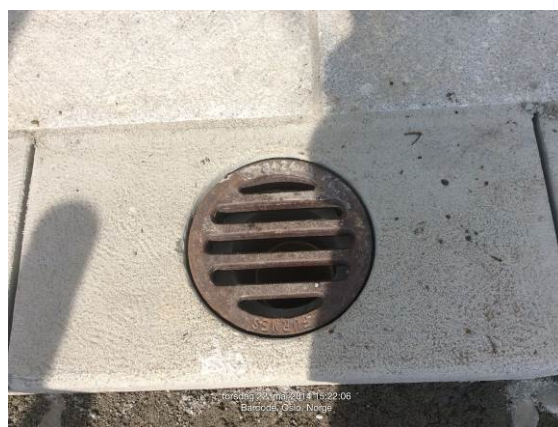
Figur 4-23 Lufterør i kantstein før topplata i støpejern er lagt på. Lufterør med lokk ferdig montert.
