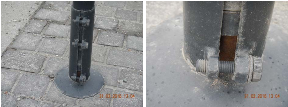
Figur 9-10 Bildet til venstre er det ordinære festet, mens til høyre vises hylse med 20 mm bolt med forspenning (bolten er skjult i mastefestet).
