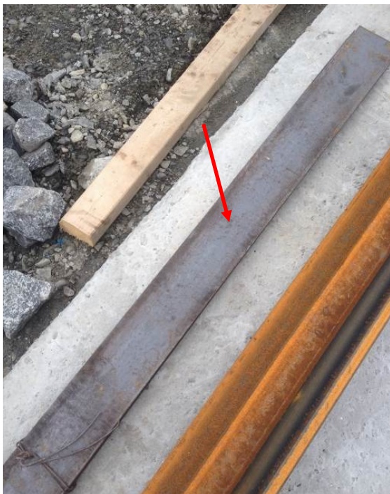
Figur 6-5 I overgangen mellom asfalt og svart betong ble det lagt 6 mm flattstål påsveiset Ø12 armering
