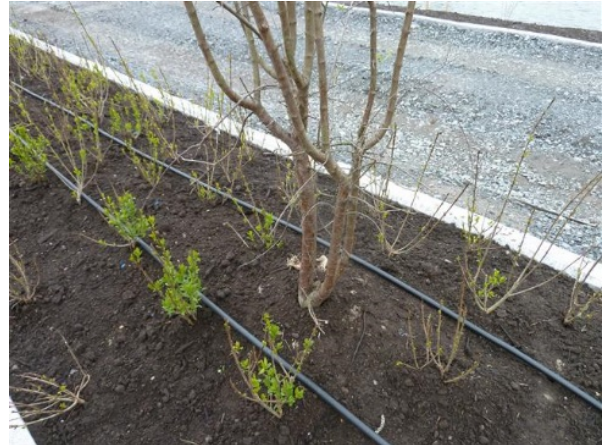
Figur 4-24 Vanningsanlegget ble lagt på toppen av plantekassene (etter en revisjon i byggeperioden).
