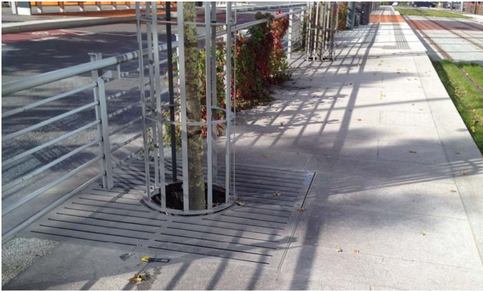
Figur 7-4 Tregruberister rundt trærne gjør arealet rundt trærne trillevennlig, men det har problemer med rust på overflatene etter kort tid i drift.
