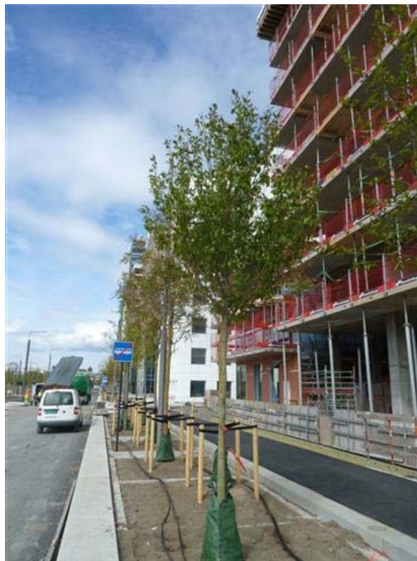
Figur 4-25 Manuell vanning med slange og vanningssekker var nødvendig etter planting før det permanente vanningsanlegget var operativt.
