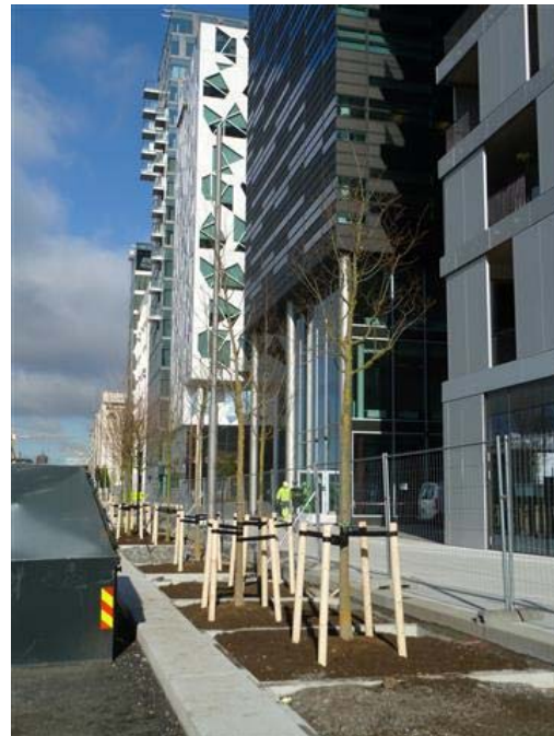
Figur 4-4 Oppstøtting med trestokker ble valgt framfor forankring med rotanker. Det er store krav til nøyaktighet i montering for at det skal fremstå ryddig.
