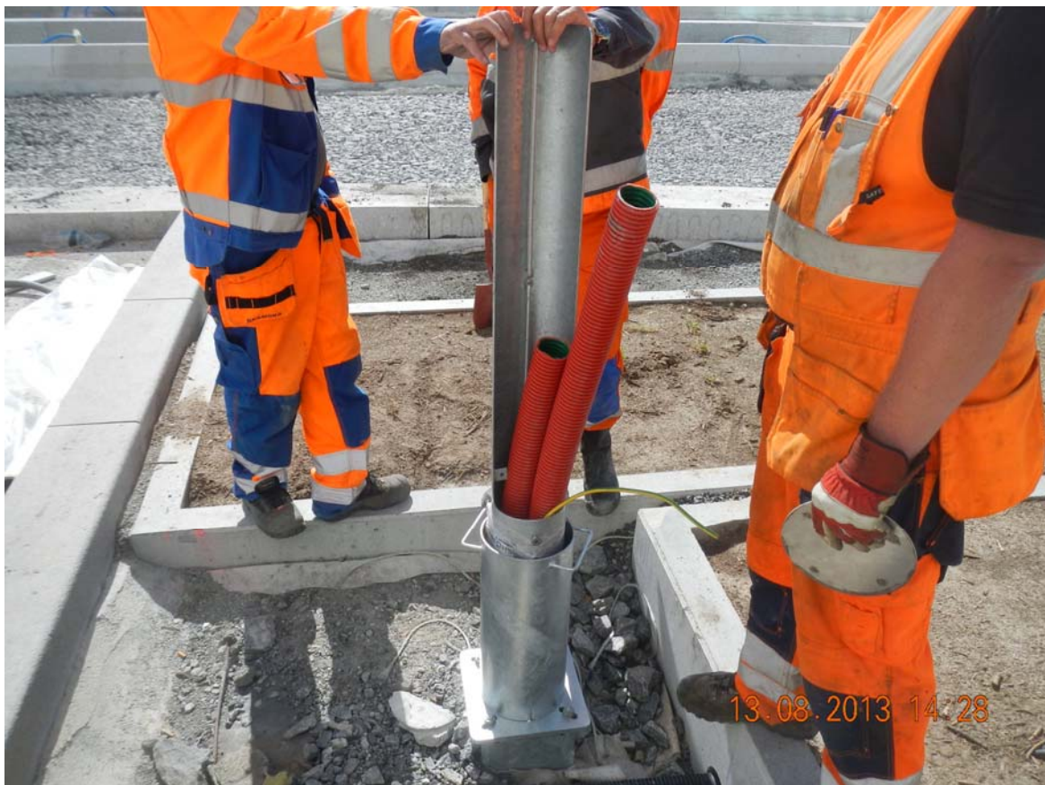
Figur 9-7 Hylserør for lysstolpe
