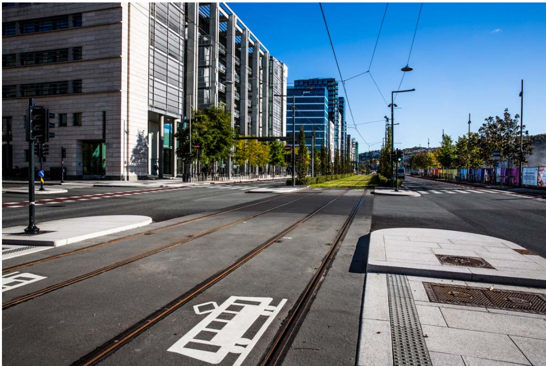
Figur 8-2 Ulike toleranser for montering av stein i nedsenket og legging av asfalt skapte utfordringer. (Foto: Camilla Jensen)
