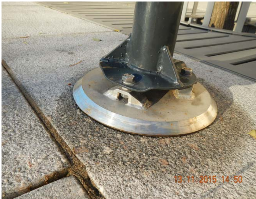
Figur 9-9 Vi modifiserte stolpefotfundament levert av Euroskilt med rustfri plate (egen patent)
