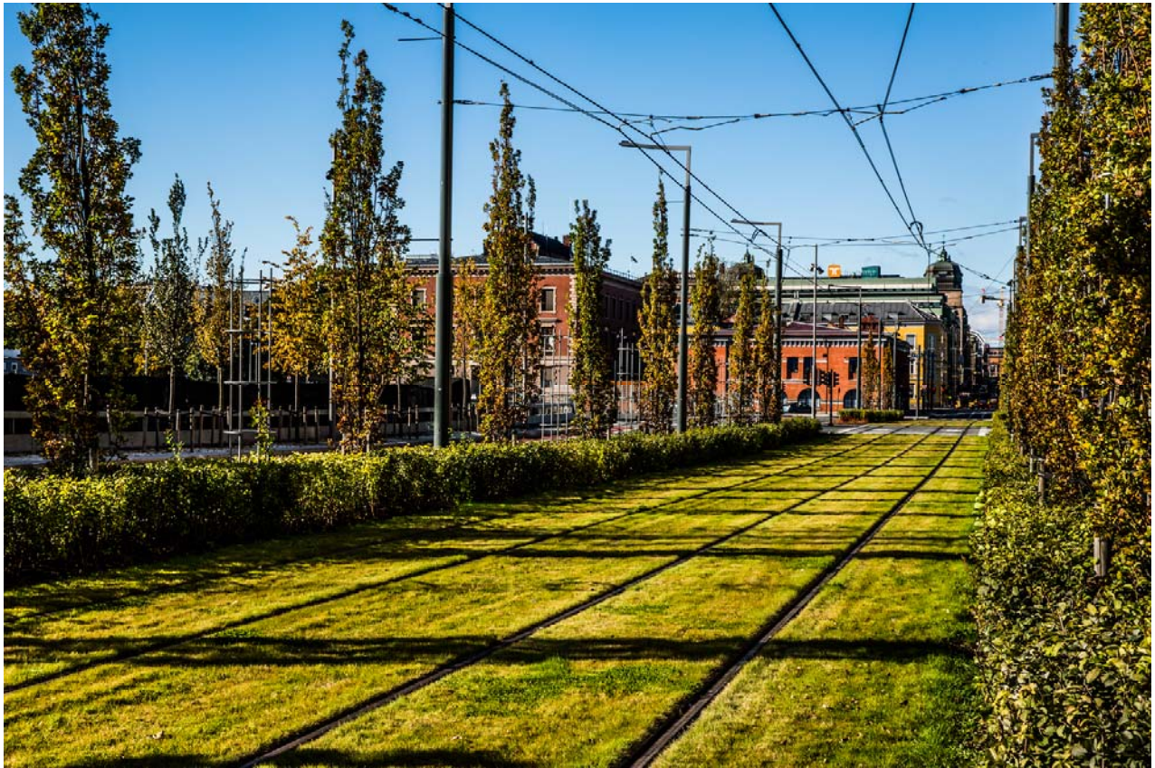
Figur 4-9 I midten av gaten er trikkesporet lagt i et gressdekket hekk på begge sider. (Foto: Camilla Jensen)
