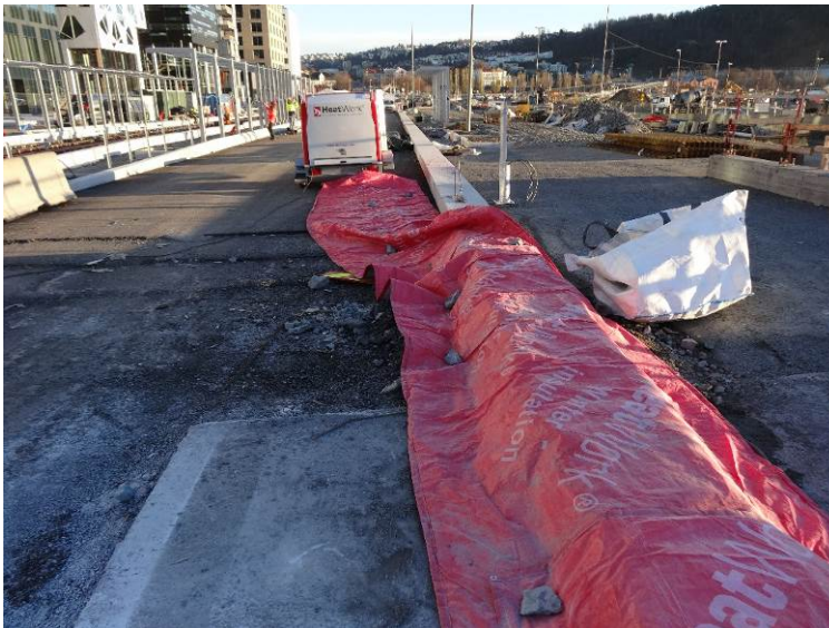
Figur 5-30 «Ground heater» samt tildekking
