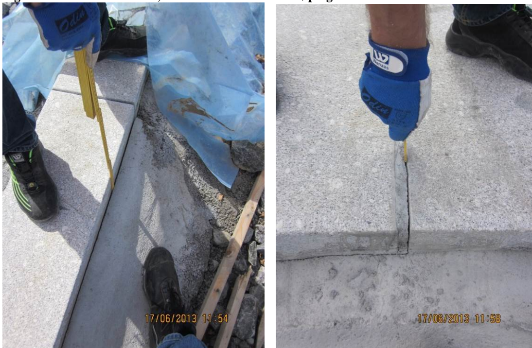
Figur 5-15 .... og det gir som resultat manglende vedheft mellom mørtel og stein
