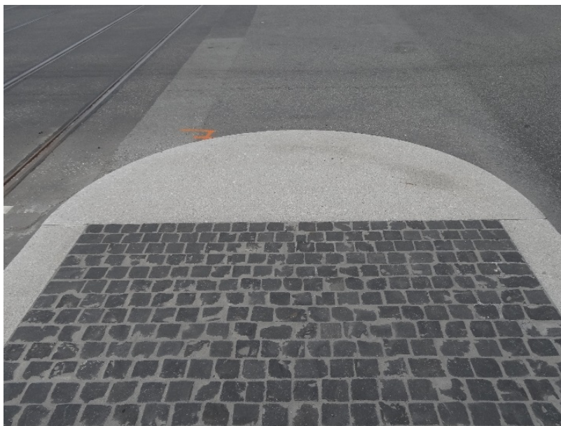
Figur 5-19 Store endeelementer er mer solide enn en kant med krum kantstein.
