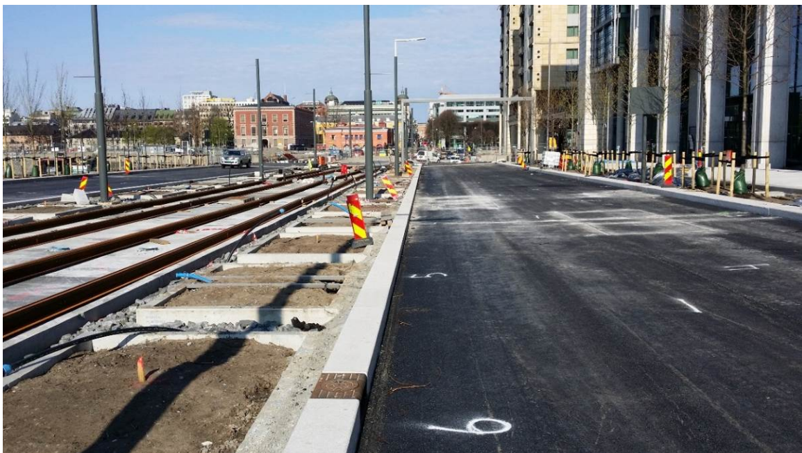
Figur 13-6 Trikkesporet er plassert midt i gaten med vegbaner på begge sider.
