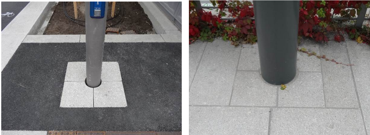
Figur 5-21 Elementdetaljer tilslutninger master, uansett dekk
