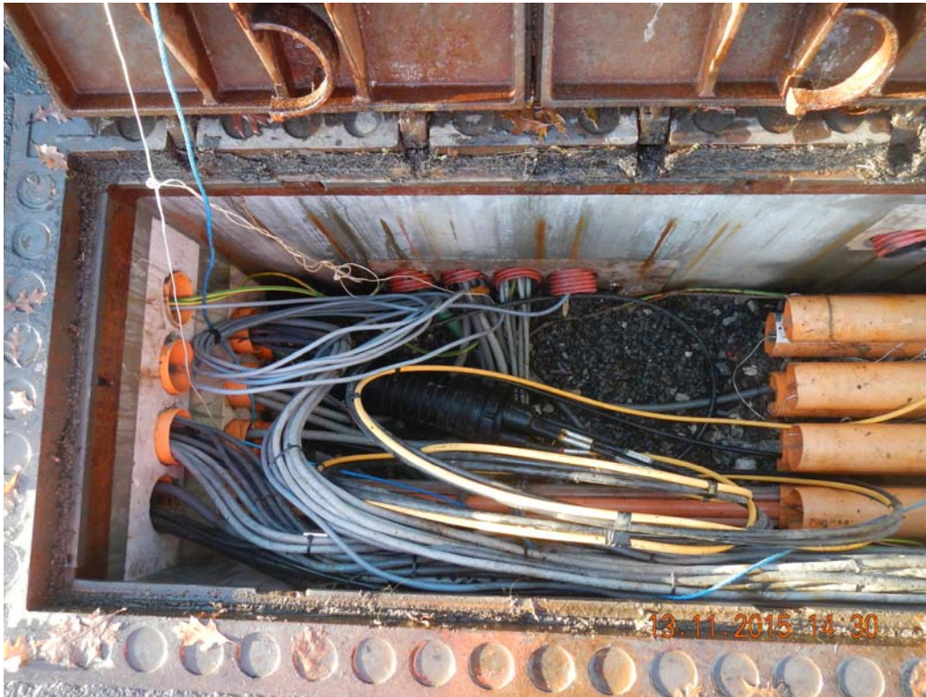
Figur 9-2 Ferdig montert trippelkum
