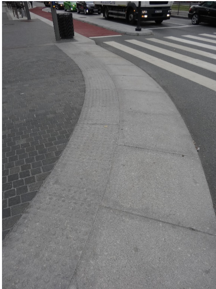
Figur 5-11 Spesiellagde elementer i grå granitt i radius
