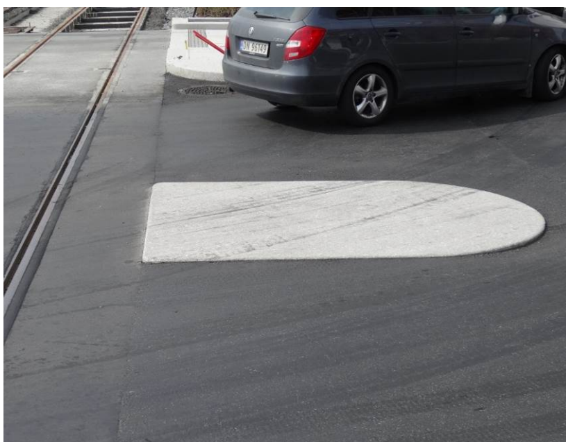
Figur 5-20 Overkjørbare elementer av granitt, en solid og varig løsning
