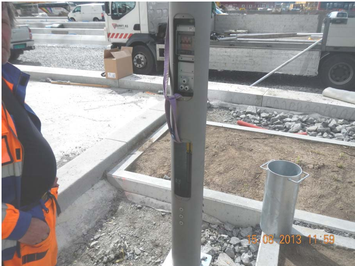
Figur 9-8 Ferdig montert lysstolpe
