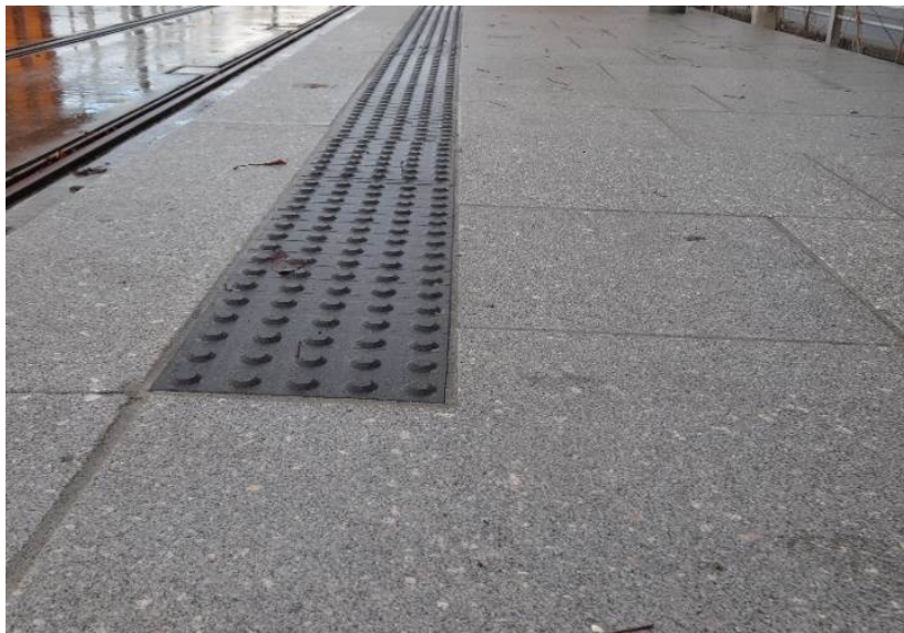
Figur 5-9 Taktile heller i naturstein, høy funksjonalitet og utmerket kontrast.
