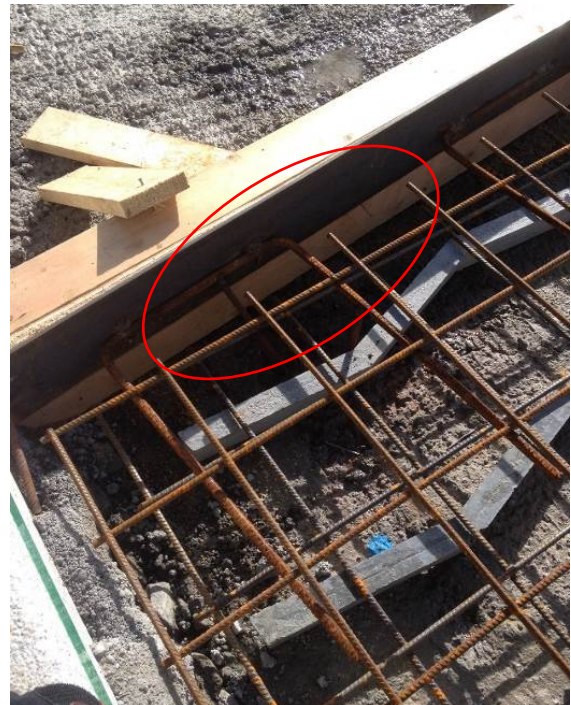
Figur 6-5 I overgangen mellom asfalt og svart betong ble det lagt 6 mm flattstål påsveiset Ø12 armering
