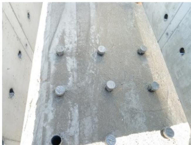
Figur 4-19 I betongplata under plantekassene var det installert 10-12 plastrør for å opprettholde hull gjennom betongplata. Disse måtte dekkes i byggeperioden inntil jordfylling. Da ble beskyttelsen fjernet, og hullene som hadde blitt tette, måtte stakets opp.
