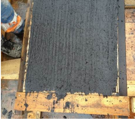
Figur 6-6 Ulike avrettingsmetoder: Avretting med kost til venstre og avretting med brettskuring til høyre
