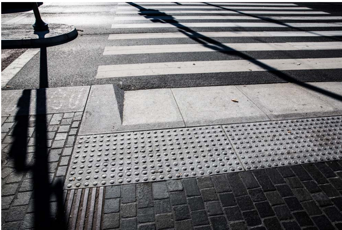
Figur 8-3 Eksempel på taktilt felt og ledelinje. I dette varselfeltet viser knottene retningen på gangfeltet. Flere bilder av knottefelt er vist i kapittel 5.2.5 om utforming av taktile heller og ledelinjer. (Foto: Camilla Jensen)
