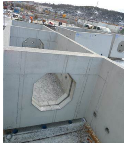
Figur 4-18 Plassering av sammenhengende plantekasser. Plantekassene som står inntil hverandre har store hull i endeveggen slik at røttene spre seg i et større volum.
