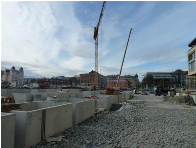
Figur 4-18 Plassering av sammenhengende plantekasser. Plantekassene som står inntil hverandre har store hull i endeveggen slik at røttene spre seg i et større volum.
