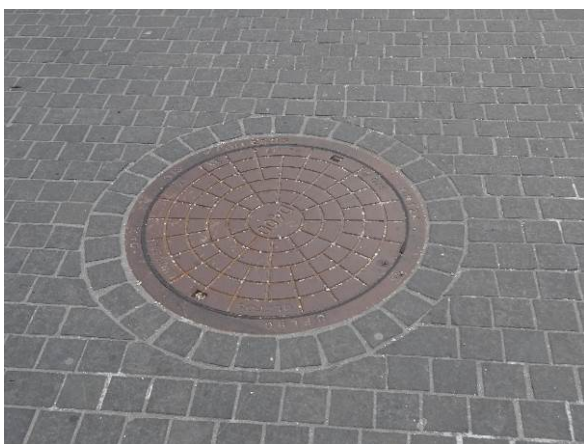
Figur 5-8 Et «rulleskift» rundt konstruksjoner i steindekke er en god fagmessig utførelse
