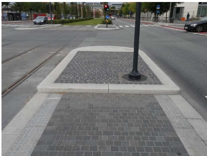
Figur 5-6 Sidearealer som f.eks. ved overgangene utført med råkilt smågatestein i basalt.
