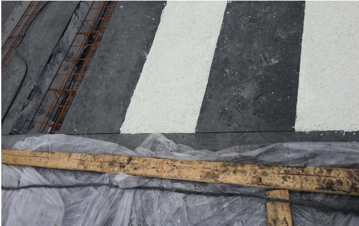
Figur 6-4 Bildet viser ny støpt hvit betong (før stålglatting), ekstra armering og sagde fuge i svart betong
