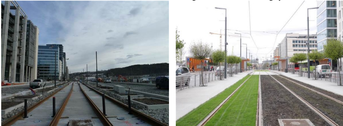
Figur 4-20 Trikketraseen før og etter legging av kjøresterke kassetter. Kassettene er fylt med jord og tilsådd med grasfrø
