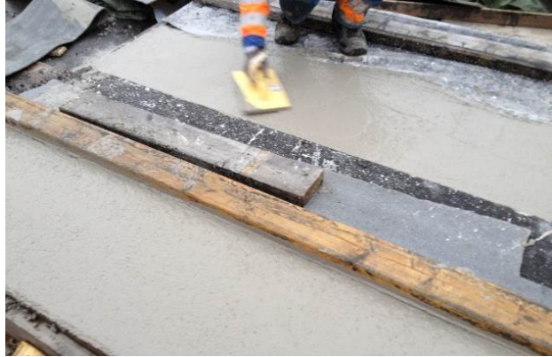
Figur 6-6 Ulike avrettingsmetoder: Avretting med kost til venstre og avretting med brettskuring til høyre
