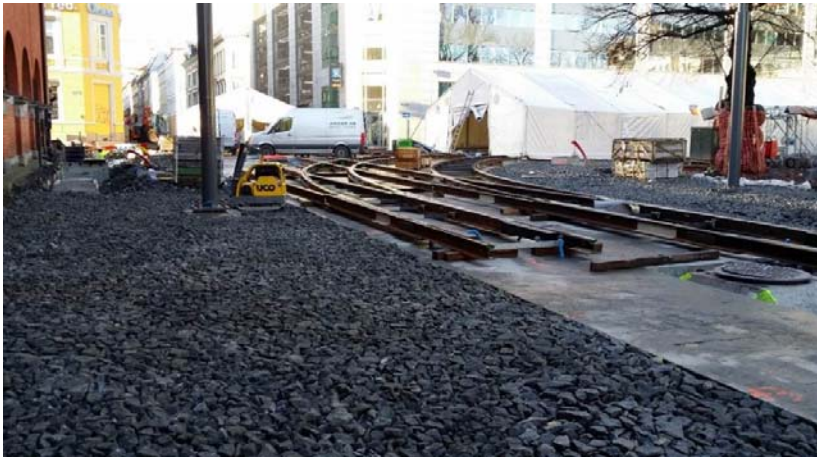
Figur 13-2 Sporveksel Strandgata og Prinsensgate
