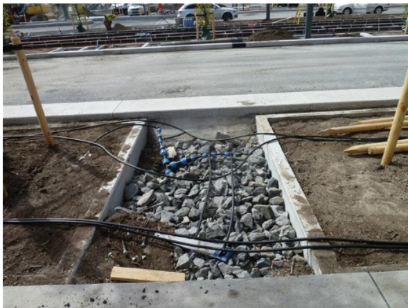
Figur 4-24 Vanningsanlegget ble lagt på toppen av plantekassene (etter en revisjon i byggeperioden).
