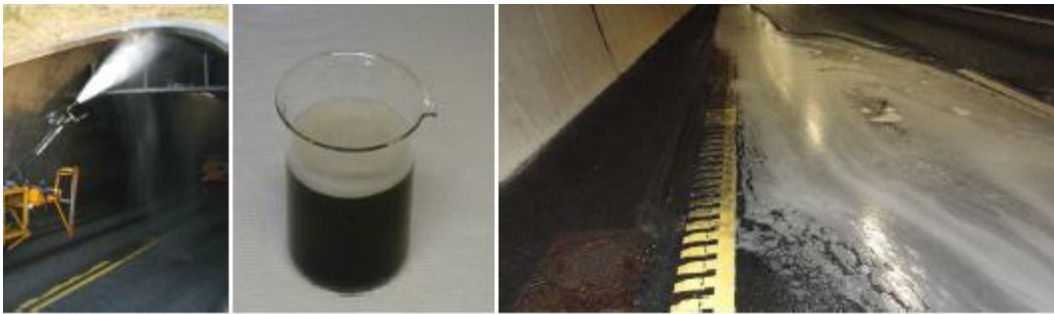
Figur 2. Vasking av Nordbytunnelen aug. 2014 med bruk av såpe/vaskemiddel (Vik et al, 2015).
