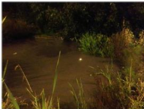
Figur 1. Nordbytunnelen 3,8 km, 4 felt til høyre og sedimenteringsbasseng til venstre øvre bilde. Nedre bildet viser vannkvaliteten i bassenget umiddelbart etter at det er fylt med nytt vaskevann under prøvetakingen i august 2014 (Åstebøl og Vik, 2014).
