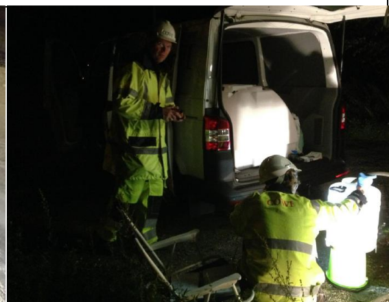
d) Oppsamling av råvannsprøver av vaskevannet utenfor pumpestasjonen.
