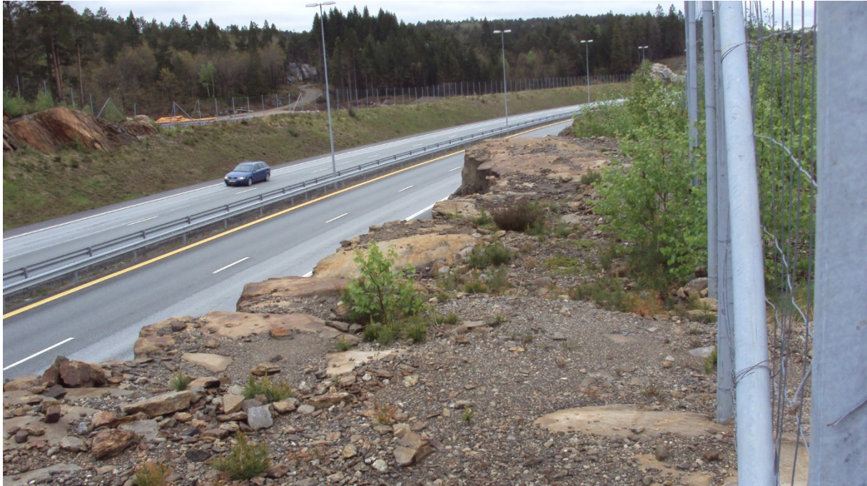
Figur 16. Vegskjeringa langs E18 rett sør-vest for deponi M13 er lagt i typisk rusta svovelførende gneis. Lys bergart i neste vegskjering i bakgrunnen er tonalittisk gneis. Deponert stein ligg under vegbanen og på sørsida av E18 (Foto: Per Hagelia).
