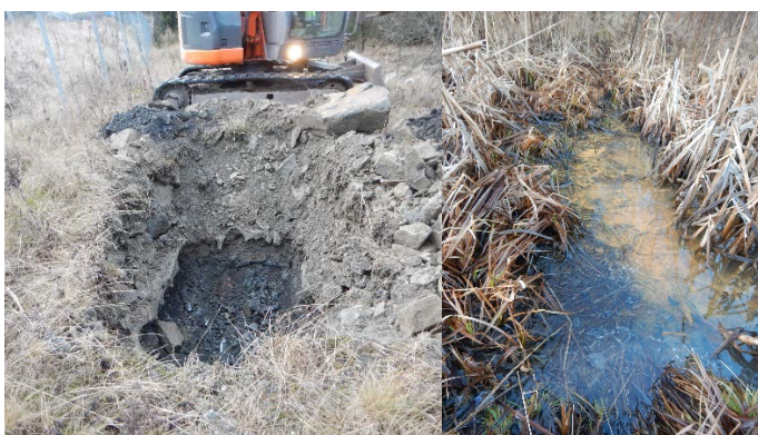
Figur 22. Bilete til venstre viser graving av sjakter for å undersøke deponert skifer på Taraldrud. Bilete til høgre viser sigevatn påverka av alunskifer (Foto: Halldis Fjermestad).
