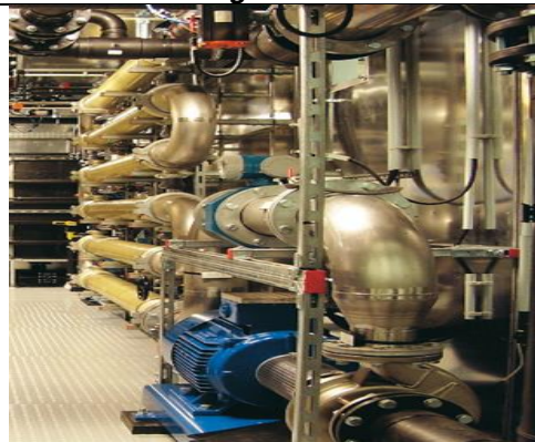
d. Membranfilteranlegg; her kan benyttes nanofiltrering (NF), ultrafiltrering (UF; 0,1-5 \times 10^{-3} \mu\text{m} ), mikrofiltrering (MF) eller omvendt osmose (RO, fjerning av salt)
