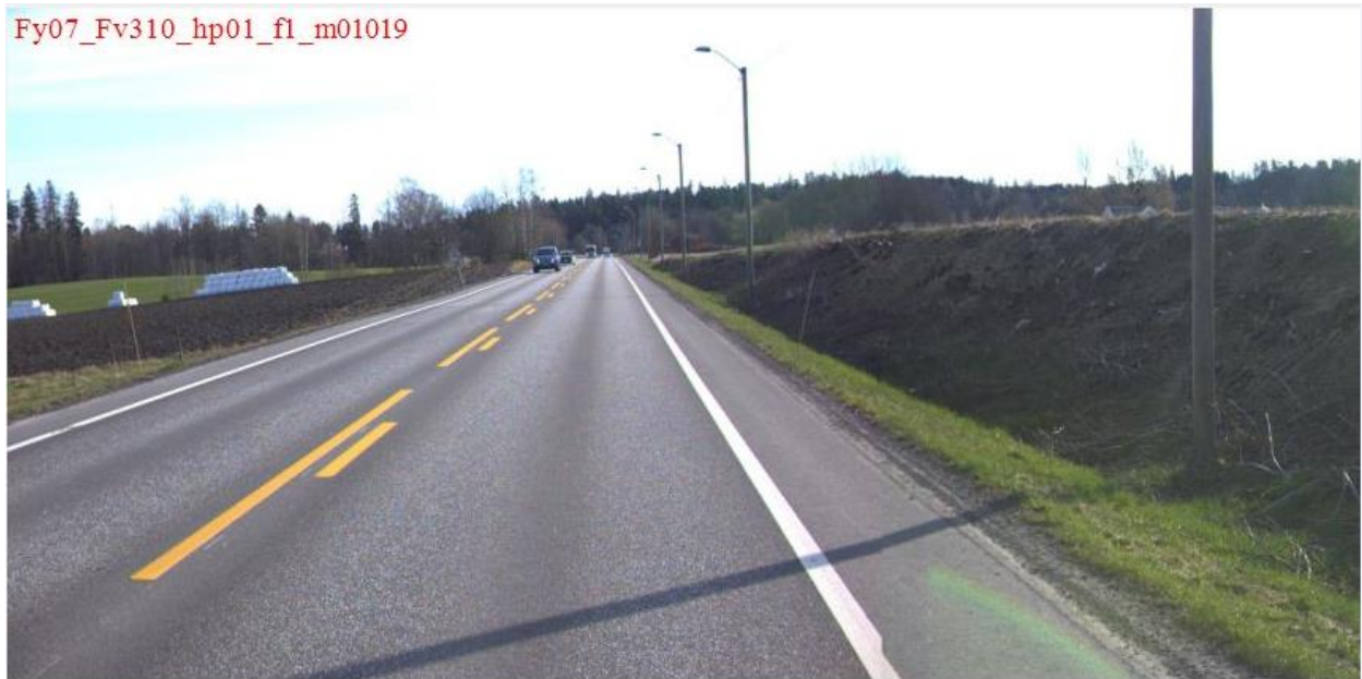
Figur 9. Fv. 310, hp01, m 1019_20.4.16. Ab11. Nytt dekke ble lagt i begge felt juni 2015.
