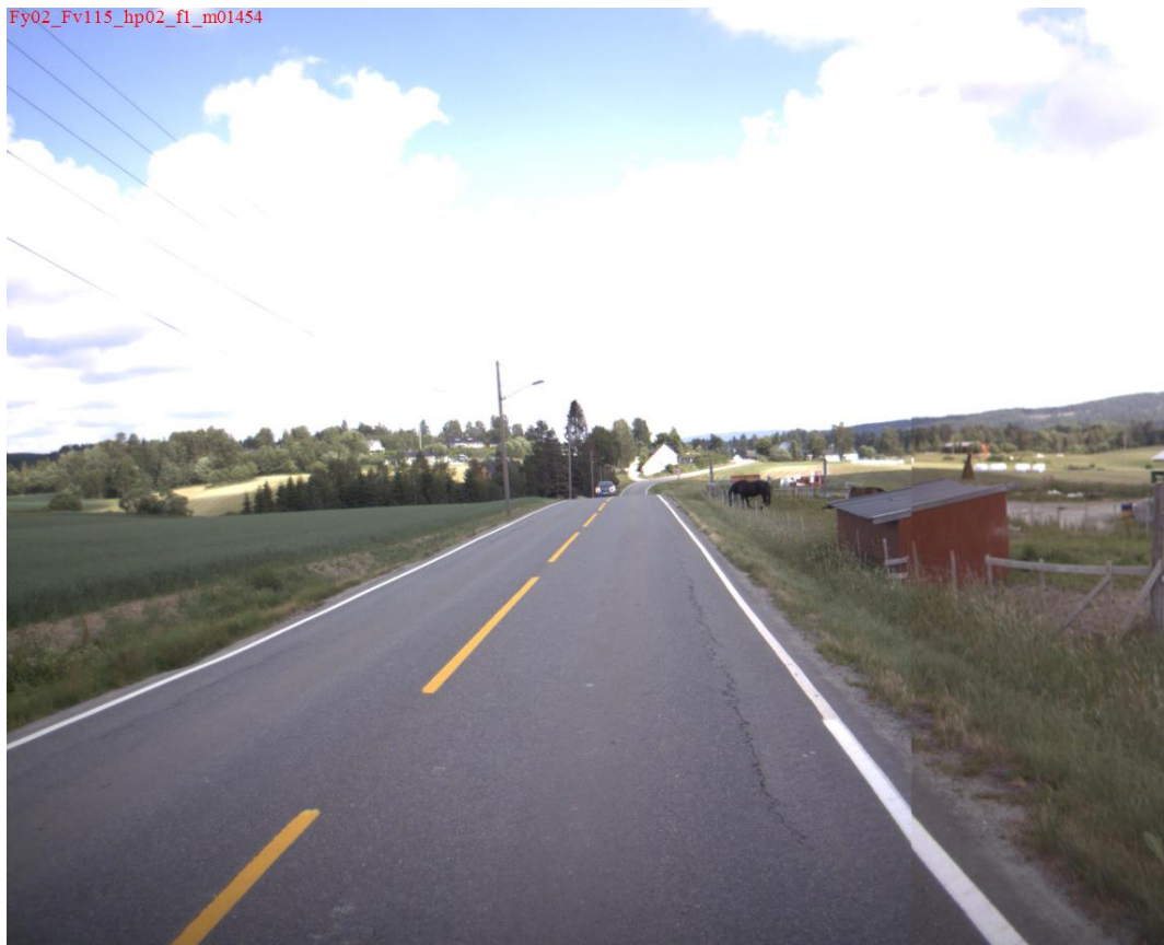
Figur 19. Fv. 115, hp02, m 1454_23.6.16. Ab11 referanse i felt 1. Svak vegkant som gir høy sporverdi.
