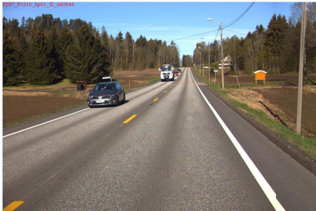
Figur 11. Fv. 310, hp01, m 3044_4.5.16. Nytt dekke (Ab11) ble lagt i begge felt i 2015.
