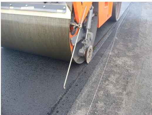
Figur 11 Bilde av klemhjul på vals og bilde av kantsprøyte for påføring av bitumen på skjõt.
