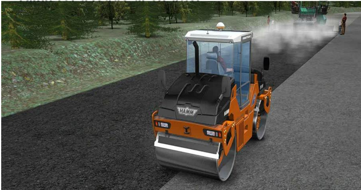
Figur 8 Animasjon av asfaltutlegging kan tydeliggjøre behovet for valsekapasitet
