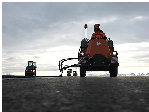
Figur 11 Bilde av klemhjul på vals og bilde av kantsprøyte for påføring av bitumen på skjõt.
