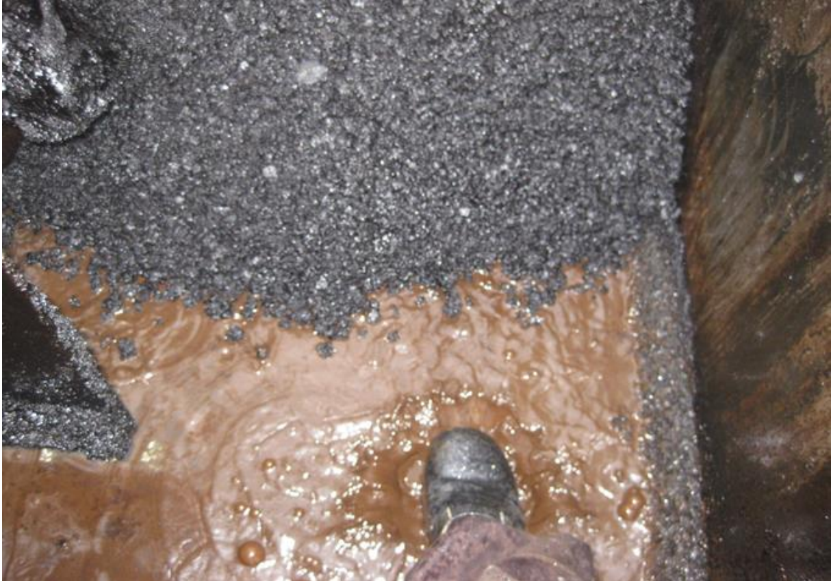
Figur 12 Asfalt blir lagt under ugunstige forhold. Bilde tatt ved skruer foran screeden ved utlegging.
