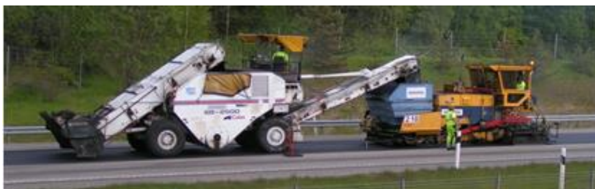
Figur 6 Formating av utlegger med Shuttle Buggy 3)
