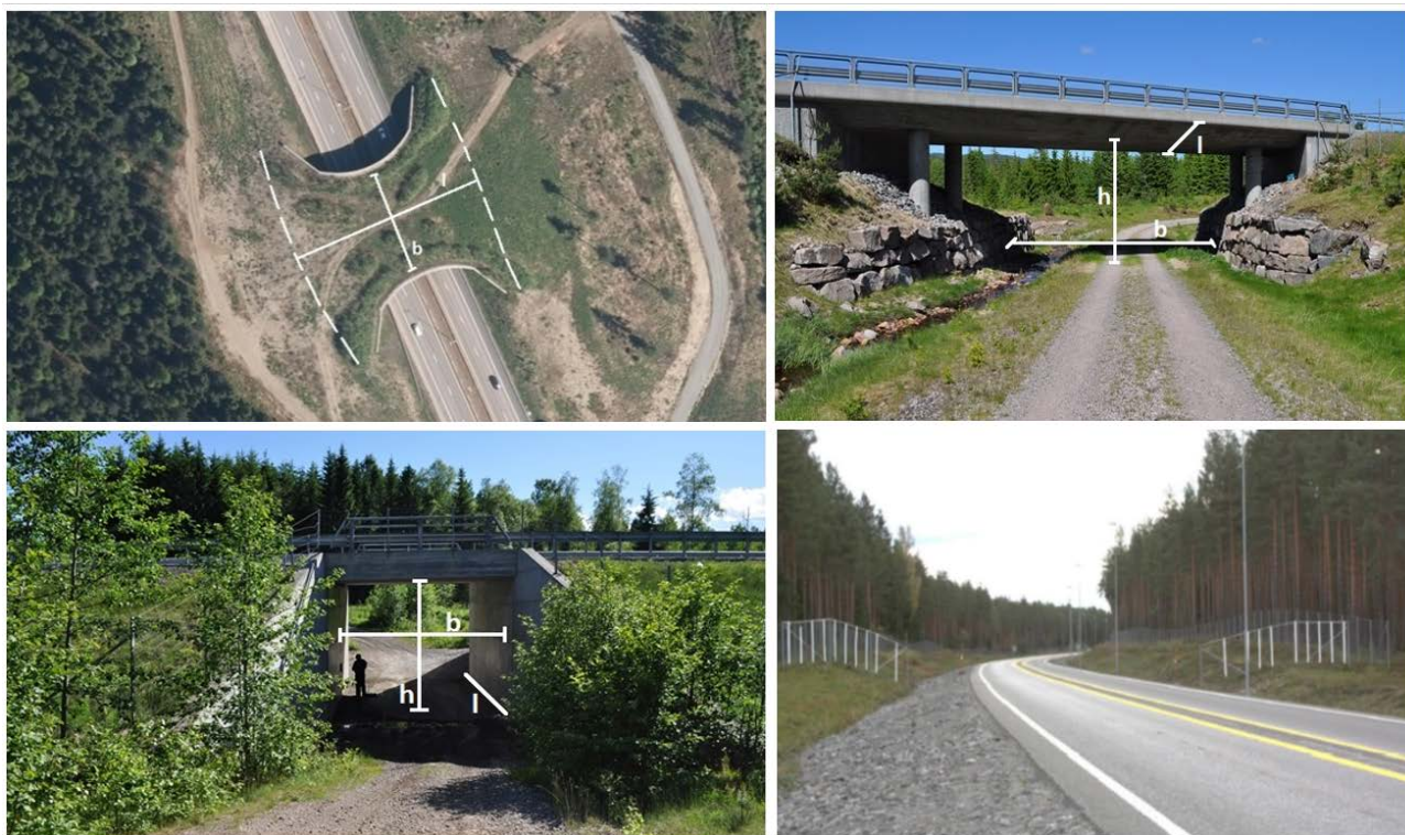
Figur 2.1.1. Illustrasjon av overgang (oppe til venstre), undergang (oppe til høyre), kulvert (nede til venstre) og viltsluse (nede til høyre). Foto: Ole Roer og Skouen m.fl. (2011).
