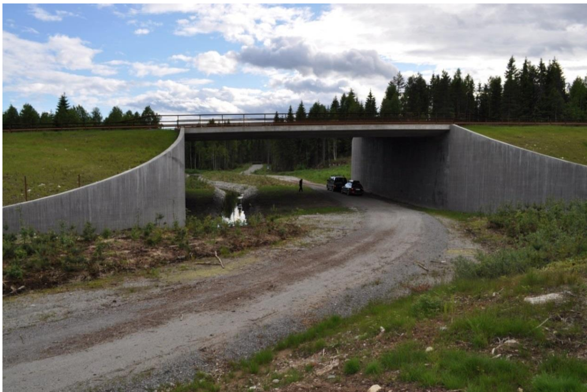
Figur 1.7. Grevlingmyra undergang. Foto. Ole Roer
