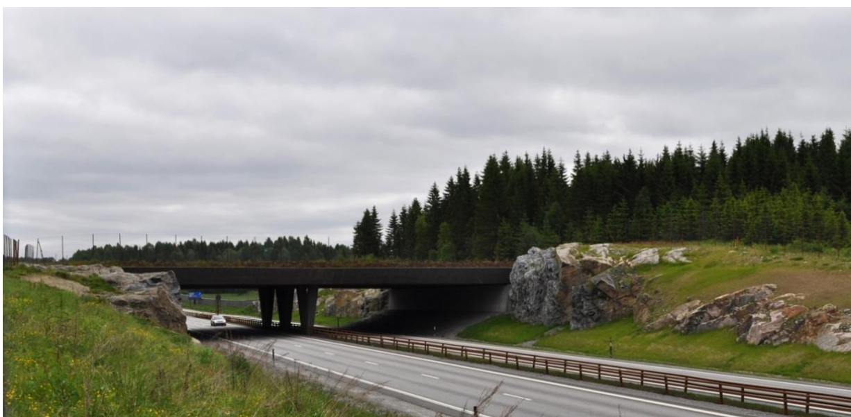
Figur 1.12. Bogsrud overgang. Foto. Ole Roer
