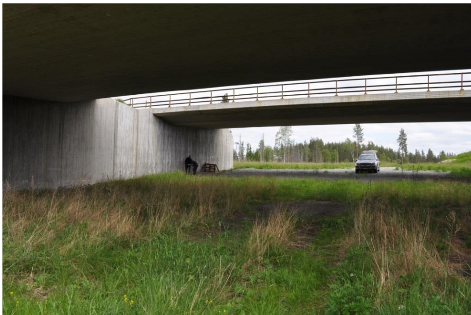
Figur 1.16 Sørli undergangen er en dobbelt bru der det slippes inn lys ovenfra. Foto. Ole Roer
