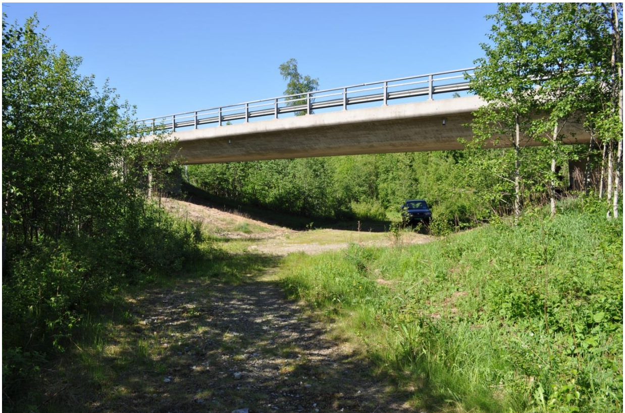
Figur 1.18 Bjørkåsen undergang. Foto. Ole Roer
