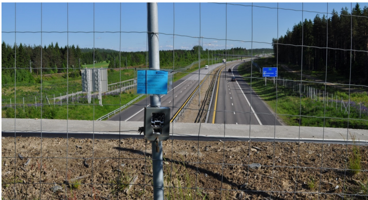
Figur 2.2.1. Viltkamera på overgangen «Mogreina» langs E6 i Ullensaker kommune. Foto: Ole Roer
