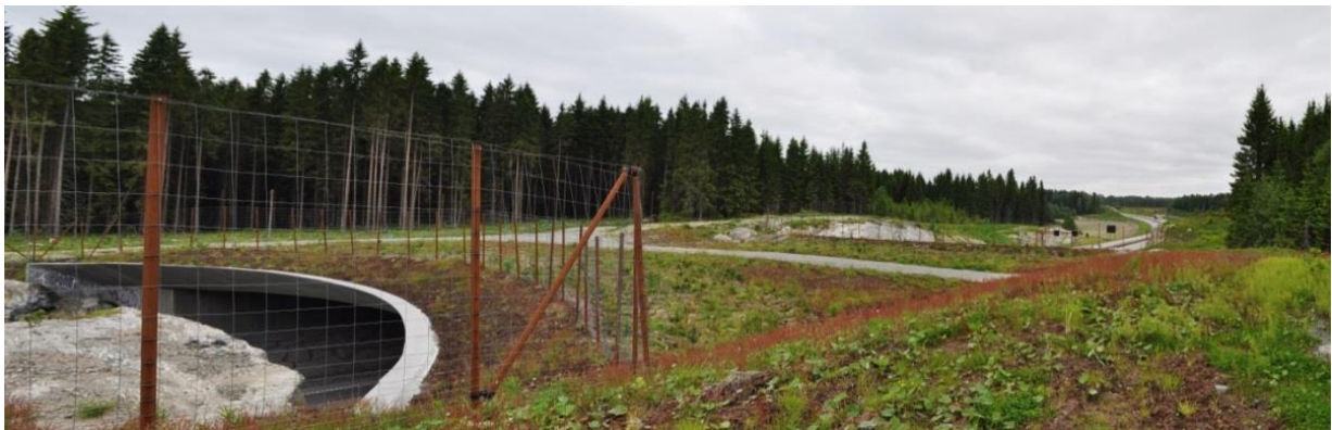
Figur 1.11. Bogsrud overgang. Foto. Ole Roer
