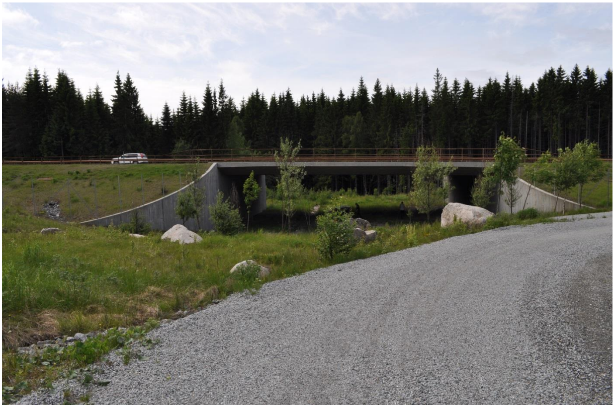
Figur 1.13. Hov undergang. Foto. Ole Roer
