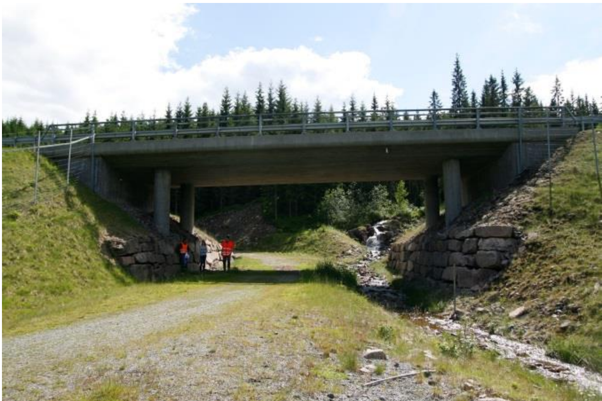
Figur 1.22. Sørlivegen undergang. Foto. Mathilde H. Skarsjø
