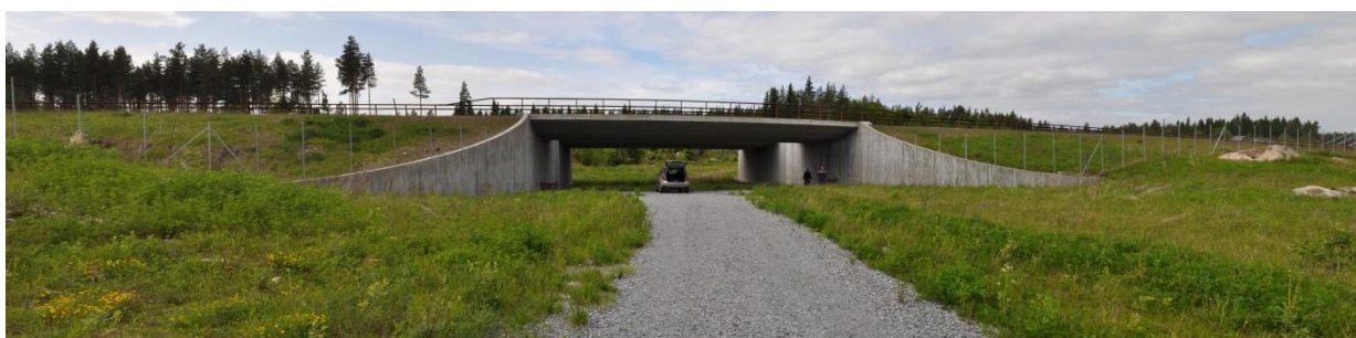
Figur 1.17 Sørli undergang. Foto. Ole Roer
