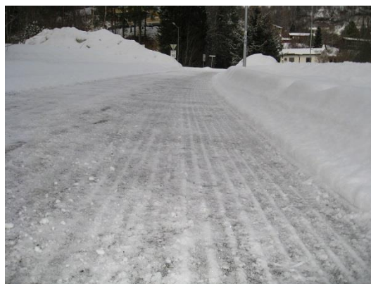
Figur 8. Høvlet med tannet skjær. Foto: Øystein Larsen, Statens vegvesen
