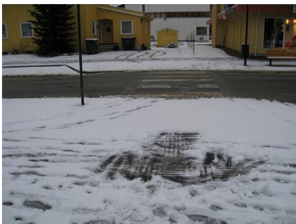
Figur 10. Dårlig standard på taktil merking. Foto: Øystein Larsen, Statens vegvesen
