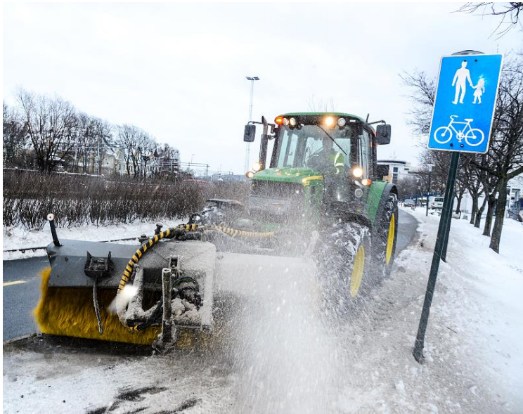
Figur 7. Kosting av g/s-veg. Foto: Knut Opeide, Statens vegvesen
