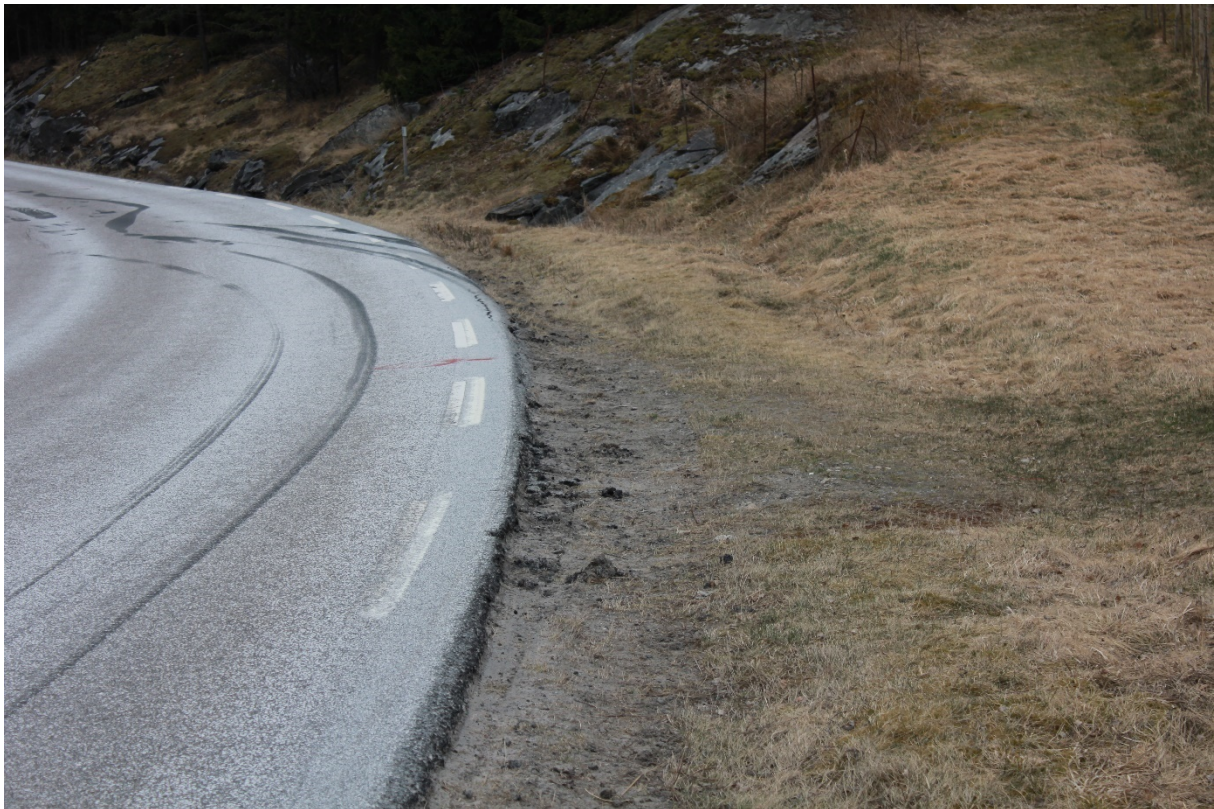
Figur 31 Høye asfaltkanter har vært medvirkende faktorer (i tillegg til andre faktorer) til ulykker i vest 2018. Kilde Statens vegvesen
