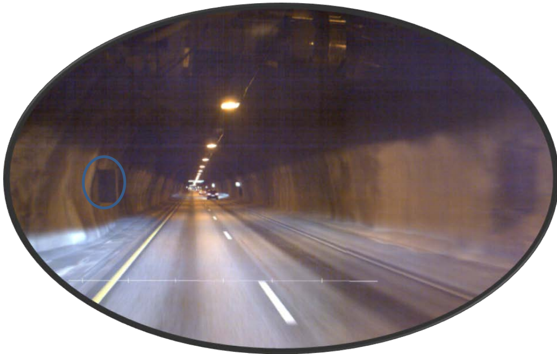
Figur 26 Bildet viser ulykkessted der varebil traff skilt for variable fartsgrenser. Skiltet er festet 1,5 m over bakken og en meter fra kantlinjen. Kilde Statens vegvesen
