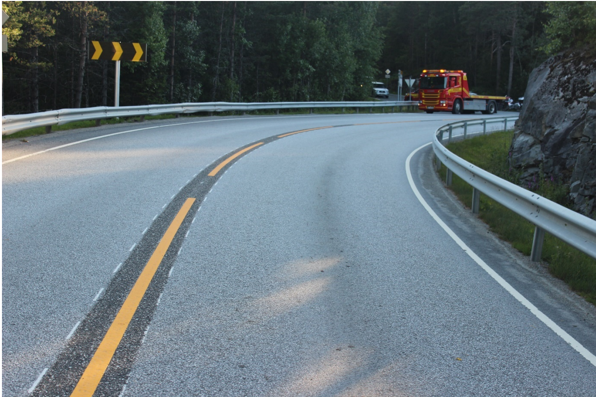
Figur 22 Bildet viser kurve med begrenset fremoversikt, der det også er et kryss midt i kurven. Kilde Statens vegvesen
