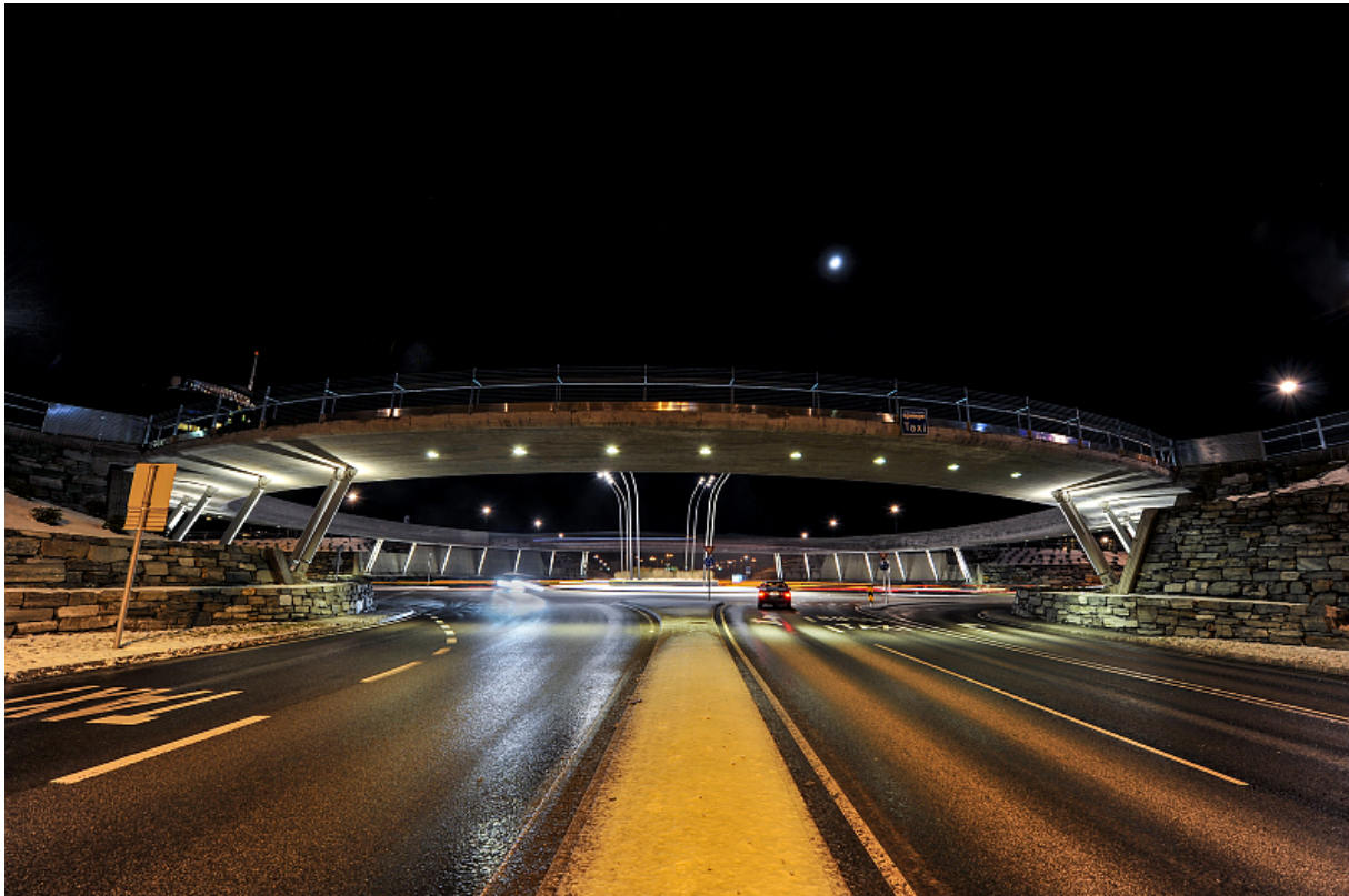
Figur 6 Bilde av planfri kryssing for fotgjengere og syklister. Kilde Statens vegvesen
