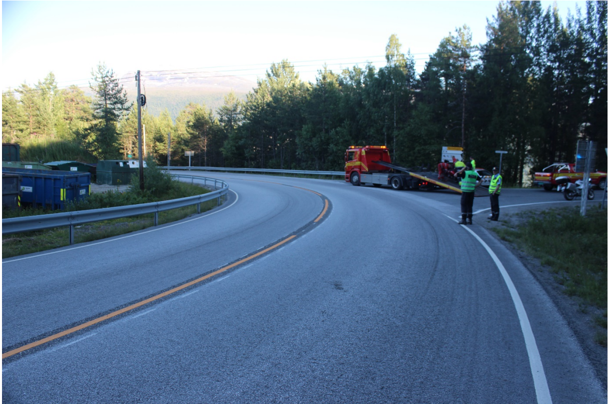
Figur 23 Samme kurve sett i motsatt kjøreretning. Kilde Statens vegvesen
