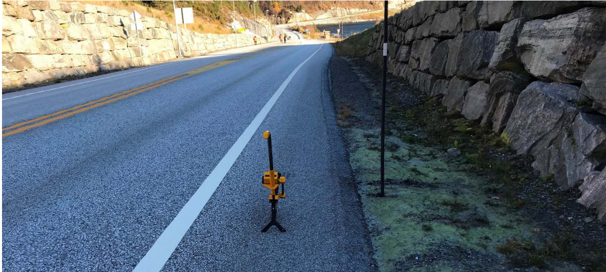
Figur 32 Bilde viser en god løsning på asfaltkant som kan forhindre brå retningsendring (over i motgående kjørefelt) når en bil havner utfor asfaltkant og svinger opp igjen på vegen. Kilde Statens vegvesen
