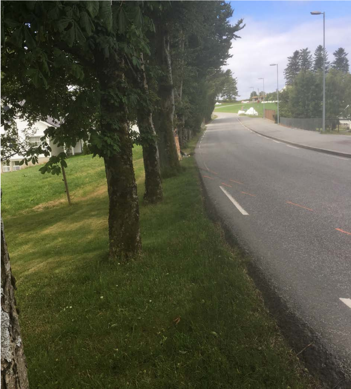
Figur 27 Bilde viser farlig sideterreng, med trær tett opp mot vegen i kurve. Kilde Statens vegvesen
