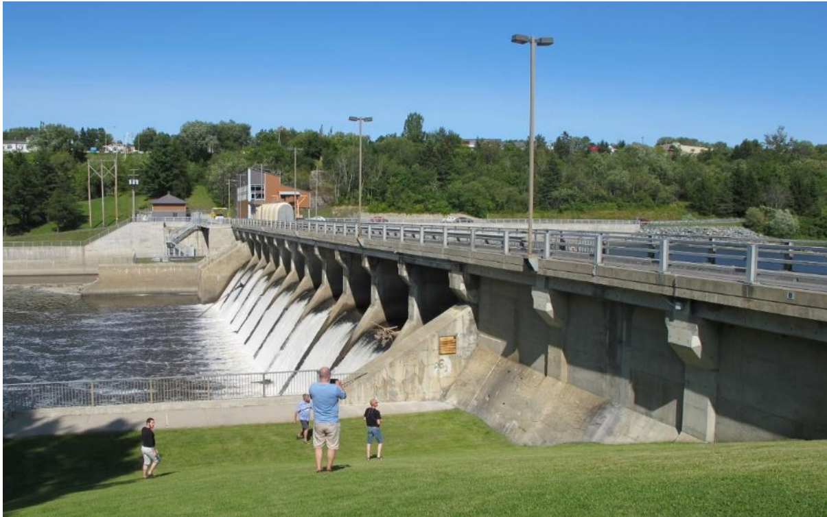
Figur 29 Oversikt nedstrøms side av Sartigan dam. (Foto: Eva Rodum)
