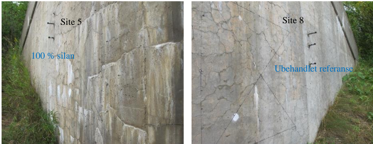
Figur 40 5th Parkway (Robertson Road) bridge over I-396. Site 5 (100 % silan) til venstre, Site 8 (referanse) til høyre. Målefelt for overflateriss og RF-målere (montert i 3 dybder). (Foto/ill.: Eva Rodum)
