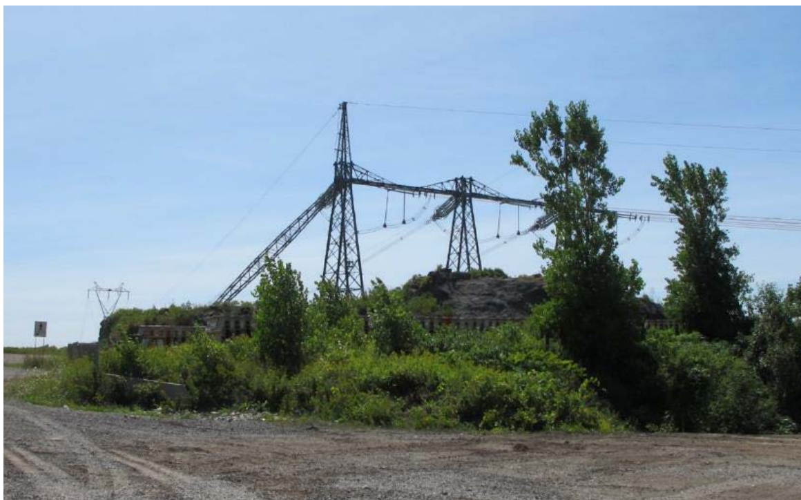
Figur 32 Oversikt stål mastefundament med betongfundamenter reparert i 1986-87. (Foto: Eva Rodum)
