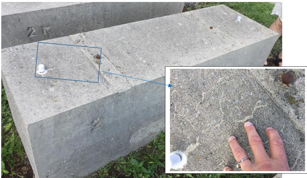
Figur 8 Uarmert blokk med 18 % FA (blanding 2), med nærfoto av toppflate. Begynnende opprissing. (Foto: Børge J. Wigum)
