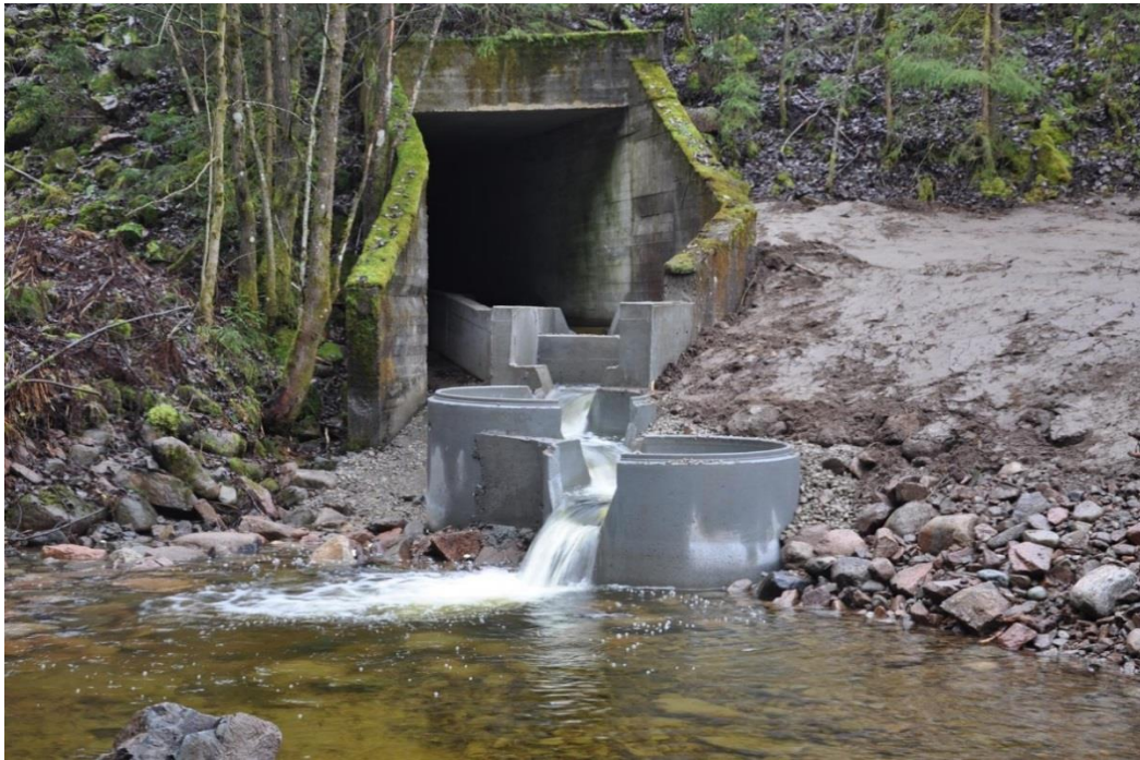
Fig. 34. Laksetrapp og betongringer ved utløpet av kulverten i Sarumelva (Foto: Statens vegvesen Region sør).
