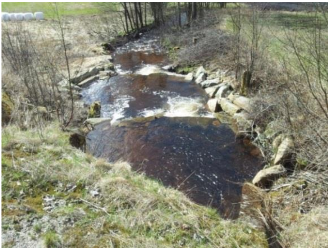
Fig. 47. To terskler satt opp nedstrøms kulvertutløpet. Dette har hevet vannspeilet og ført til gode vandringsforhold for fisk gjennom kulverten (Foto: Steinar Ånesland).
