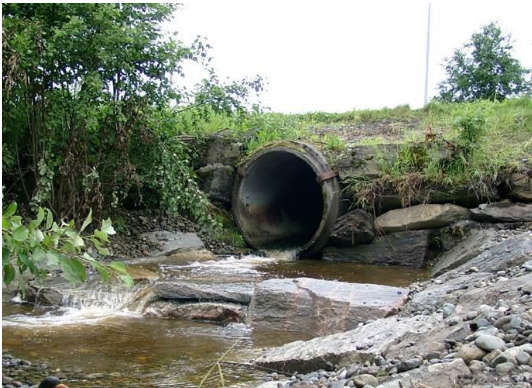
Fig. 56. Terskelen anlagt nedstrøms kulverten i Hamremselva har bidratt til hevet vannspeil og redusert spranget ved utløpet av kulverten (Foto: Statens vegvesen Region midt).
