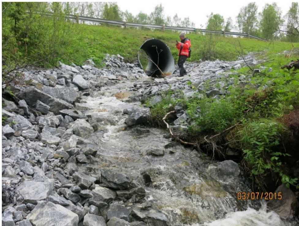
Fig. 75. Gode vandringsforhold for fisk opp renna nedstrøms terskelen opp til terskelbassenget (Foto: Lars Aage Gade-Sørensen).
