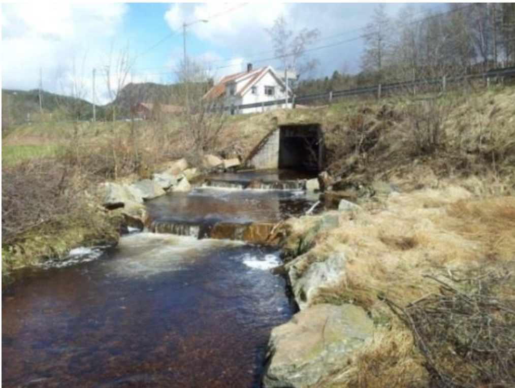
Fig. 46. To terskler er bygget nedstrøms kulvertutløpet i Breibekk. Terskelen nærmest kulverten hever vannspeilet slik at spranget fra utløpet av kulverten er fjernet (Foto: Steinar Ånesland).
