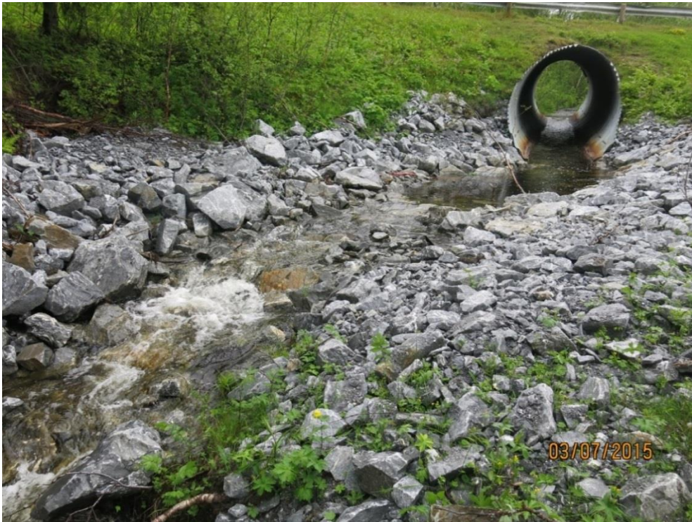
Fig. 74. Nedstrøms kulverten i Tenna er det anlagt terskel. Dette har resultert i hevet vannspeil og fallet ved utløpet er eliminert. God erosjonssikring langs sidene (Foto: Lars Aage Gade-Sørensen).
