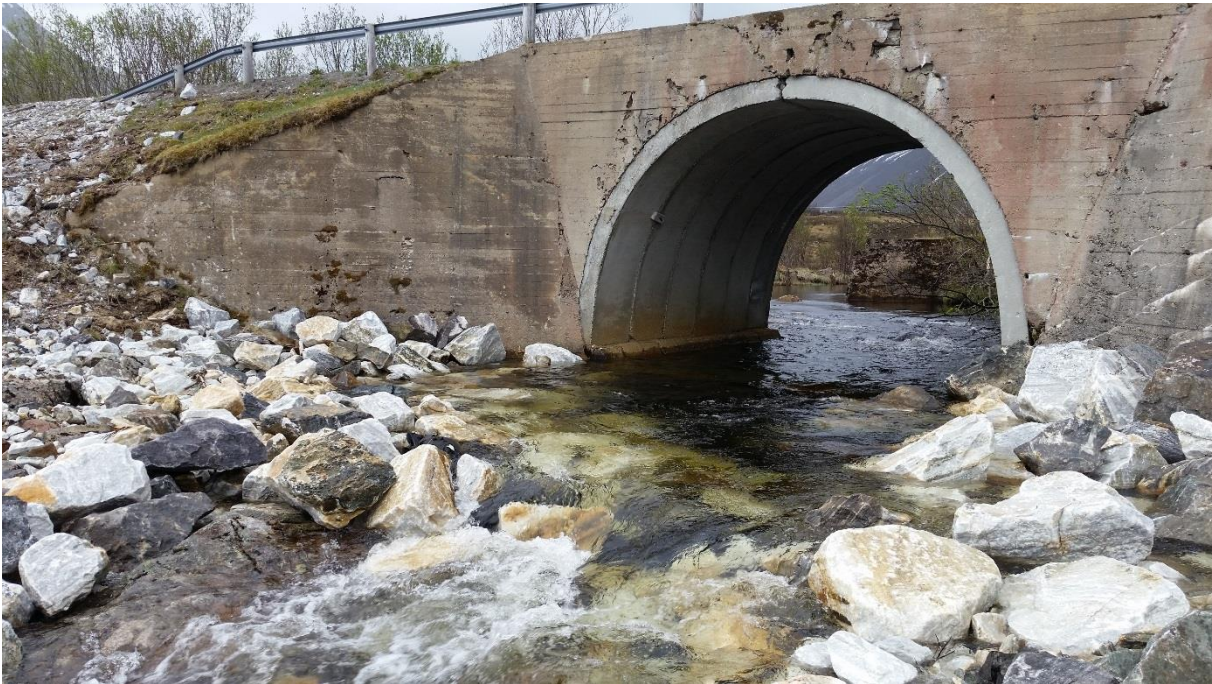
Fig. 77. Terskel anlagt nedstrøms utløpet i kulverten. Etter utbedringen står vannspeilet nå inn i kulverten, redusert vannhastighet og gode forhold fiskevandring (Foto: Øyvind Haugland).
