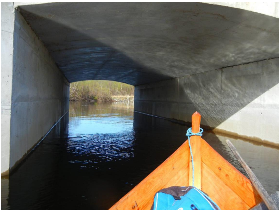
Fig. 85. Kulverten i Savkadasjohka. Etter utbedringen er det mulig å ferdes gjennom med kano eller elvebåt (Foto: Nils Aslak Boine).
