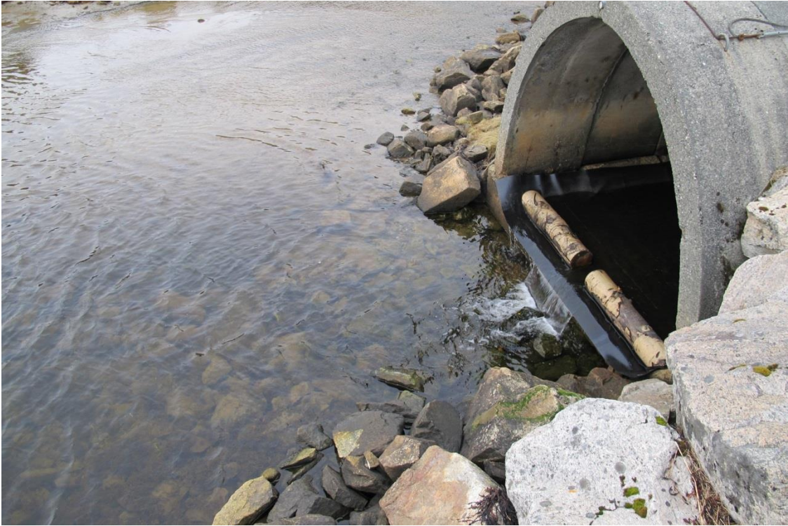
Fig. 60. Ospestokker er montert ved utløpet og inni kulverten. På flo står vannet inn i kulverten. Bildet er tatt på fjære sjø. Forsterket med duk ved utløpet (Foto: Øyvind Haugland).
