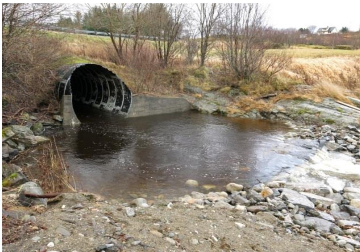
Fig. 58. Terskel er bygget på brekket slik at vannspeilet er hevet og står inn i kulverten. Gode vandingsforhold for fisk (Foto: Lars Aage Gade-Sørensen).
