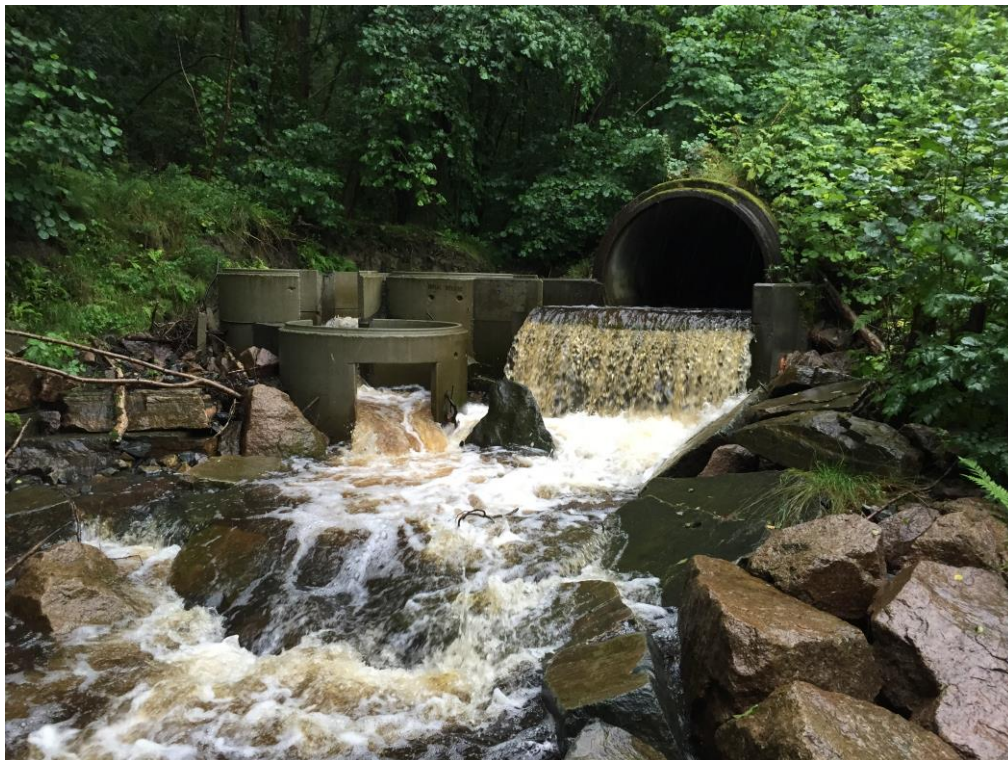
Fig. 43. Betongringer med åpen kant ble montert nedstrøms utløpet i Sævelibekken. God kulp nedstrøms den nederste ringen. Utbedringen har resultert i gode vandringsforhold for fisk gjennom kulverten (Foto: Paul Ridola).
