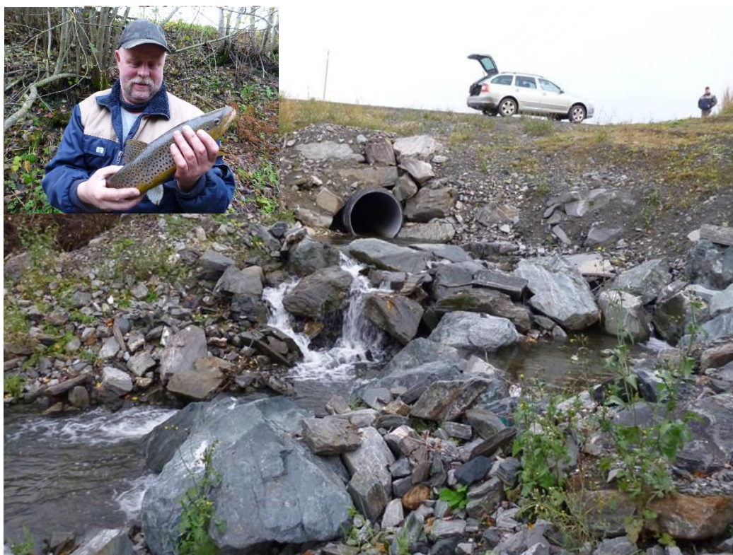
Fig. 52. Terskel anlagt nedstrøms kulvertutløpet i Follobekken. Spranget ved utløpet er fjernet og vannspeilet står inn i kulverten. Innfelt bilde viser en fornøyd grunneier med gyteklar sjørret som ble fanget oppstrøms kulverten etter utbedringen (Foto: Anton Rikstad).
