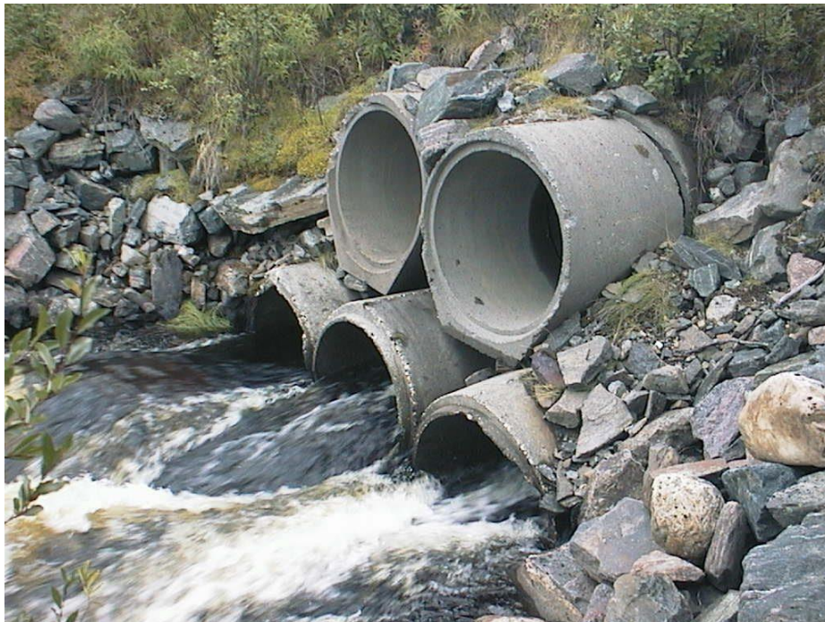
Fig. 79. Fem kulverter ved utløpet av Savkadasjohka (Foto: Knut Aune Hoseth)
