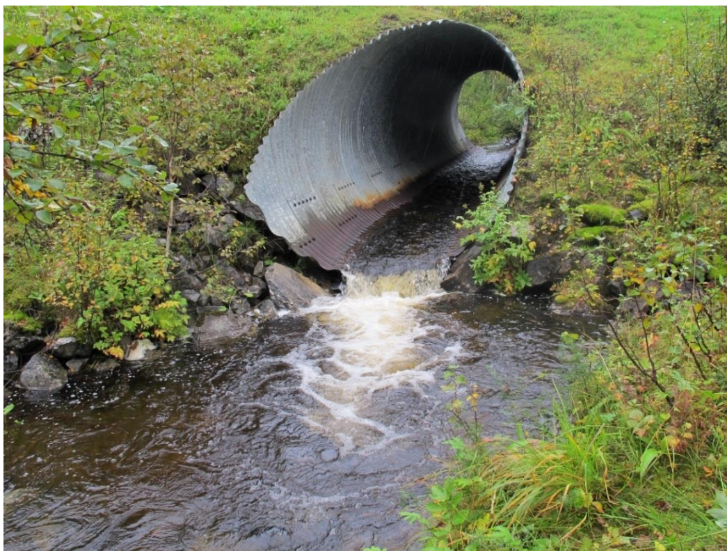
Fig. 72. Sterk strøm og sprang ved utløpet av svalbardrøret i Tenna (Foto: Øyvind Haugland).
