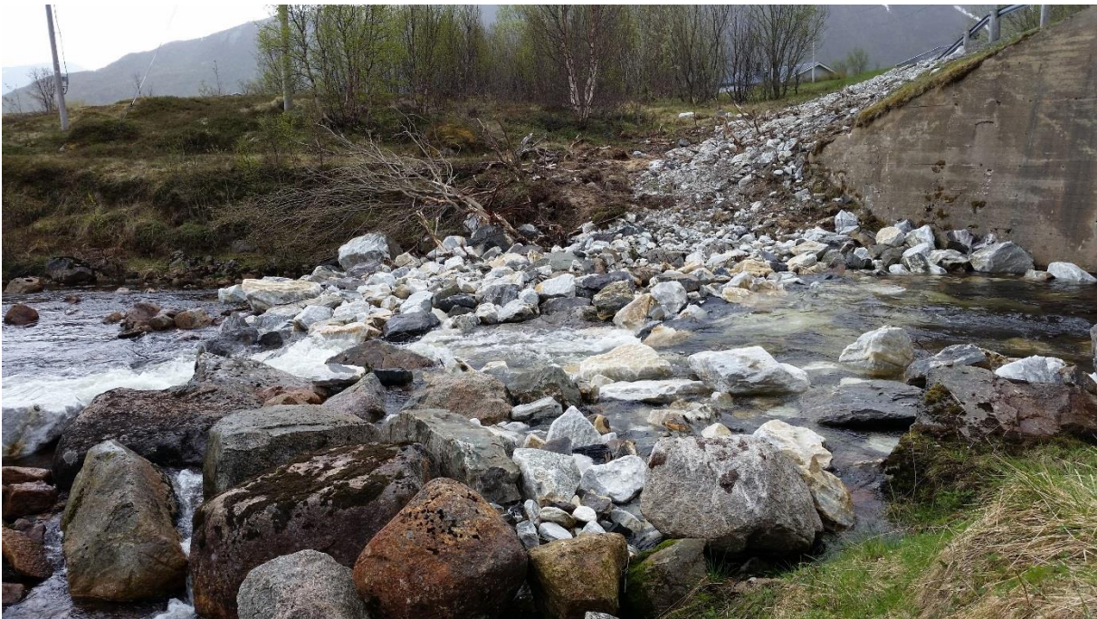
Fig. 78. God og solid terskel med anlagt fiskerenne midt i terskelkonstruksjonen. God erosjonssikring med kraftig sprengstein langs sidene (Foto: Øyvind Haugland).
