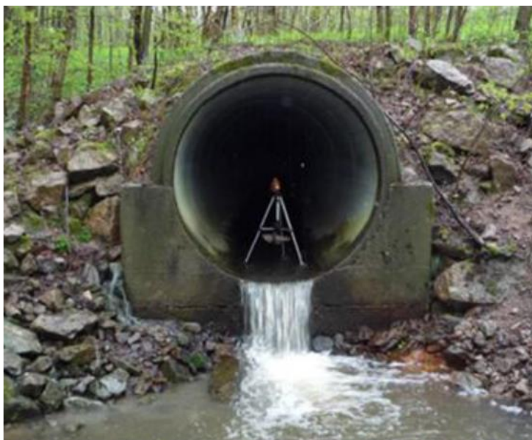
Fig. 36. Høyt fall ved utløpet av kulverten i Sævelibekken (Foto: Norconsult).
