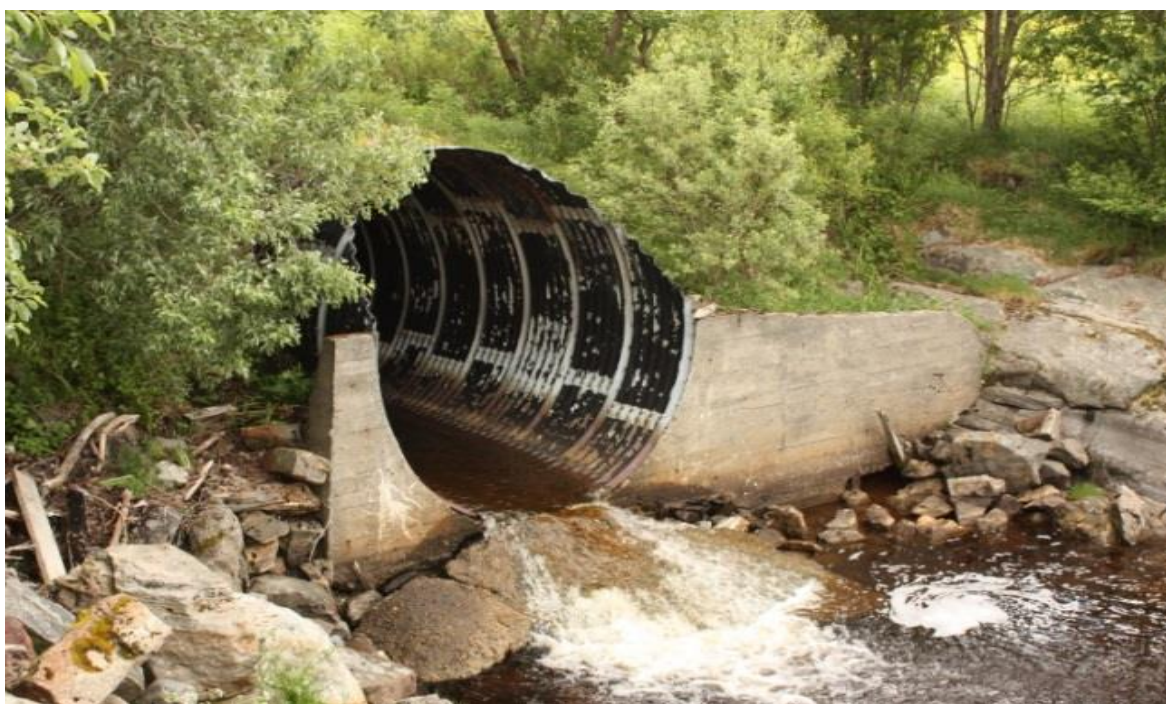
Fig. 57. Stort fall og støpt betongsåle ved utløpet i Ulvangselva (Foto: Lars Aage Gade-Sørensen).
