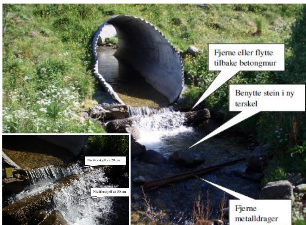
Fig. 65. Illustrasjon som viser oversikt over vandringshinderet og forslag til tiltak i Nykvågvassdraget (Illustrasjon: Knut Aune Hoseth).
