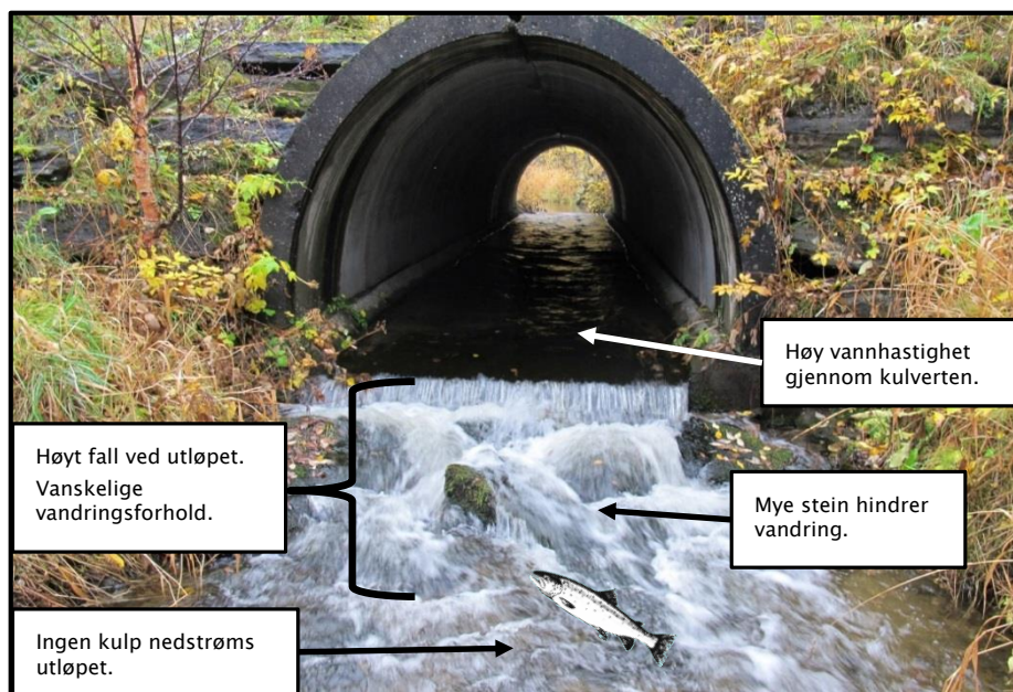
Fig. 1. Eksempel på vandringshinder for fisk ved utløpet av en kulvert (Illustrasjon: Øyvind Haugland).
