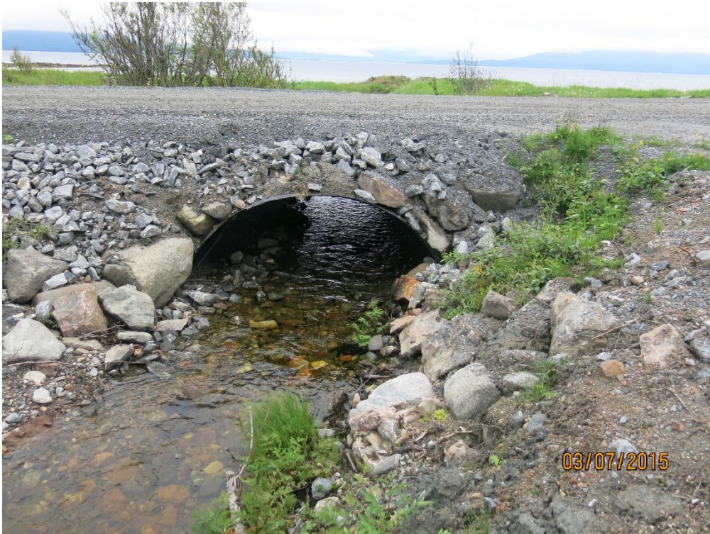
Fig. 70. I elv fra Skatvikvatnet er det anlagt en hvelvkulvert, et rør uten bunn. Den naturlige elvebunnen er bevart og det er gode vandringsforhold for fisk gjennom hvelvkulverten (Foto: Lars Aage Gade-Sørensen).
