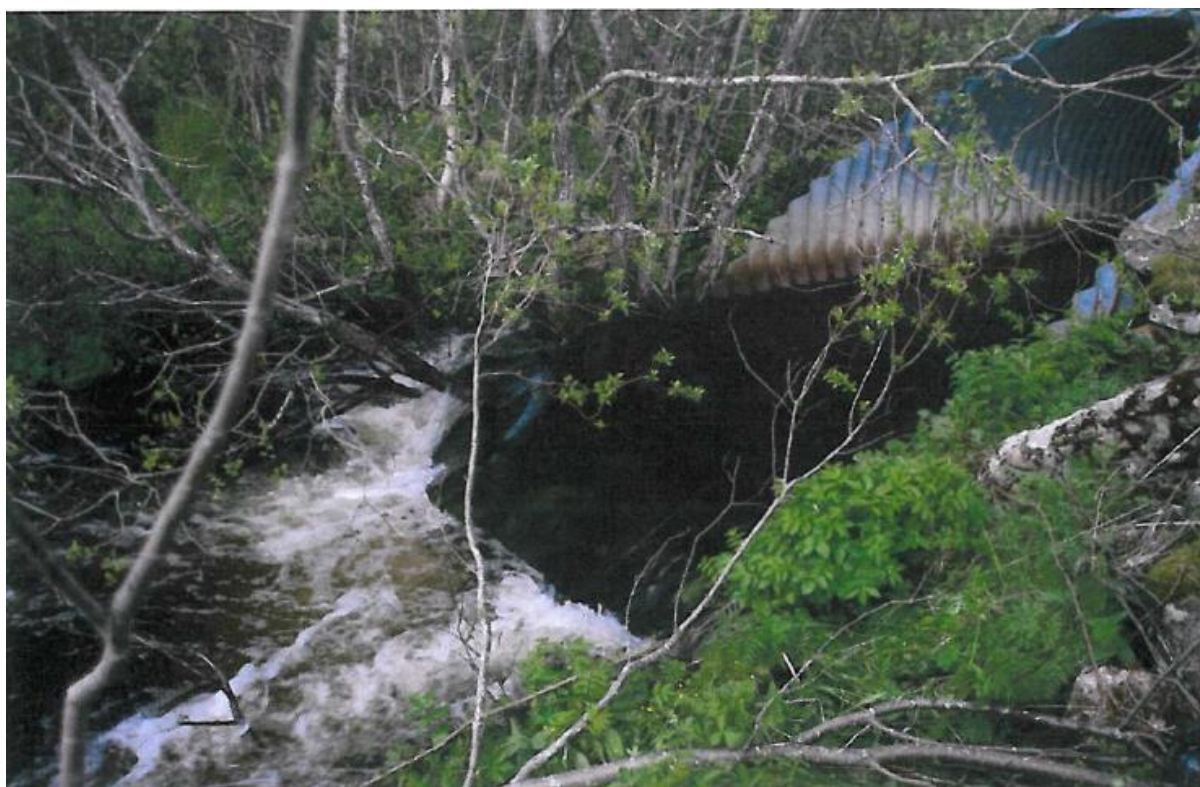
Fig. 62. Fall ved utløpet av svalbardrøret i Vågeelva (Foto: Kenneth Fox).
