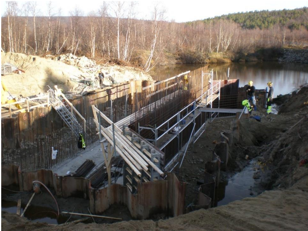
Fig. 81. Støping av betongkulvert i Savkadasjohka (Foto: Haile Garmann Hansen).
