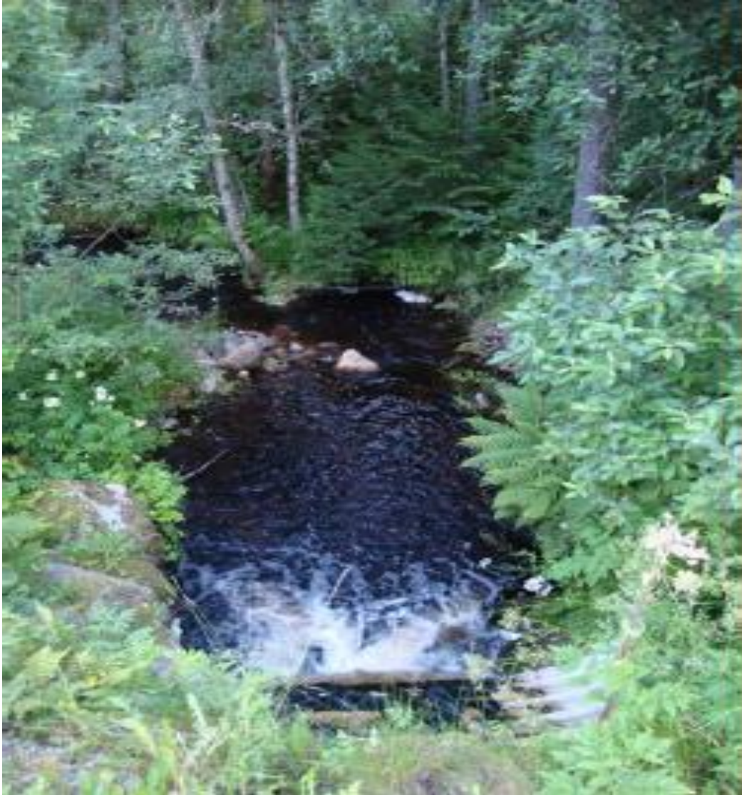
Fig. 49. Kulp nedstrøms kulvertutløpet. Rundt bekken finnes frodig kantvegetasjon (Foto: Statens vegvesen Region midt).
