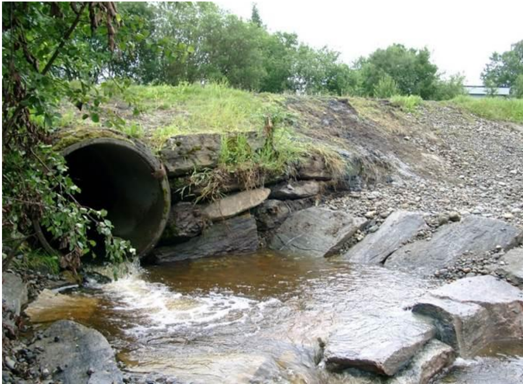
Fig. 55. Nedstrøms kulvertutløpet i Hamremselva med terskelen til høyre i bildet (Foto: Statens vegvesen Region midt).
