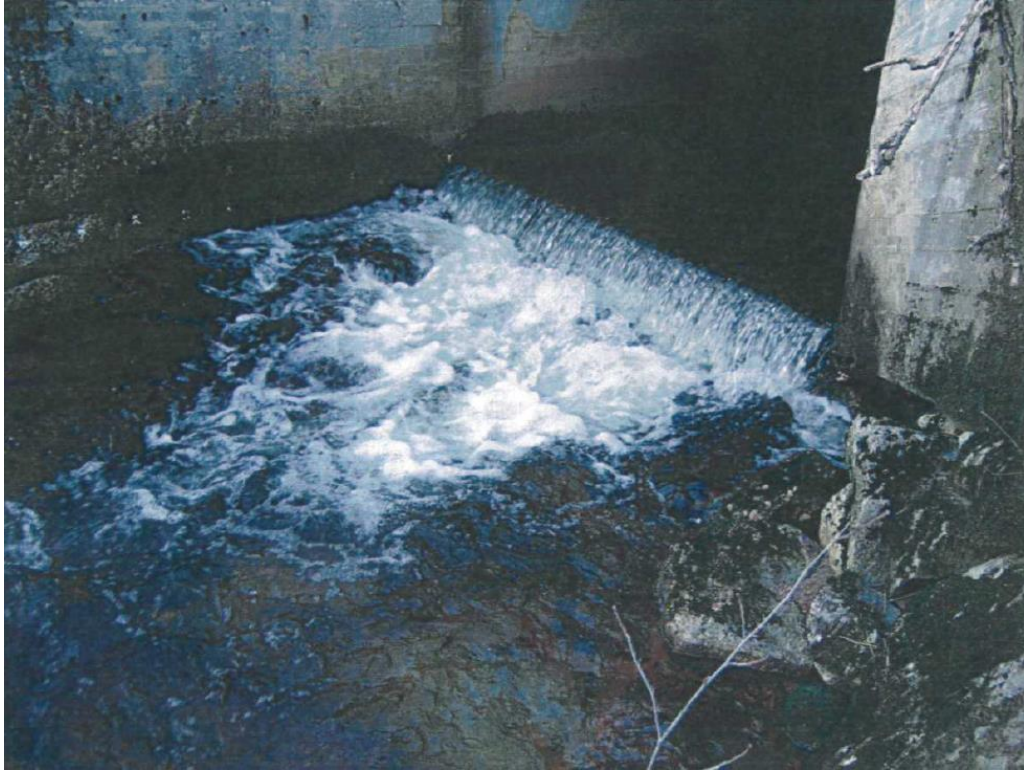
Fig. 45. Spranget ved utløpet av kulverten i Breibekk (Foto: Alf Magne Midtbø Versland).
