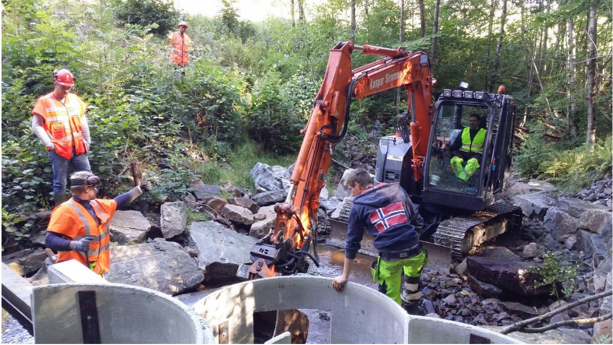
Fig. 41. Plassering av betongringene ved utløpet av kulverten i Sævelibekken (Foto: Paul Ridola).
