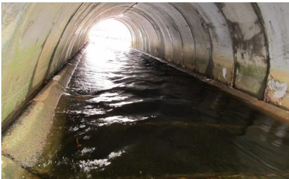
Fig. 59. Kulvert med flat bunn og høy hastighet på vannet gjennom kulverten (Foto: Øyvind Haugland).
