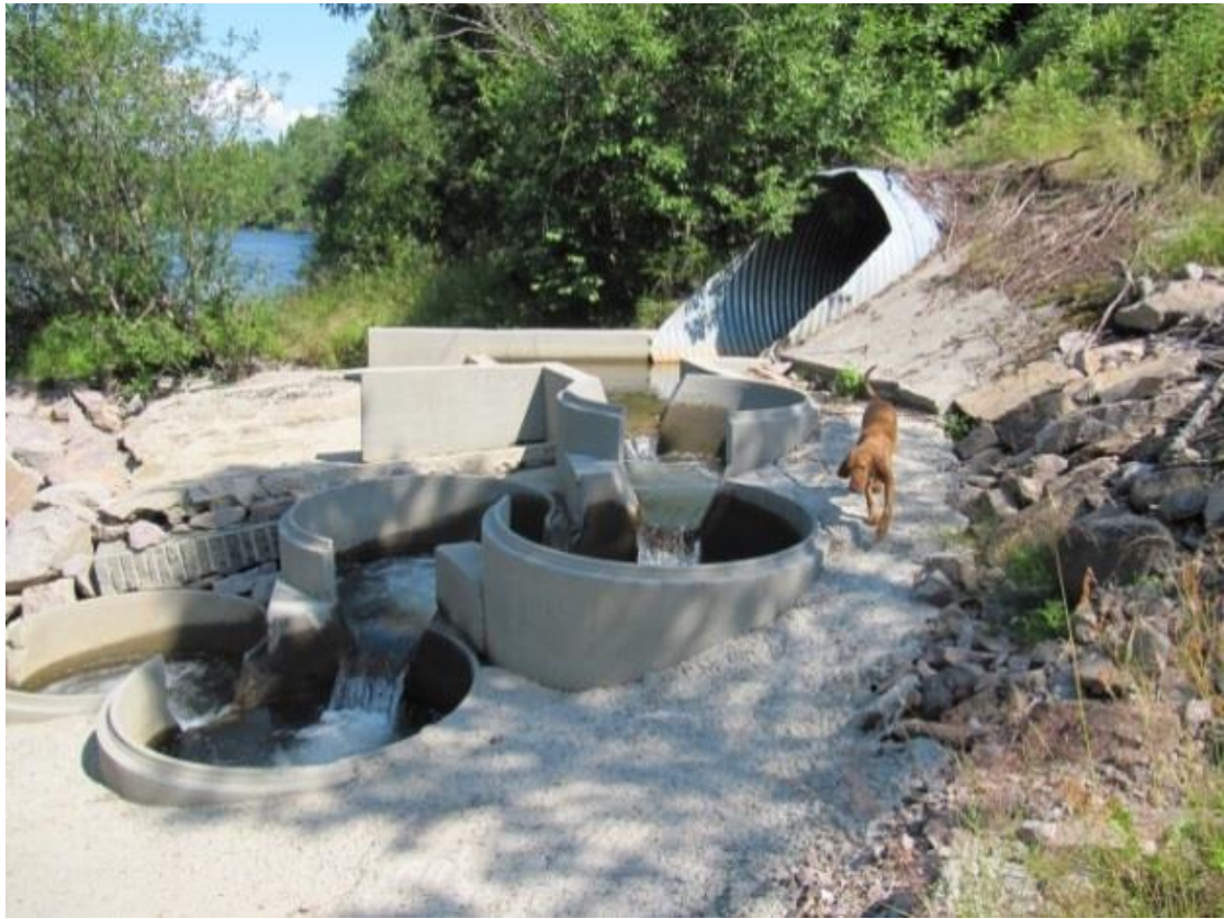
Fig. 30. Betongringer med åpning montert nedstrøms kulvertutløp (Foto: Sigrun Børresen).
