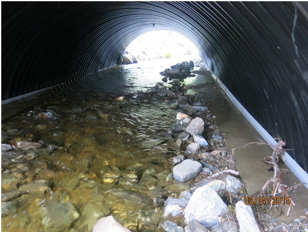
Fig. 71. Hvelvkulverten har naturlig elvebunn og gode vandringsforhold for fisk (Foto: Lars Aage Gade-Sørensen).
