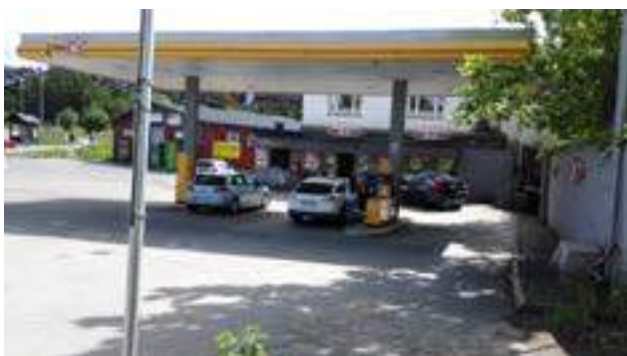
Foto av eksisterende situasjon ved bensinstasjon og kiosk.
