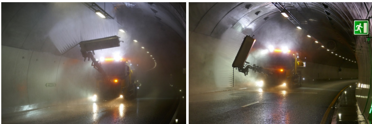
Figur 10: Spyling av tak, armatur og vegg med vaskebil (Foto: Brynhild Snilsberg)
