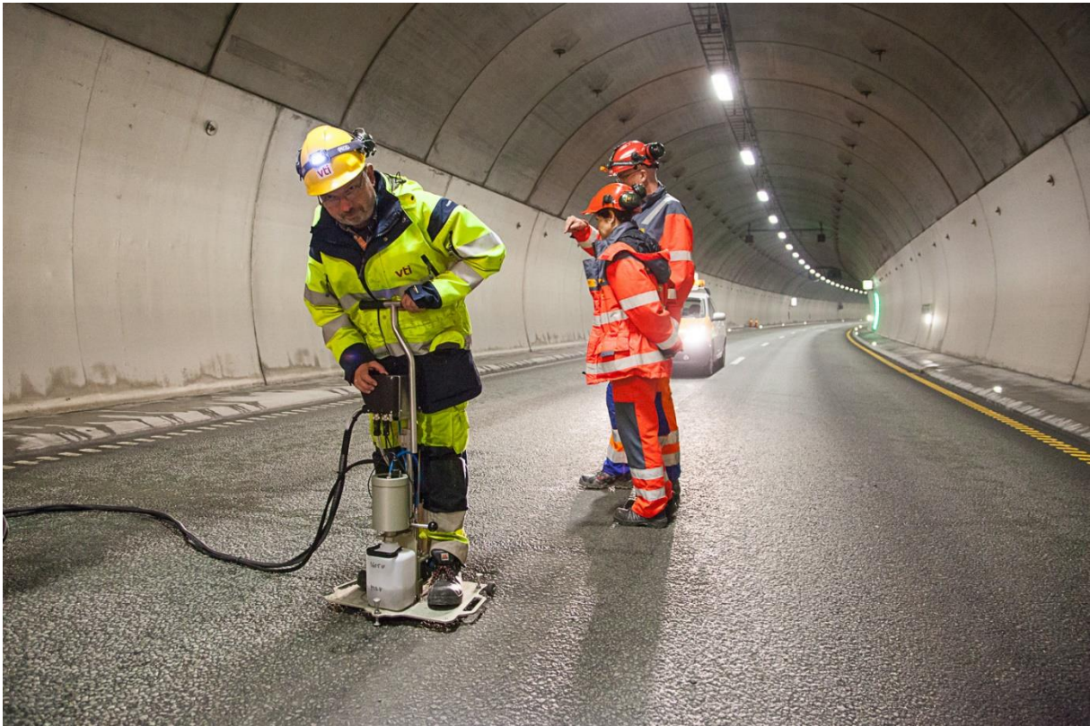
Figur 4. WDSII-provtagning i Strindheimtunnelen. Foto: Mats Gustafsson, VTI.
