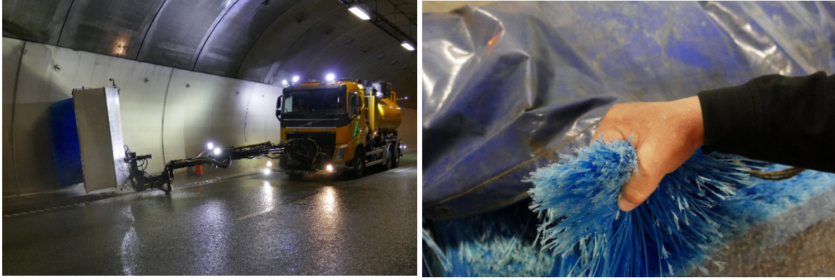
Figur 11: Børsting av tunnelveggene med roterende kost (Foto: Brynhild Snilsberg)
