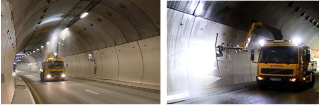
Figur 9: Såpepålegging av armatur/tak og vegg (Foto: Brynhild Snilsberg og Ellinor Hansen)
