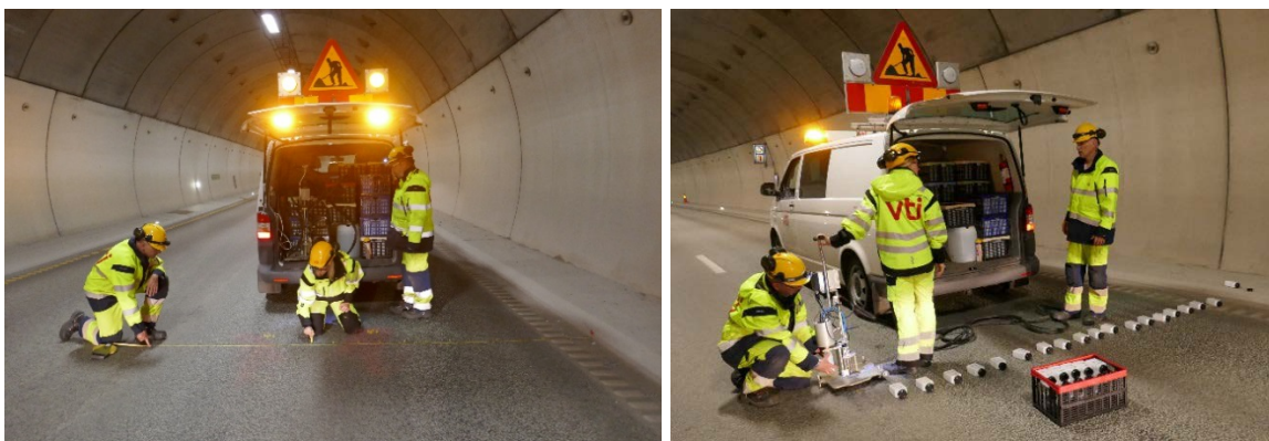
Figur 32: Prøvetaking av støv hver 10. cm i tverrsnitt av vegbanen (foto: Brynhild Snilsberg)
