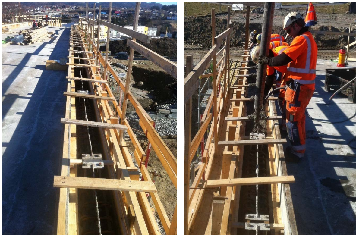
Figur 8 Kantdrager før/under utstøping med pumpe/vibrator
