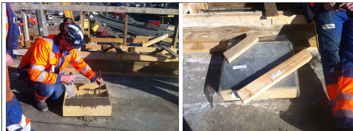
Figur 9 Produksjon og lagring med plastfolie av ferdigstøpte bjelker til bøyestrekfasthet
