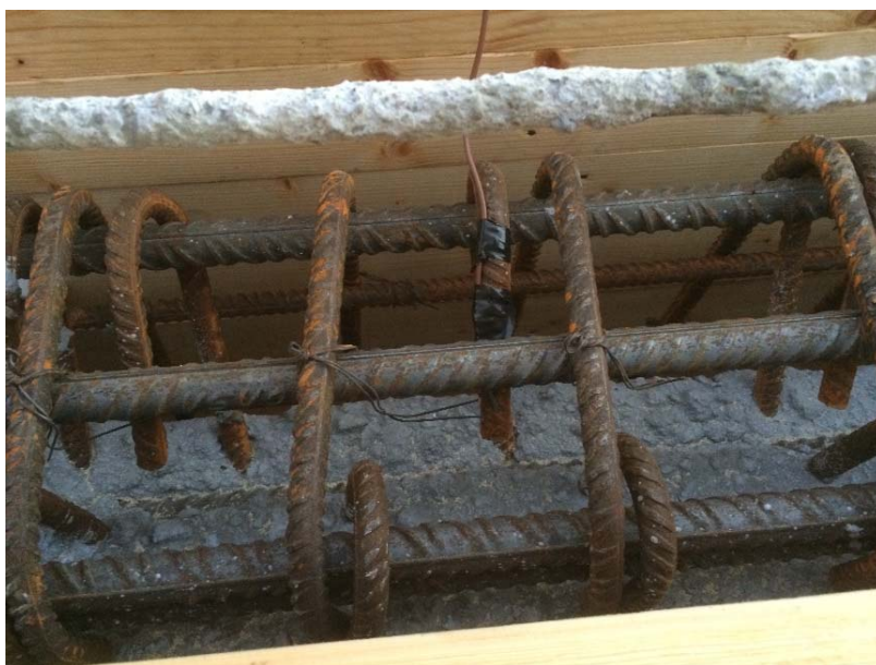
Figur 11 Plassering av termoelement i kantdrager
