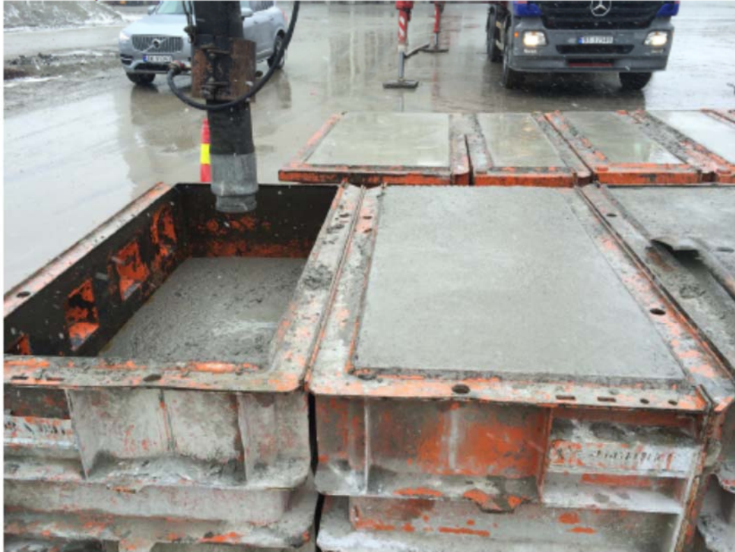
Bilde 2. Fylt støttemursblokk
