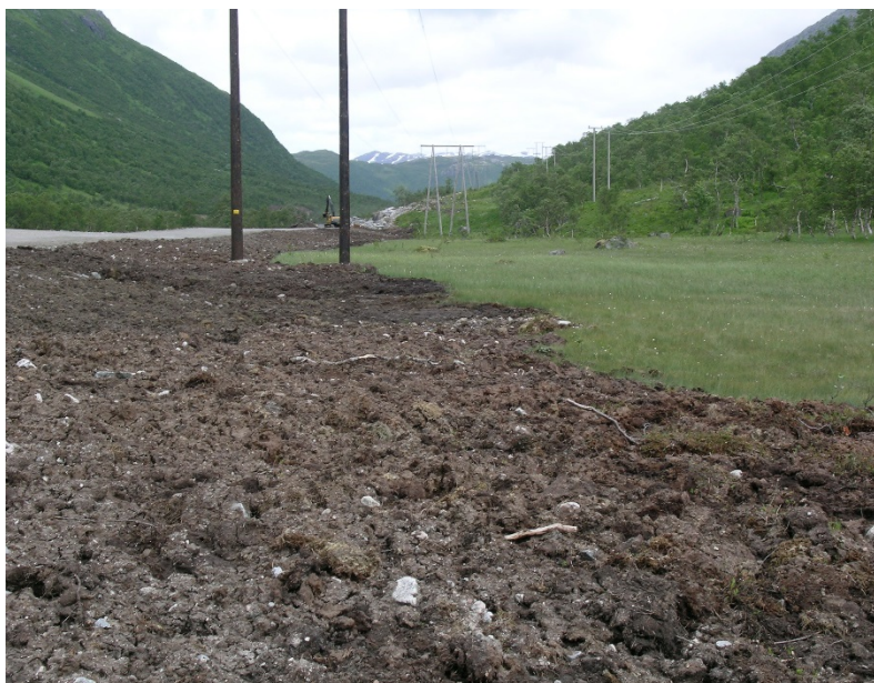
Figur 3. Dersom vegkantene er slake blir inngrepet større. Foto: Astrid Brekke Skrindo
