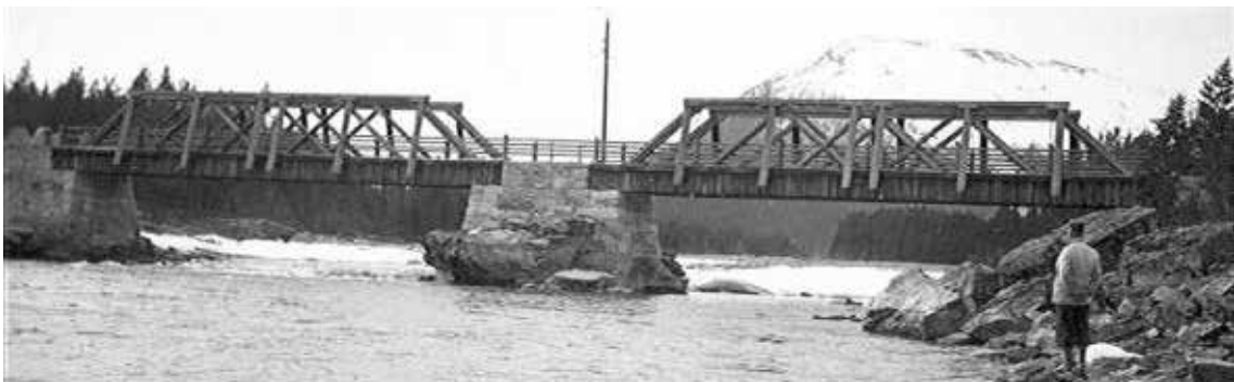
Figur 1-12: Dønfoss bru (1896) over Otta i Skjåk. Bilde fra 1938
