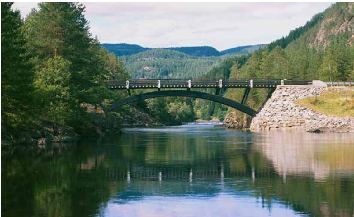
Figur 6-10: Fønhus bru med overliggende brubane Figure 6-10: Fønhus Bridge with elevated deck
