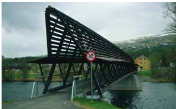
Figur 10-3: Os gs-bru i Østerdalen med taket integrert i bærekonstruksjonen
