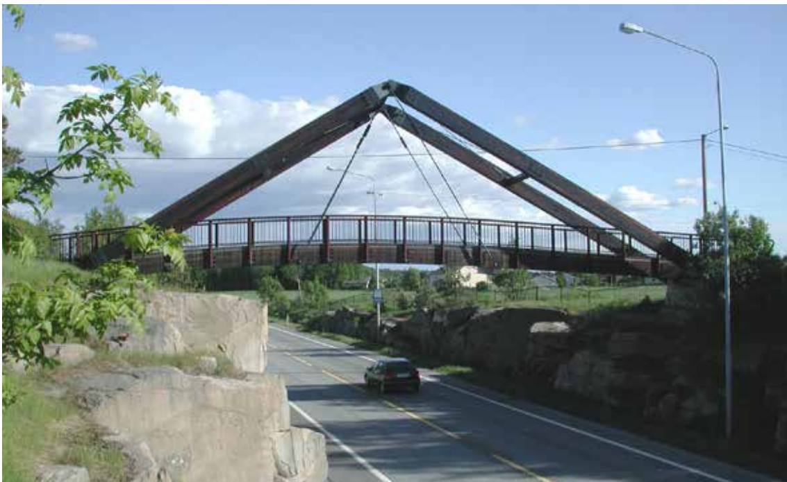
Figur 6-8: Tidligere Årumfjellet GS-bru (1997) er en sprengverkskonstruksjon med underliggende brubane. Spennvidde 26,5 m
