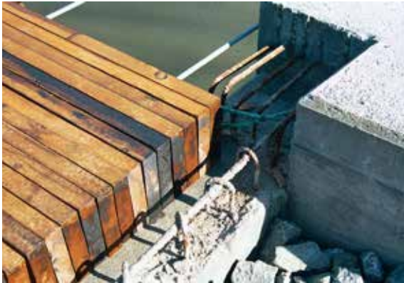
Figur 6-17: Tverrspent dekke på Mølledammen bru Figure 6-17: Stress laminated deck on Mølledammen Bridge
