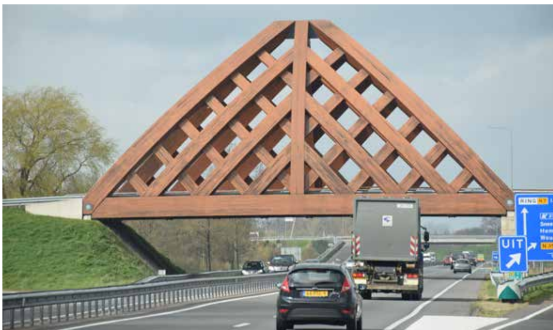
Figur 2-2: Sneek bru ved Sneek i Nederland (2008) laget av acetylert tre (Accoya).
