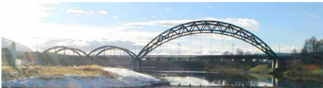
Figur 6-12: Tynset bru over Glåma. Fagverksbue med spennvidde 70 m Figure 6-12: Tynset Bridge over river Glåma. Trussed arch with span 70 m
