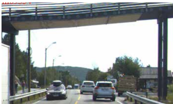
Figur 7-27: Tiltak for å fange opp kreosotdrypping fra brodekkets underside.
