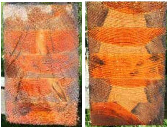
Figur 10-20: Eksempel på full inntrengning av kreosot i en limtrebjelke til venstre og dårlig inntrengning til høyre
