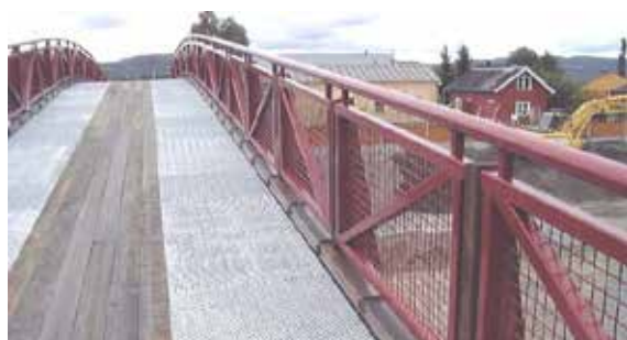
Figur 7-17: Brudekke med innlagte stålrister på Hanskemaker gs-bru
