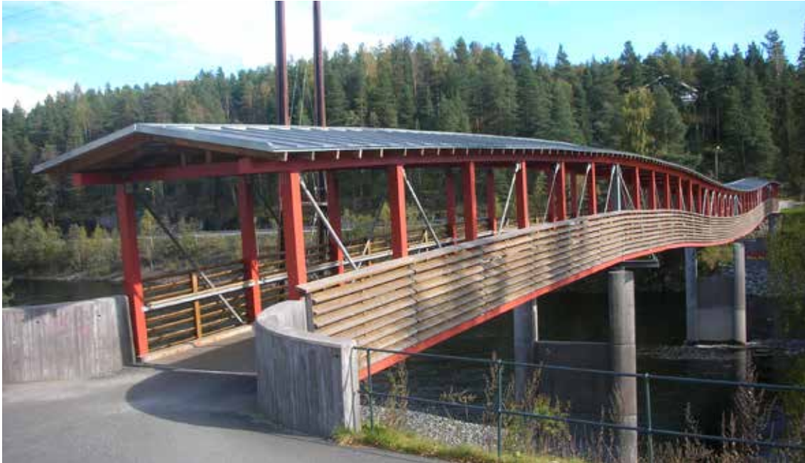
Figur 10-4: Bølgen gs-bru i Kongsberg med taket over bærekonstruksjonen Figure 10-4: Bølgen Footbridge in Kongsberg with the roof covering the the truss
