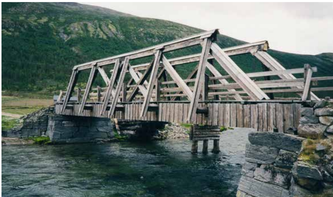
Figur 10-9: Gammel fagverksbru(halvparten av gamle Dønfoss bru, 1896, Figur 1-12) over elven Finna ved Sterringi i Lom slik den sto inntil 2007. Alle bærene deler er gitt en konstruktiv beskyttelse i tre, noe som har sikret brua en levetid på mer enn hundre år.
