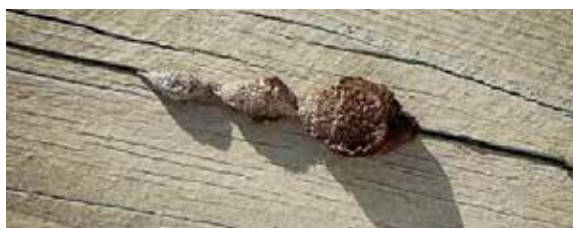
Figur 10-22: Soppen vedmusling (Gloeophyllum sepiarium) oppdaget i en sprekke i buene på Leonardo da Vinci bru. Figure 10-22: The fungus Gill Polypore (Gloeophyllum sepiarium) discovered in a fissure in the arches of the Leonardo da Vinci bridge.
