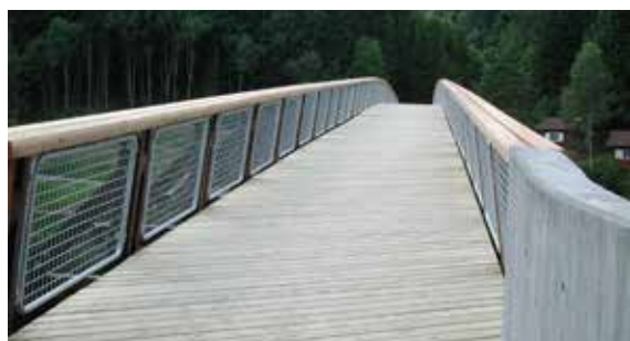
Figur 7-18: Diagonallagt CCA-impregnert plankedekke på Kjærra bru
