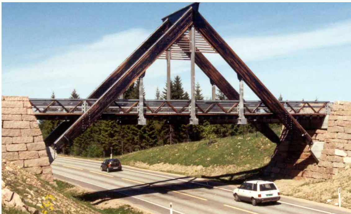
Figur 6-9: Beston bru – et spregverk med avstivningsrammer i stål for sideveis støtte av spregverket Figure 6-9: Beston Bridge – a king post system with steel frames giving lateral support for the strutted frame
