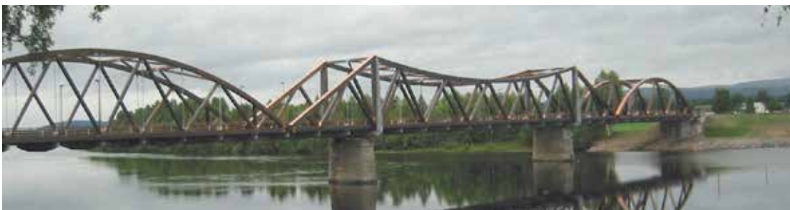
Figur 6-14: Flisa bru over Glomma. Fagverk i Gerber-system. Hovedspenn 70,3 m Figure 6-14: Flisa Bridge over river Glomma. Gerber system truss. Main span 70,3 m
