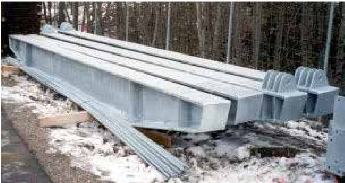
Figur 6-24: Varmforsinkede tverrbærere med ører for feste av hengesøyler Figure 6-24: Hot dip galvanized cross girders with fixing lugs for suspension post attachment
