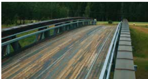
Figur 7-16: Skubbersenga bru med slitelag av kreosotimpregnert plank og med stål brøyteavvisere
