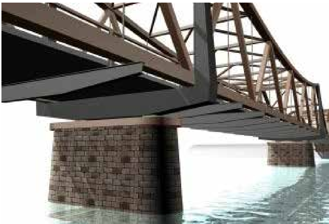
Figur 6-32: Flisa bru, et eksempel på en ny trebru på gamle fundamenter som erstatter en gammel, smal stålbru (Norconsult)
