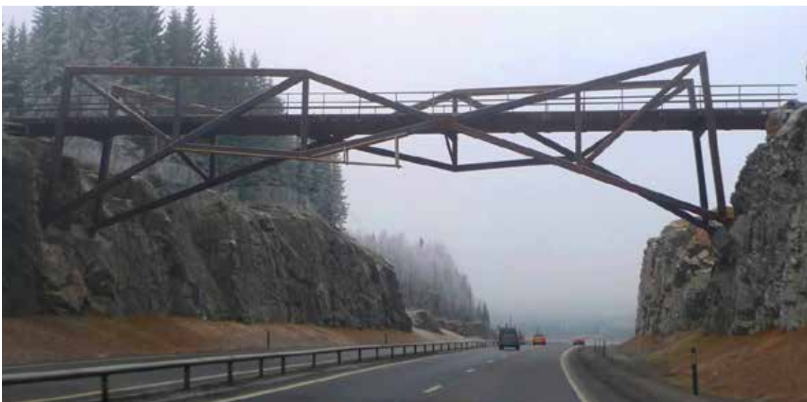
Figur 12-2: Statsrådvegen bru over E6 i Eidsvoll der fagverksstaver ble byttet ut uten at brua ble tatt ned. Figure 12-2: Statsrådvegen bridge across E6 in Eidsvoll where truss members were exchanged without the bridge being taken down.
