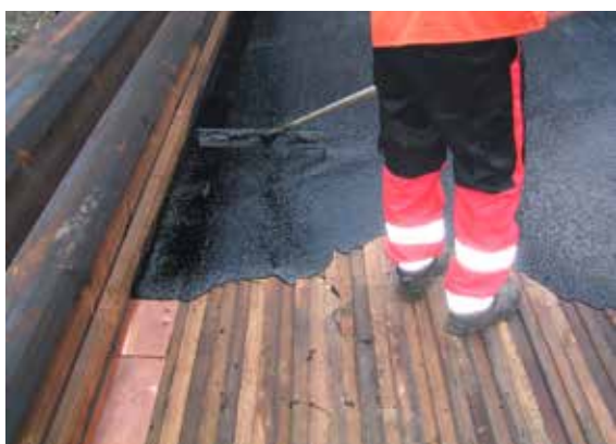
Figur 7-20: Legging av Topeka som fuktisolering. Figure 7-20: Placing of Topeka as dampproof membrane.
