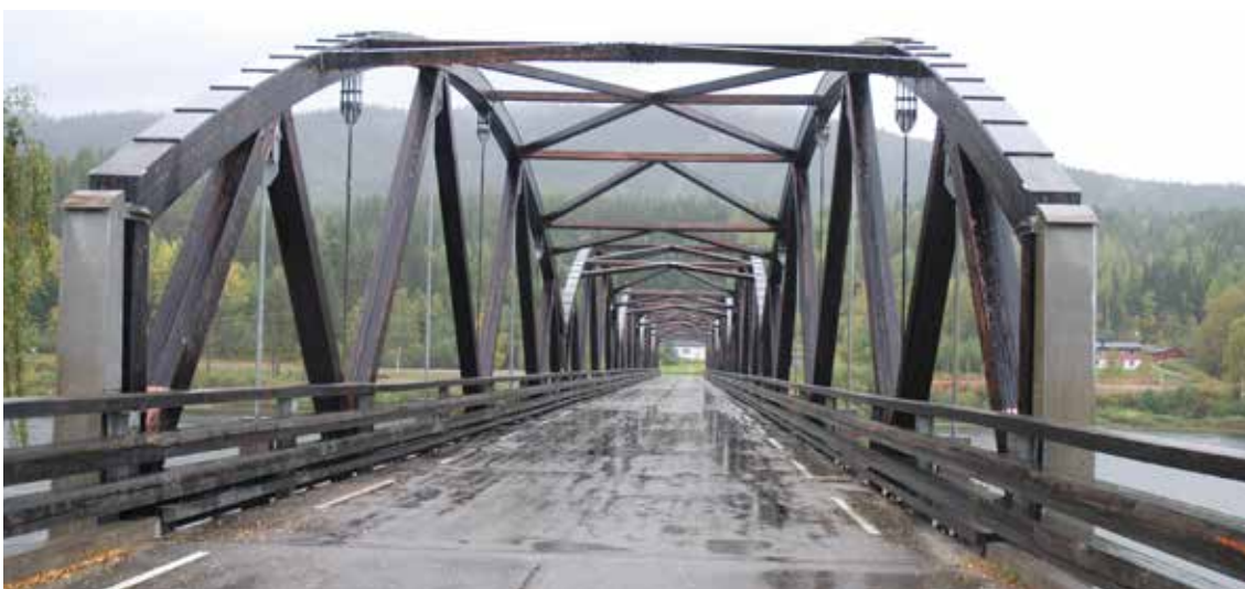
Figur 6-30: Evenstad bru med overliggende vindfagverk Figure 6-30: Evenstad Bridge with elevated wind bracing
