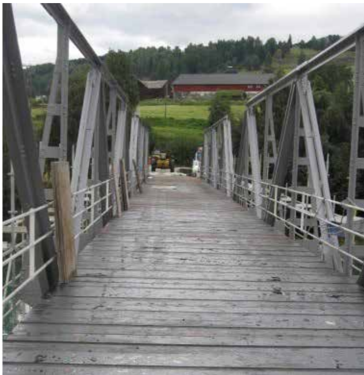
Figur 6-22: Hundorp bru med nytt dekke av kreosotimpregnerte massivtreelementer.(Sweco)
