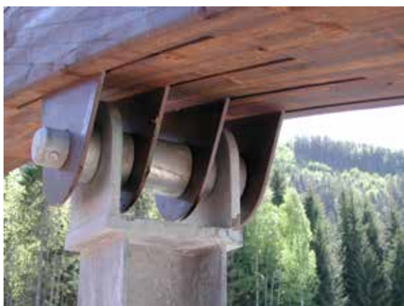
Figur 6-23: Eksempel på innfesting av en hengesøyler
