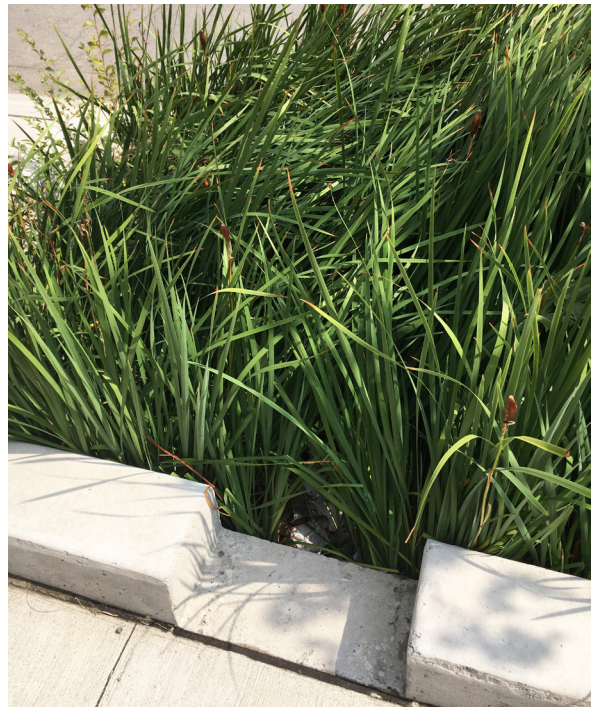
Opphold i kantsteinsrekken er en mye brukt løsning i andre land, men er en dårlig løsning der det er behov for brøyting
