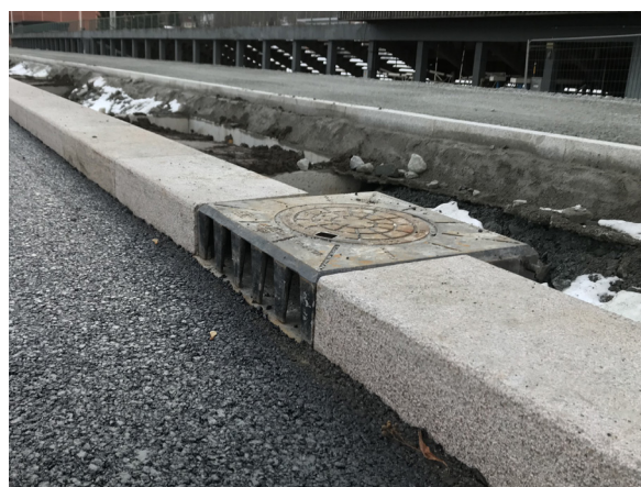
Kjeftsluk under montering i Bjørnstjerne Bjørnsons gate
