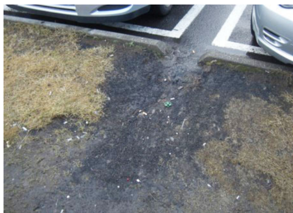
Vannbrettet skal hindre erosjon der vannet kommer inn i siderabattene (Foto: Ukjent)
