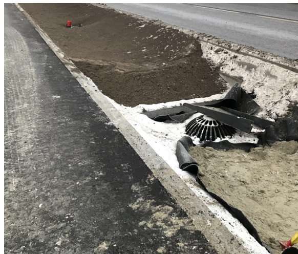
Regnbedjord under utlegging. Den lyse jorda er underlagsjord, mens den mørke er toppjord
