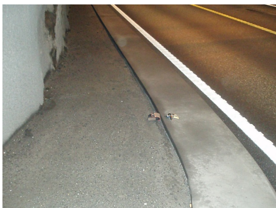
Figur 23: Åkrafjordtunnelen på E134 har kombinert dreneringsrenne og oppsamlingsareal mot veggen.
