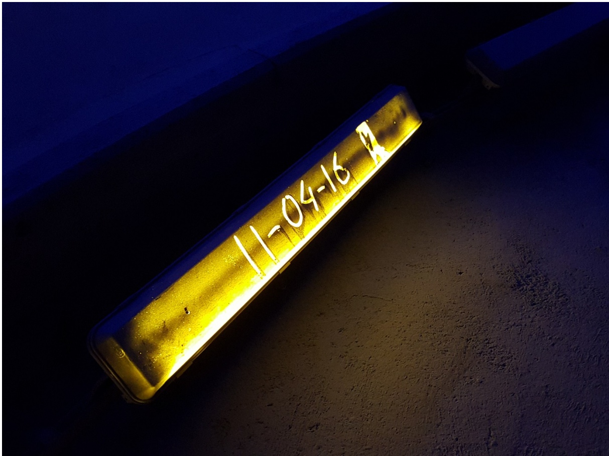
Figur 70: Lysarmatur som vender oppover bør kanskje ha anlegg for automatisk spyling med trykkluft?
