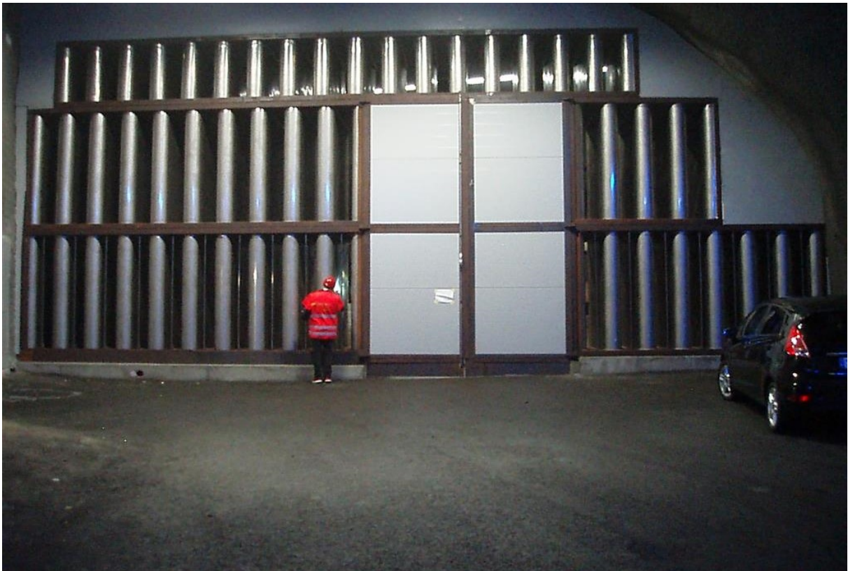
Figur 116: Det vart teke støvprøver i nivå frå 0,5 – 4,5 m i lydfellene mellom tunnelen og avtrekkssjakta
