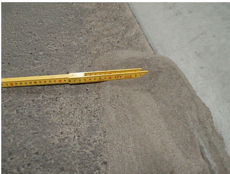
Figur 25: Eksempel på lagerplass for fin sand mot kantstein og på den bakre delen av todelt sideareal (Rv. 5 Støylsnestunnelen)
