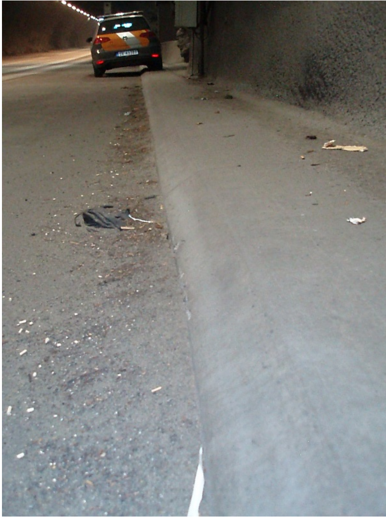
Figur 24: Bømlaffjordtunnelen som vart opna 28.12.2000, har sideareal av betong
