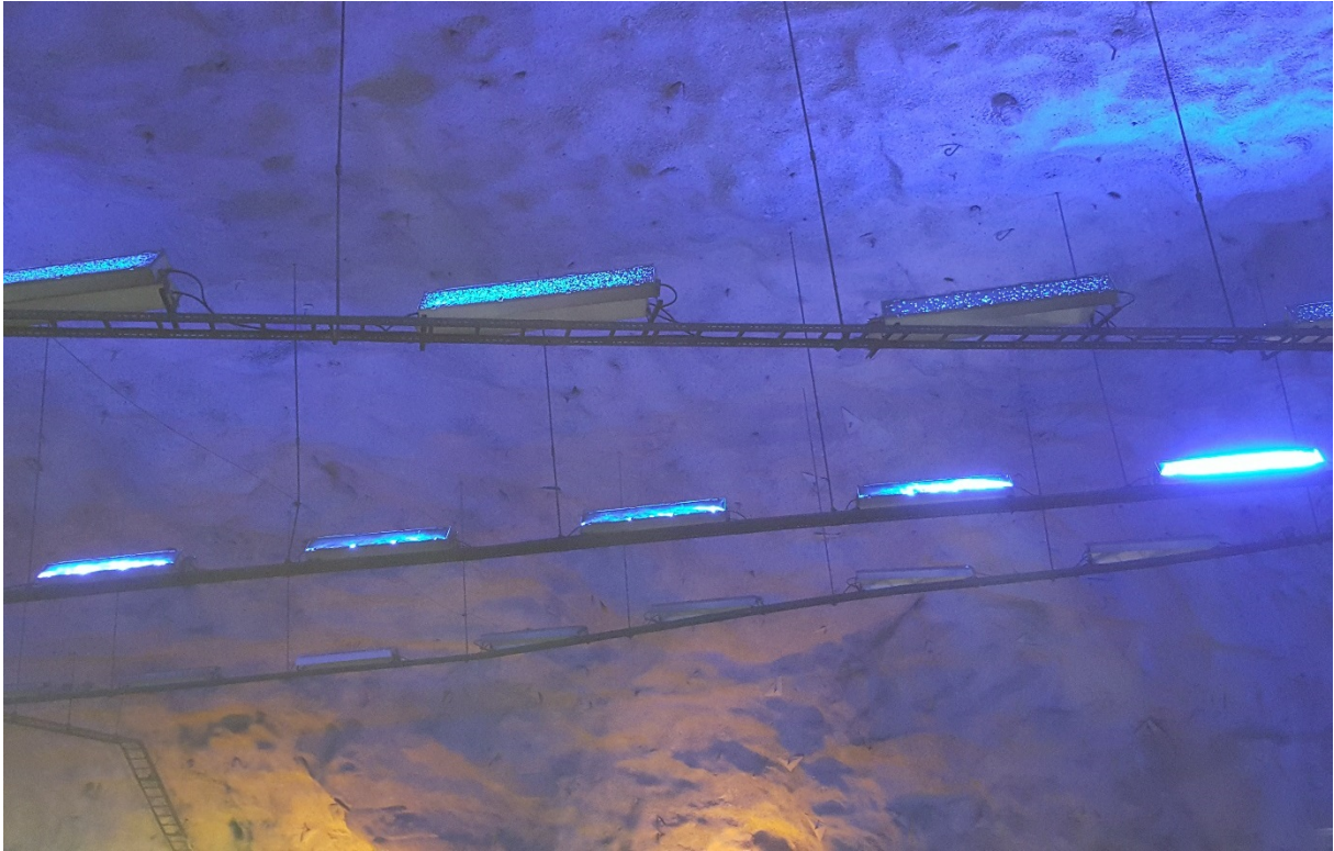
Figur 68: Støvsamling på flater som vender oppover i utvida tunnelverrsnitt (pga. redusert trekk)
