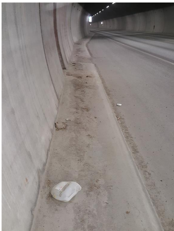
Figur 146: Eksempel på støvlagring i 90 m lang havarinisje (E16 Vangstunnelen)
