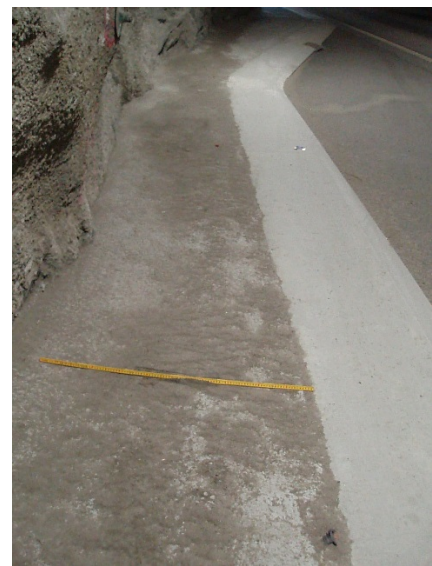
Figur 25: Eksempel på lagerplass for fin sand mot kantstein og på den bakre delen av todelt sideareal (Rv. 5 Støylsnestunnelen)
