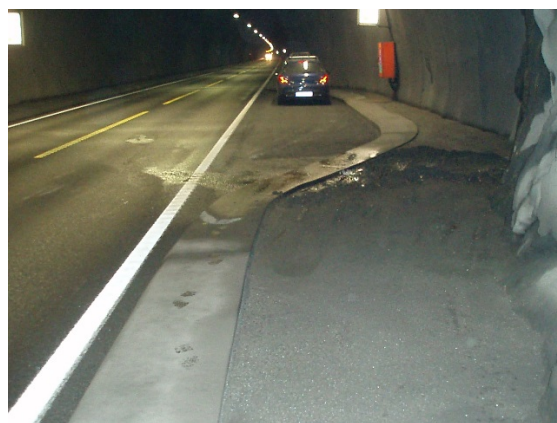
Figur 23: Åkrafjordtunnelen på E134 har kombinert dreneringsrenne og oppsamlingsareal mot veggen.
