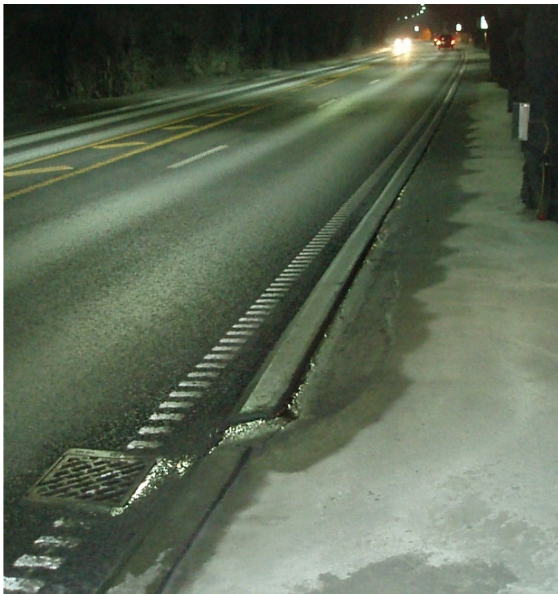
Figur 22: Byfjordtunnelen og Mastrafjordtunnelen har dreneringsrenne bak kantsteinen og lite støv langs kantlinja.
