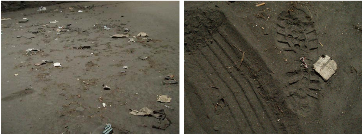
Figur 148: Eksempel på utfelling av søppel og fin sand i snunisje i Bømlafjordtunnelen
