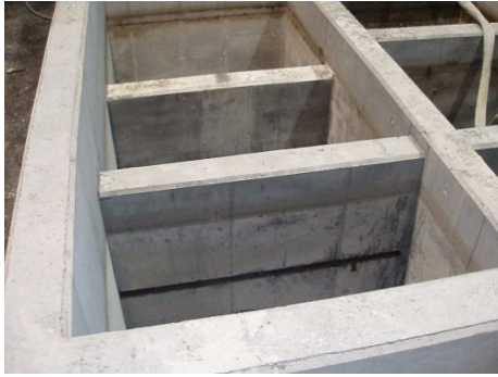
Figur 120: Den smale horisontale spalta mellom kummane gjev så liten turbulens at det blir liggjande igjen sand
