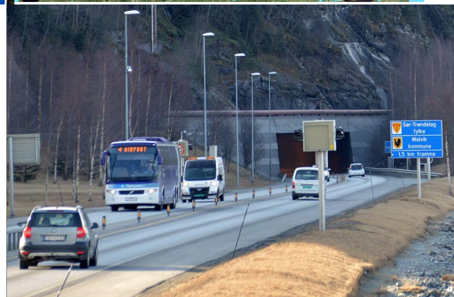
Sikkerhetsutbedringene i Helltunnelen i Stjørdal fra våren 2015, mens det for Eggetunnelen i Steinkjer starter fra høsten 2015.
