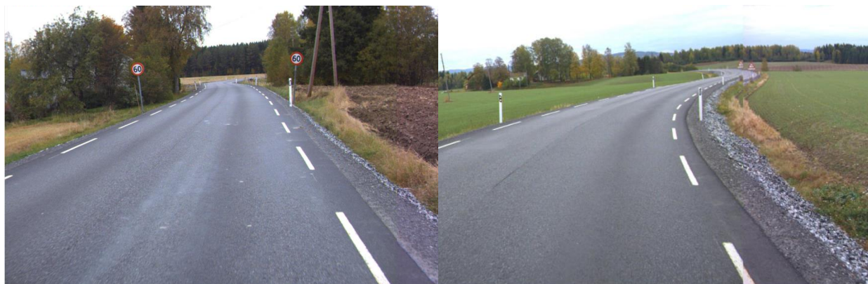
Figur C7 Bilder fra Fv 173 ett år etter utført forsterkning
