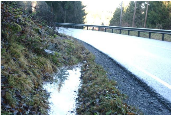
Behov for punktvis utbedring av grøft og grøfteskråning
