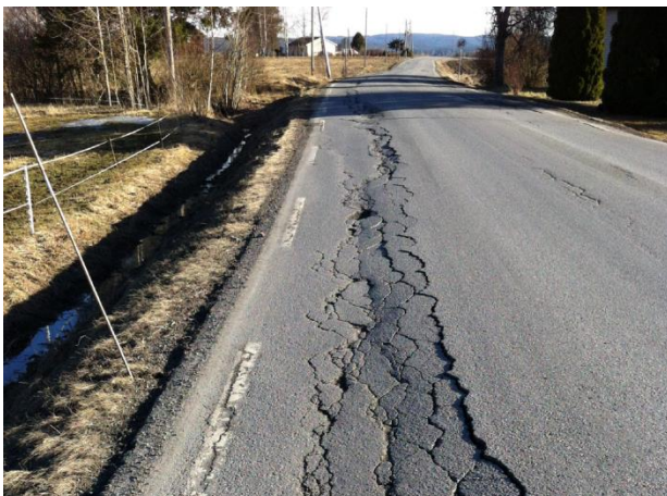
Figur C1 Kantskader Fv 173
