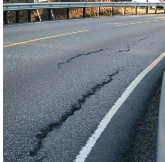
Figur A39 Venstre: Refleksjonssprekker i flatelapping mens asfalten ennå er svart. Høyre: Langsgående sprekker med høydeforskjell er trafikkfarlige
