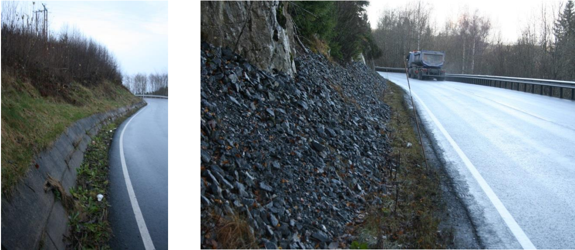
Figur A11 To eksempler på veger hvor tilfredsstillende håndtering av overvannet er en utfordring.
