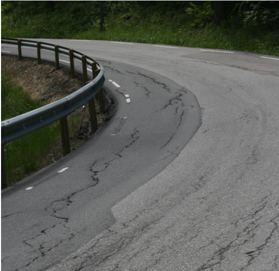
Figur A39 Venstre: Refleksjonssprekker i flatelapping mens asfalten ennå er svart. Høyre: Langsgående sprekker med høydeforskjell er trafikkfarlige
