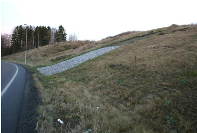
Figur B4 Før vegetasjonen er godt etablert, er veggskråninger særlig utsatt for erosjon og utglidning
