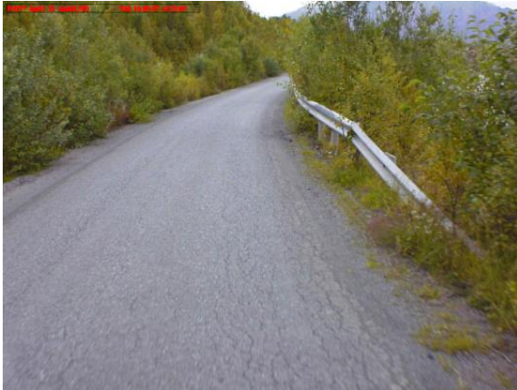
Parti med smårutet krakelering
