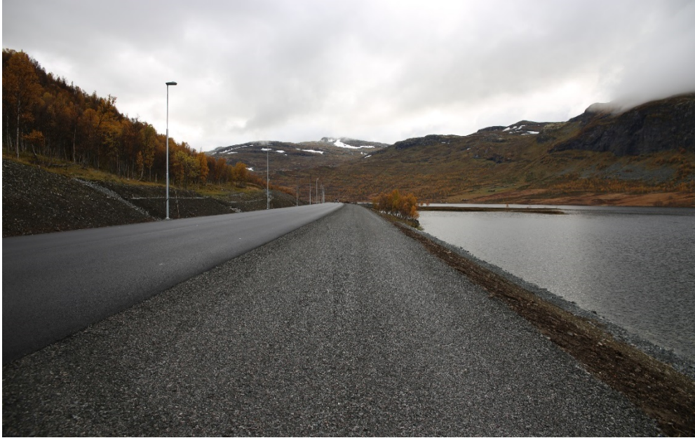
Figur 4-98 Opparbeidet fresegate på fylling på E16 Filefjell. Foto Åsmund Espe, Statens vegvesen
