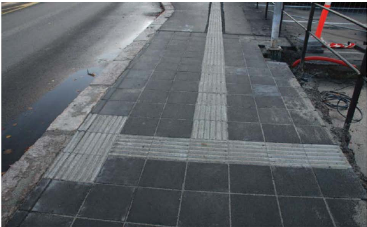
Figur 9-40 Kunstig ledelinje med retnings- og oppmerksomhetsindikator foran et busstopp (Vegdirektoratet 2010)
