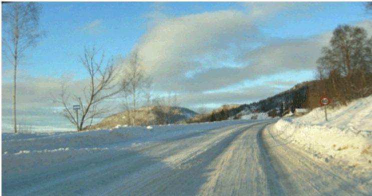
Figur 2-28 Sporete vegbane (Foto: Statens vegvesen)
