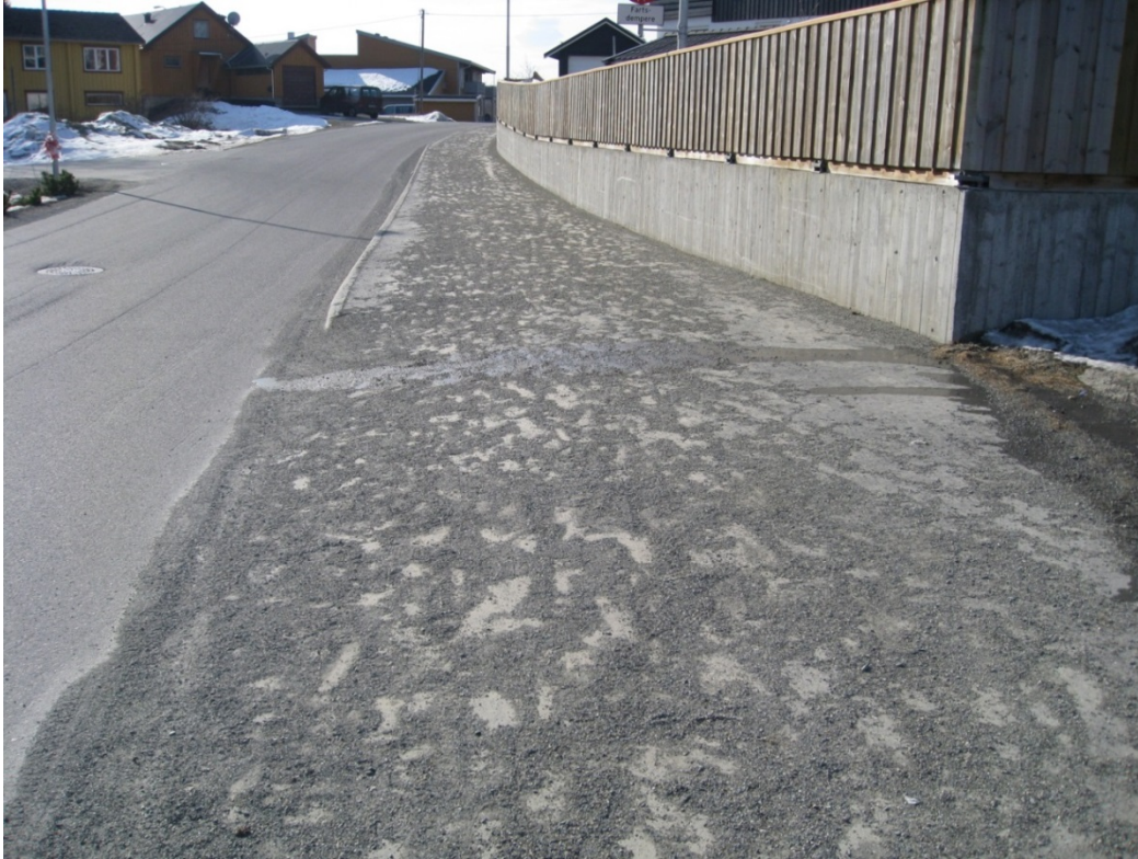
Figur 7-13 Her ligger det strøsand igjen fra hele vinteren. Foto: Øystein Larsen, Statens vegvesen).
