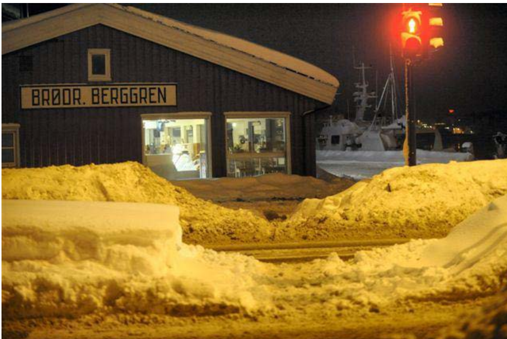
Figur 2-48 Her er det ikke ryddet til trykknappen for signalanlegget (Foto: Veidekke)
