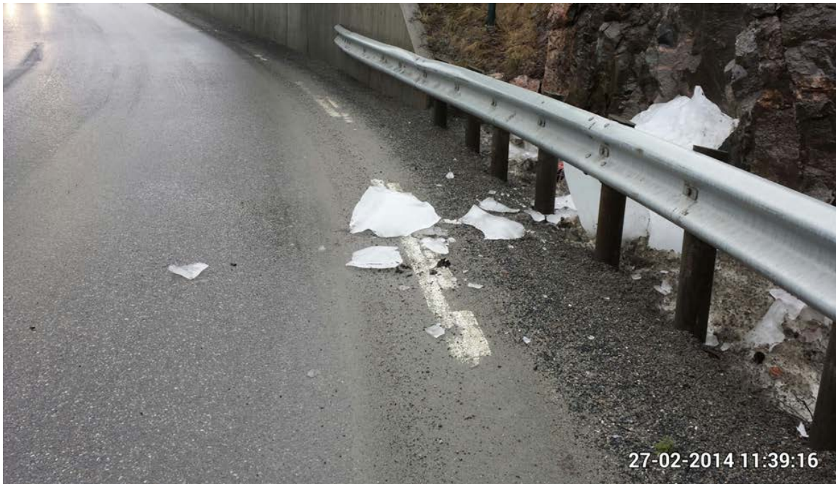
Figur 9-25 Is på vegen etter smelting/ras i skjæring (Foto: Rudi Thomassen)
