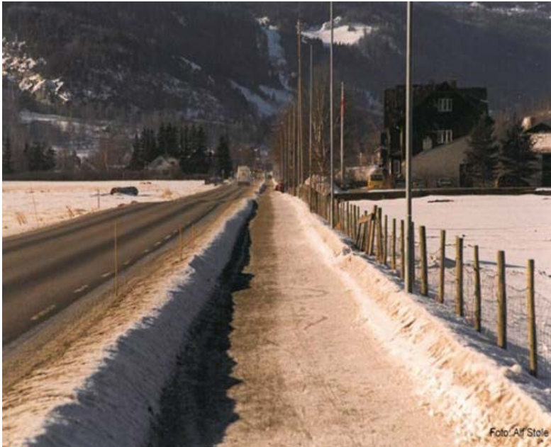
Figur 7-9 Gang- og sykkelveg hvor den ene halvdel er strødd og den andre ikke. Såkalt «sparkstandard». (Foto: Alf Støle, Statens vegvesen).
