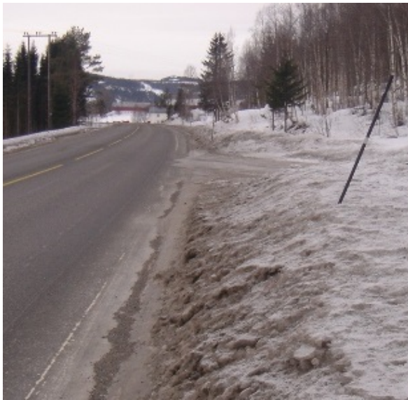
Figur 9-4 Feilaktig plasserte og manglende brøytestikk kan føre til ulykker (Foto: Statens vegvesen)
