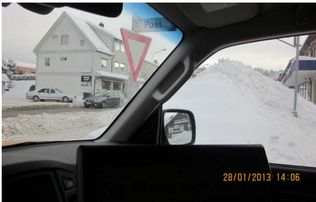
Figur 4-69 Sikt i kryss ikke godkjent! (Foto: Rudi Thomassen, Statens vegvesen)
