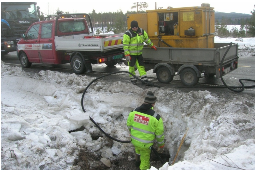
Figur 9-23 Tining av stikkrenne (Foto: Knut Magne Reitan)
