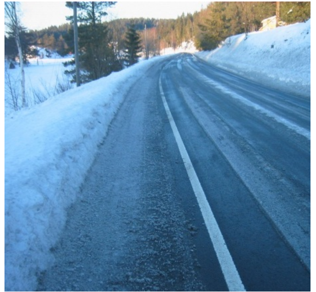
Figur 9-4 Feilaktig plasserte og manglende brøytestikk kan føre til ulykker (Foto: Statens vegvesen)
