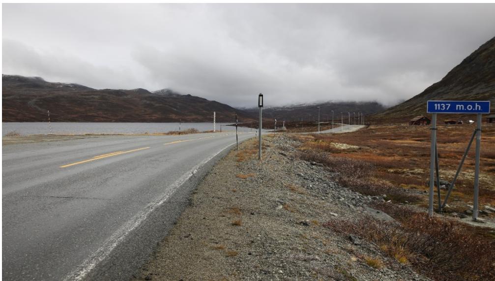
Figur 4-91 Eksempel på permanent brøytestikk. Foto Åsmund Espe
