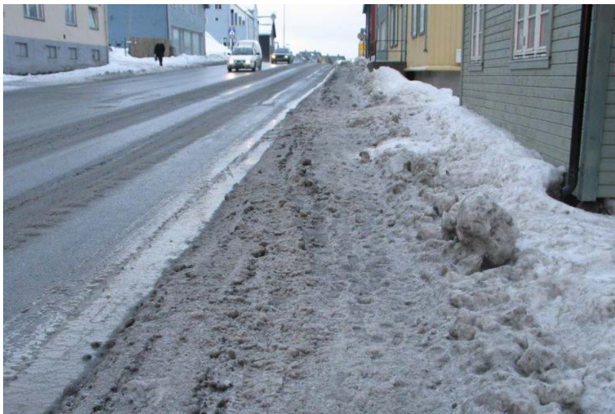
Figur 4-65 Lite attraktivt for gående og syklende. (Foto: Jens Eriksen, Statens vegvesen)
