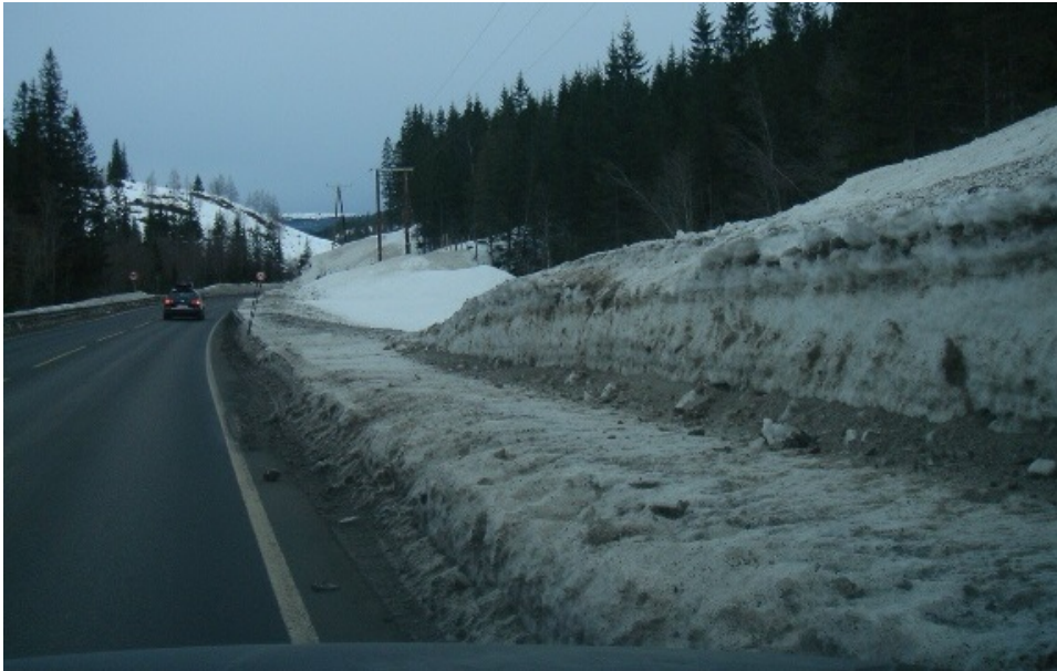
Figur 2-59 Fjerning av høye brøytekanter Foto: Statens vegvesen)
