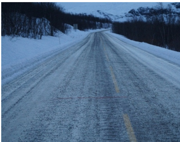
Figur 5-5 Friksjon på veg med isdekke strødd med sand, \mu=0,25-0,35 . (Foto: Bård Nonstad)
