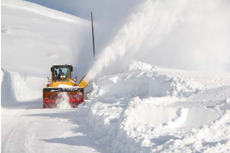
Figur 4-92 Rydding av brøytekanter, rv. 13 Vikafjellet. Foto Sogn Avis
