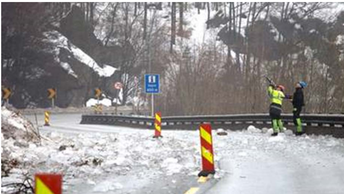
Figur 9-27 Nedtaking av is ved hjelp av skytter. (Foto: fvn.no)
