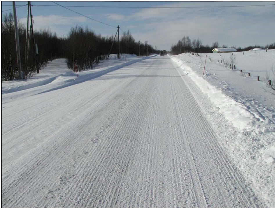
Figur 4-75 Snø- og isdekke etter høvling. Merk manglende utkast av ranke. Dette må gjøres for å hindre nedkjøring og dermed etablering av iskant på skulder. I tillegg bidrar manglende utkast til smalere veg.
