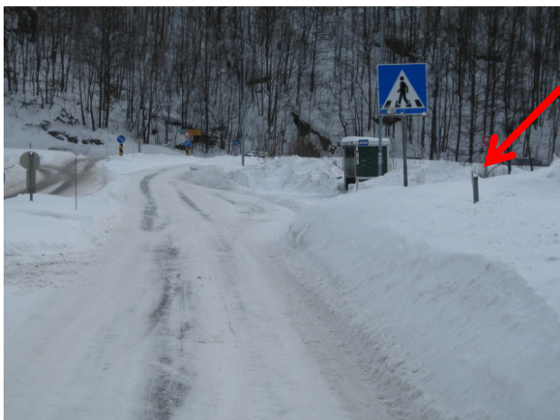
Figur 2-21 Manglende siktrydding mot krysningspunkt på grunn av koblingskap i siktsonen (Foto: Arild Nærum)
