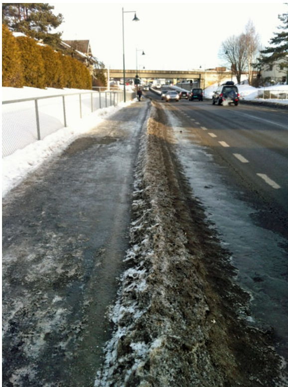
Figur 2-43 Tining og frysing i sykkel-felt
