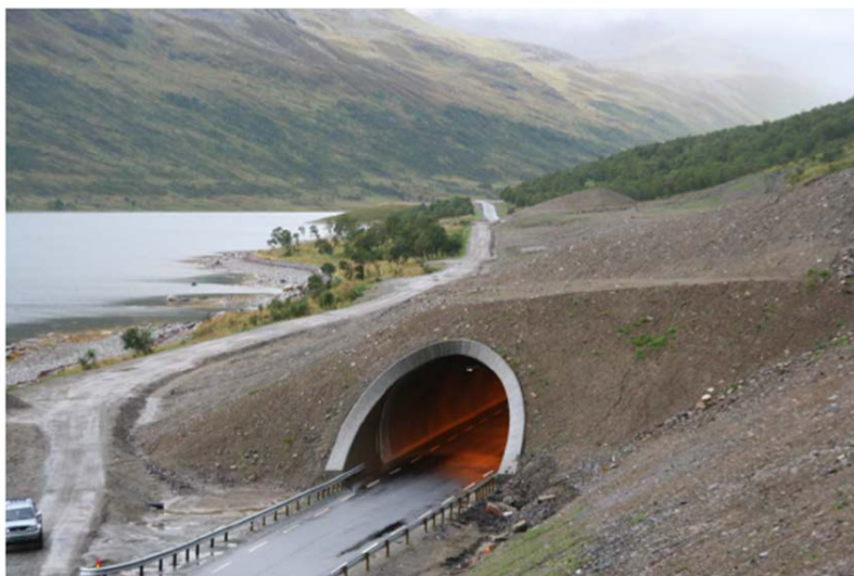
Figur 9-11 Eksempel på skredoverbygg
