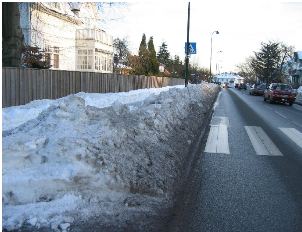
Figur 2-45 Manglende sikt og åpning i brøytekanten
