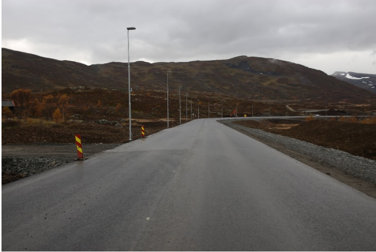
Figur 4-101 Eksempel på ombygd høyfjellsveg med terrengtiltak langs vegen. Foto Åsmund Espe
