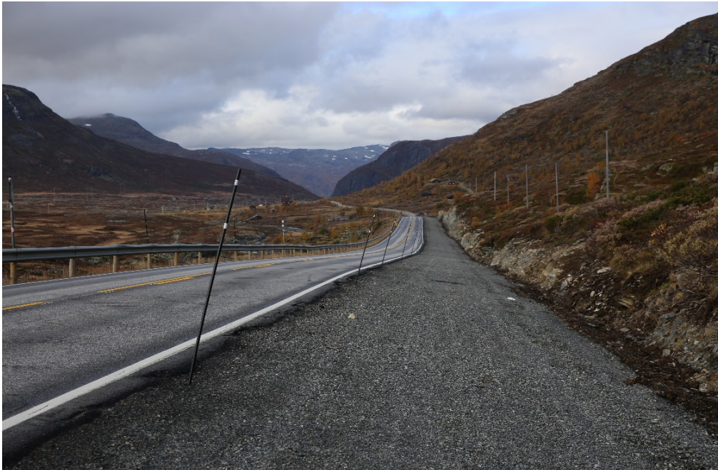
Figur 4-97 Opparbeidet fresegate i skjæring på rv. 52 Hemsedalsfjellet. Foto Åsmund Espe, Statens vegvesen
