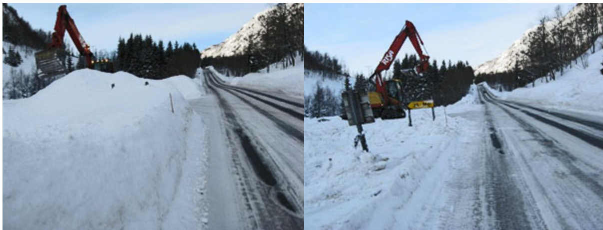
Figur 2-53 Siktrydding med hjulgående gravemaskin (Begge foto: Risa)
