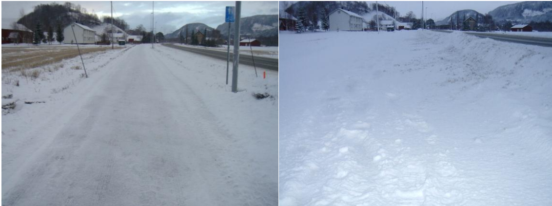
Figur 4-63 Eksempler på godt resultat (til venstre) og dårlig resultat (til høyre) etter brøyting av både hovedveg og g/s-veg
