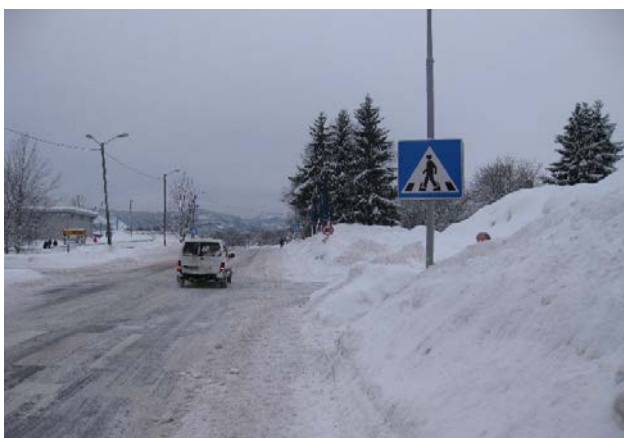
Figur 2-50 Manglende siktrydding til krysningspunkt over hovedveg (Foto: Pål H. Paulsen)
