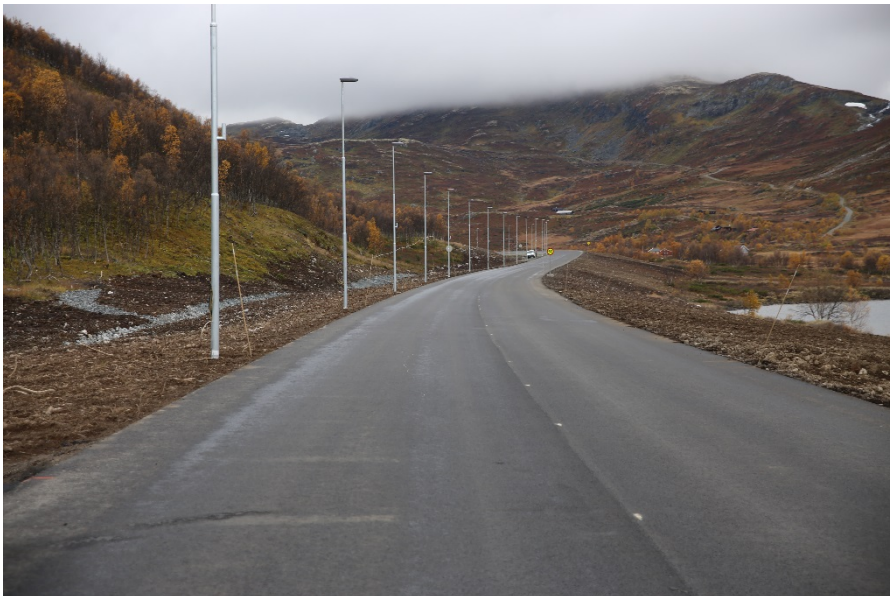
Figur 4-99 Vegbelysning på E16 Filefjell. Foto Åsmund Espe, Statens vegvesen
