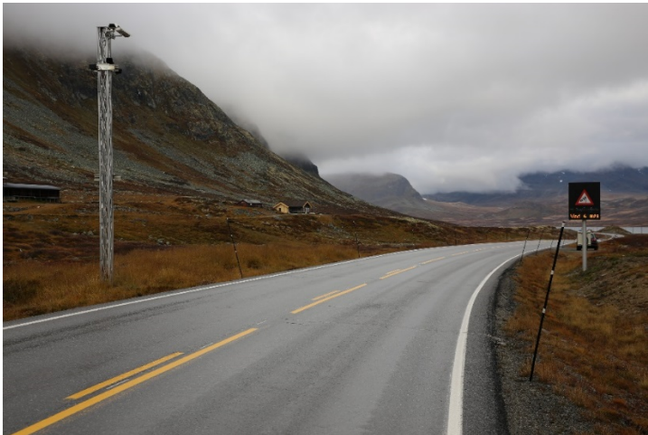
Figur 4-100 Værstasjon og vindtavle. Foto Åsmund Espe
