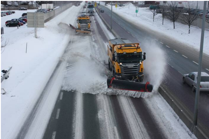
Figur 4-56 Eksempel på tandemkjøring (vær obs på snøsprut på motgående trafikk) (Foto: Statens vegvesen)
