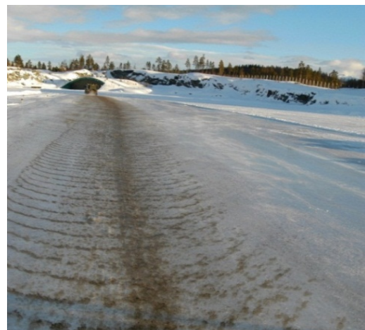
Figur 5-6 Fastsand på isdekke, \mu=0,30-0,50 . (Foto: Giselle Jensen, Statens vegvesen.)
