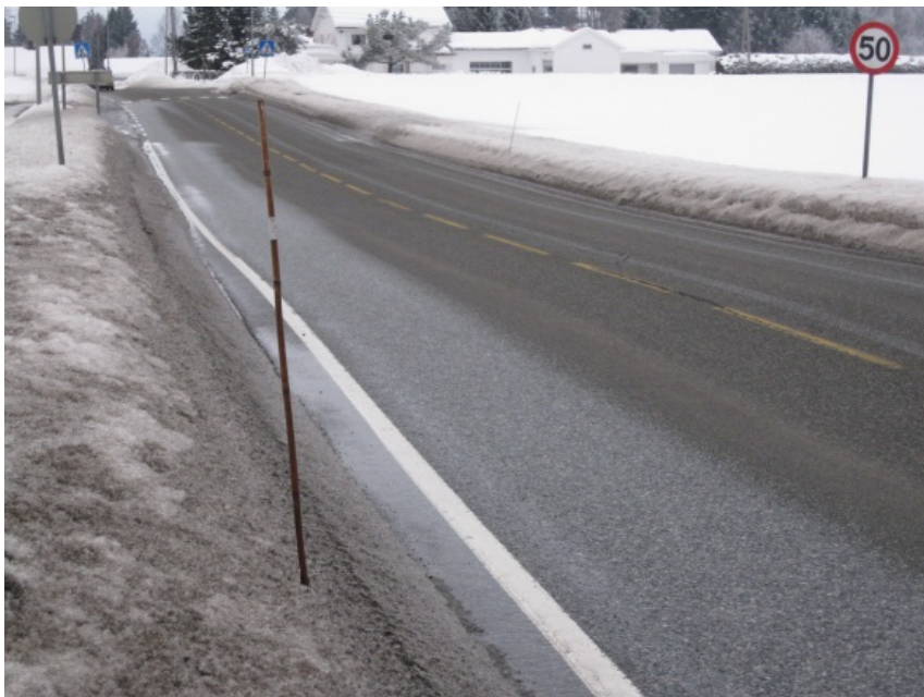
Figur 9-3 Riktig utsetning av brøytestikk er viktig for gjennomføring av vinterdrift (Foto: Statens vegvesen)
