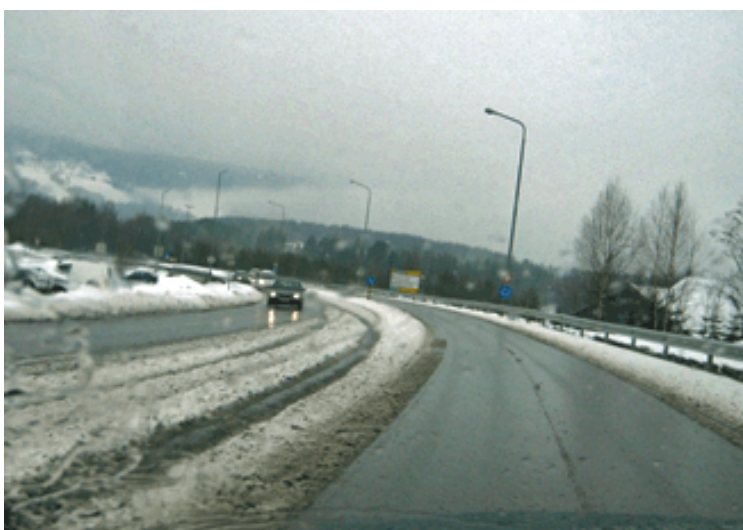
Figur 2-29 Dårlig brøytet forbigjøringsfelt (Foto: Statens vegvesen)
