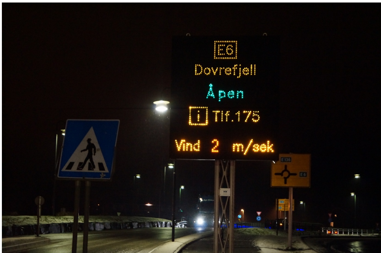
Figur 4-95 Vindvarslingsskilt plassert på E6 i Dombås før Dovrefjell. Foto Bård Nonstad, Statens vegvesen.
